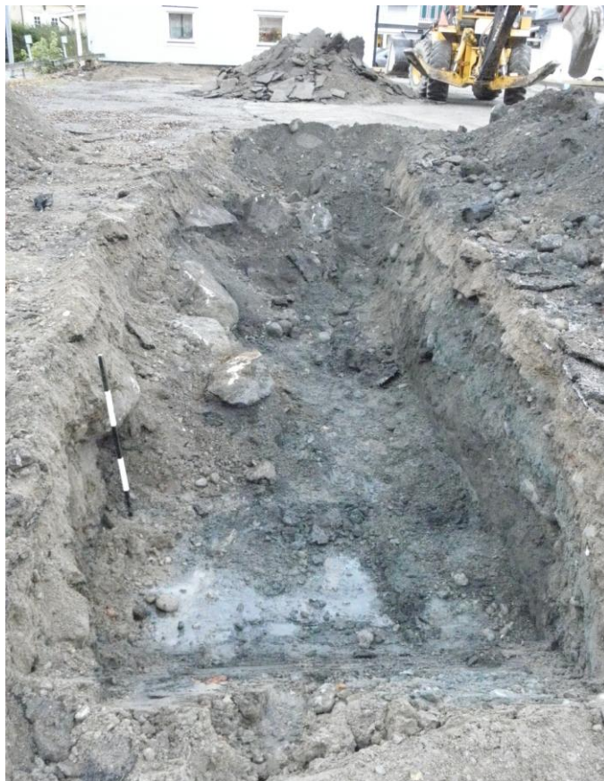
Figur 5. Schakt 2 (OS166), med löst liggande stenar från husgrund i utfyllnadslager. Foto mot nordväst av Ellinor Larsson.
