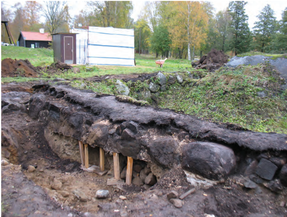
Figur 12. Den västra muren utsida, motsvarande sektion 2 vid ca 0–8 meter (se figur 11). Fotograf från sydväst av Jonas Ros.
