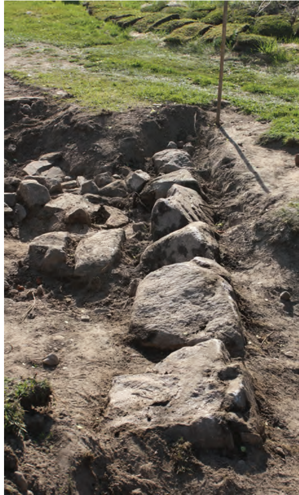
Figur 78. Delar av syllstensraden A3 tillhörande Hus II. Fotograferat från öster av Jonas Ros.
