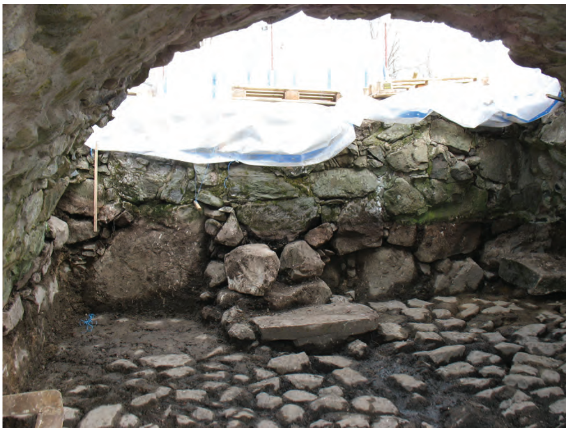
Figur 38. Den norra invändiga muren i östra rummet, motsvarande sektion 7 vid 6–10,5 meter (se figur 36). På golvet ses en stor sten med en flat oavsida som bedöms utgöra delar av rasmassorna från byggnaden. Fotografi från söder av Jonas Ros.
