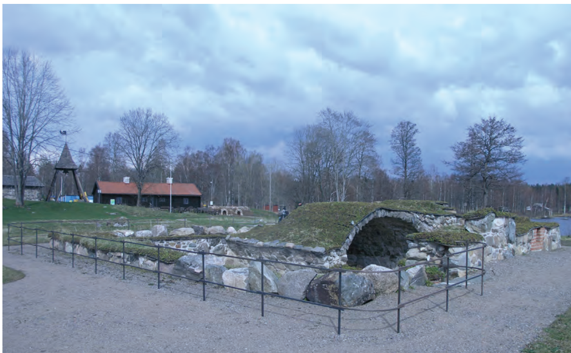
Figur 47. Dubbelkällaren efter att den rekonstruerats. I bakgrunden ses Tegeln och Kalkugn 1 rekonstruerade. Fotografi år 2012 från sydväst av Jonas Ros.
