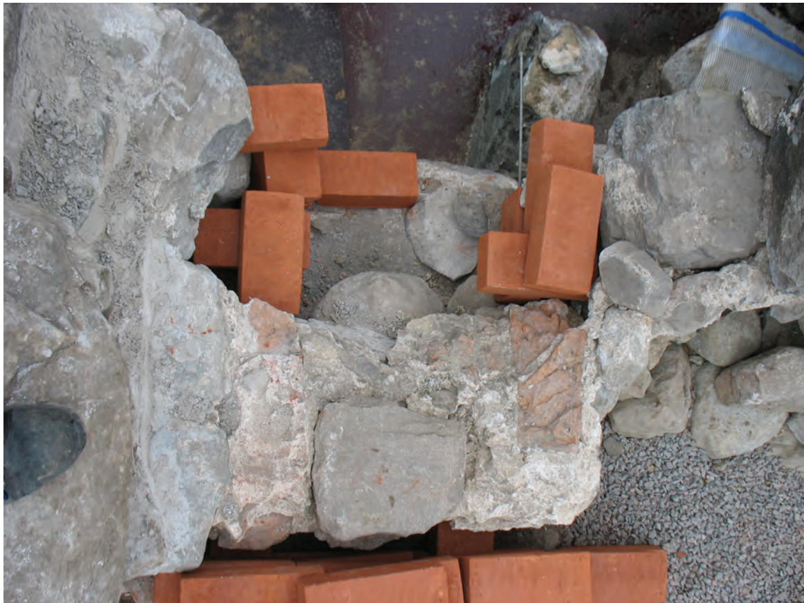
Figur 33. Fönsteröppningen sedd uppifrån från söder. Löst sittande stenar har avlägsnats av entreprenören. Tegelstenarna användes då fönsteröppningen rekonstruerades. Fotografi av Jonas Ros.
