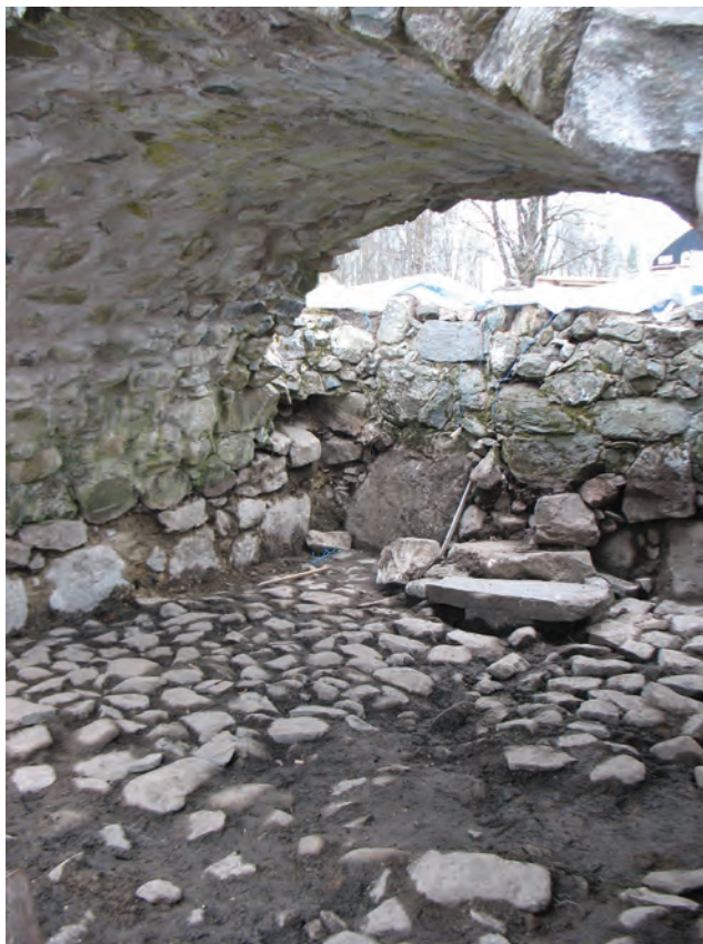
Figur 43. Östra rummets västra mellanvägg och valv samt del av den norra väggen. Kalkputs fanns bevarat på valvets insida. Fotografi från sydöst av Jonas Ros.
