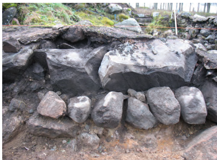
Figur 14. Här ses den del av yttermanteln som var bevarad, motsvarande sektion 3 vid ca 5–8 meter i den norra muren (se figur 13). På muren ses betong. Foto från norr av Jonas Ros.
