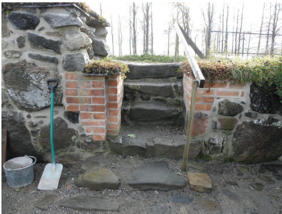
Figur 29b. Trappan rekonstruerad med tegelinfattningar. Fotografi från nordväst av Jonas Ros.
