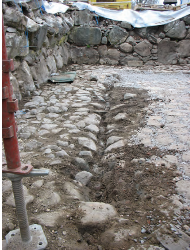
Figur 22. Del av golvet med rännan. Stenarna till böger som är omgivna av ljus grus har satts åter på plats efter nedläggande av dräneringsledningen. Fotografi från söder av Jonas Ros.
