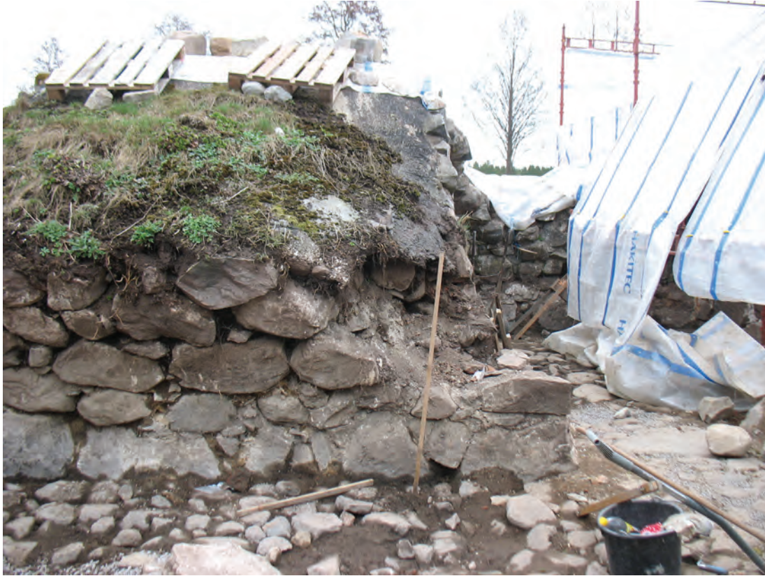
Figur 40. Del av västra rummets östra mellanvägg sedd från väster. Vidare ses läget för dörröppningen mellan de två rummen. Fotografi av Jonas Ros.
