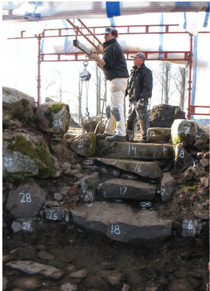
Figur 29a. Före demontering numrerade entreprenören stenarna i trappan. Fotografi taget från norr av Jonas Ros.
