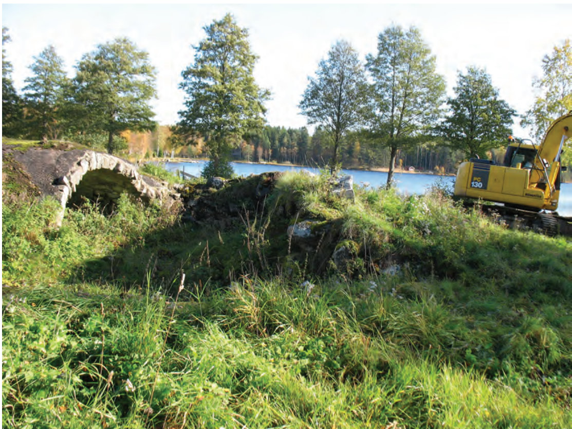
Figur 6b. Dubbelkällaren sedd från sydväst före schaktning 2008. Fotograf av Jonas Ros.
