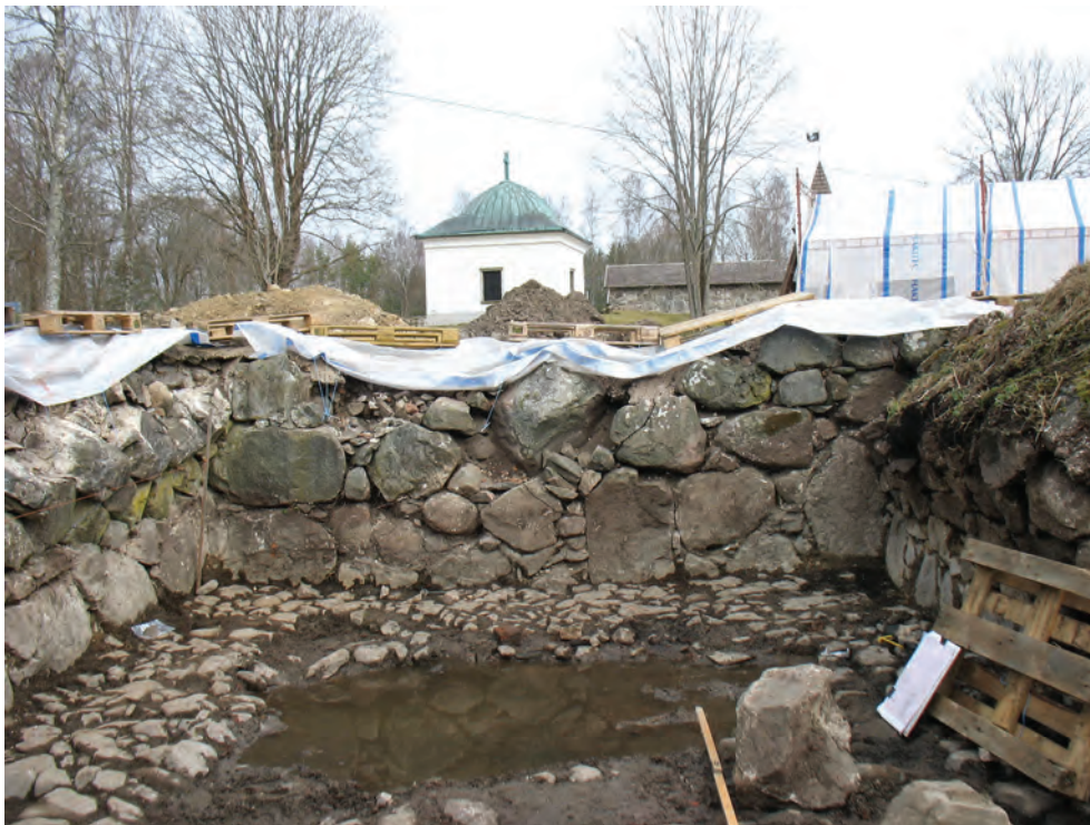
Figur 37. Den norra invändiga muren i västra rummet motsvarande sektion 7 vid 0–5 meter. (se figur 36) Delar av det stenlagda golvet var stört, d.v.s. söndergrävt. Fotografi från söder av Jonas Ros.
