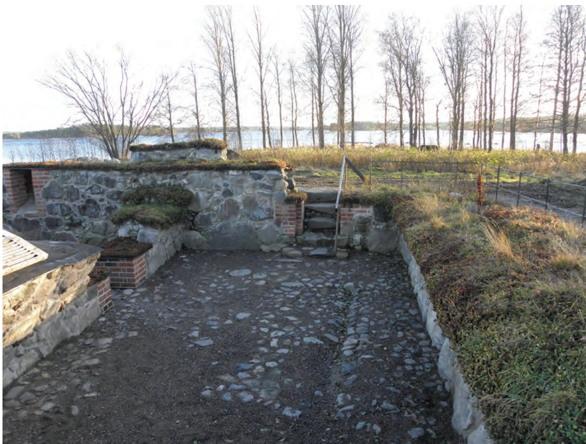
Figur 48. Det vänstra rummet efter att ruinen restaurerats. Murarna har ommurats, murarna vid öppningen mellan de två rummen har fått tegelinfattningar, ett fönster har rekonstruerats och trappan har fått tegelinfattningar. Fotograferat från norr av Jonas Ros.
