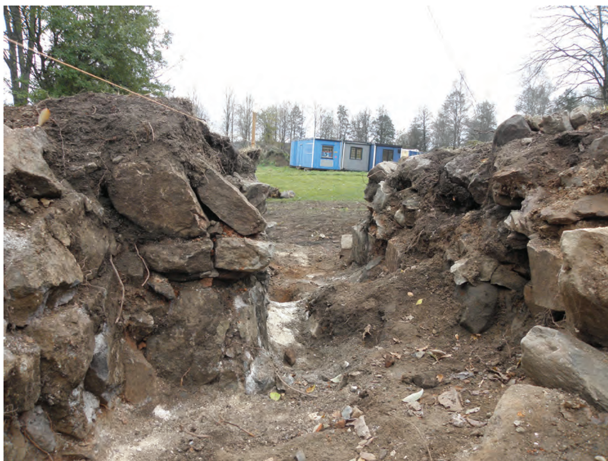
Figur 70. Över Kalkugn 2:s eldmun har det funnits ett valv som var raserat och till väster ses en anfangsten till valvet. Eldmunnens bögra vägg var delvis raserad (jfr sektion 4, se figur 66). Fotograferat från norr av Jonas Ros.
