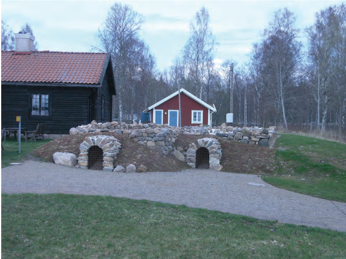
Figur 72. Tegelugnen och Kalkugn 2 rekonstruerades som ruiner på platserna där de stått. Tegelugnen ses till vänster och Kalkugn 2 till höger. Fotograferat från söder av Jonas Ros.
