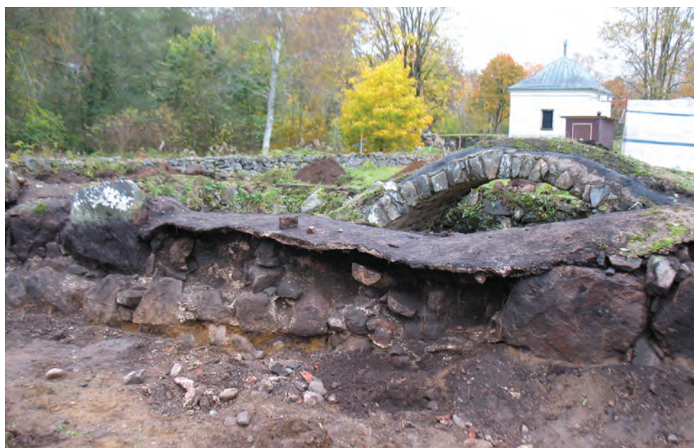
Figur 10. Del av den södra muren, motsvarande sektion 1 vid ca 7–12 meter (se figur 9). Muren var täckt av ett lager betong. Valvet i det östra rummet ses. Fotografi från söder av Jonas Ros.
