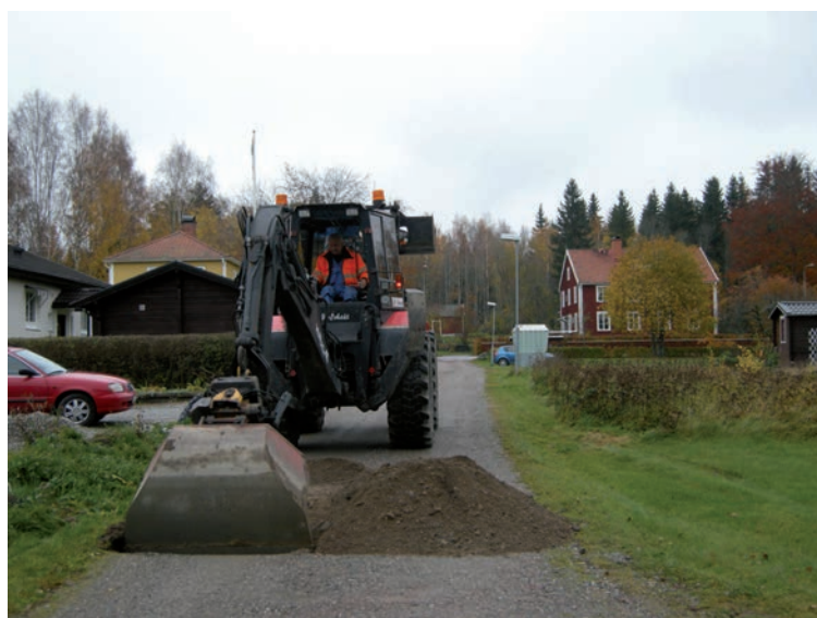
Figur 31. Arbetsbild från villakvarteret vid Anundshög. Grävmaskinist var Jan Frölander. Fotograferat av Maud Emanuelsson.
