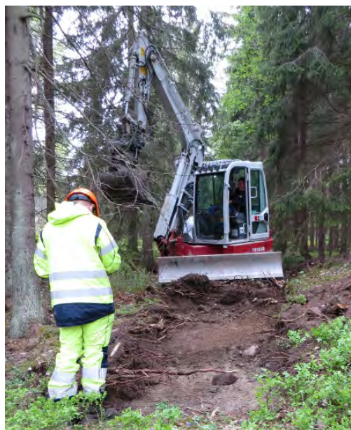
Figur 3. Sökschaktsgrävning inom Objekt 2. Schakten grävdes skiktvis med grävmaskin, grovrensades för hand och mättes därefter in med GPS. Foto: Henrik Runeson.
