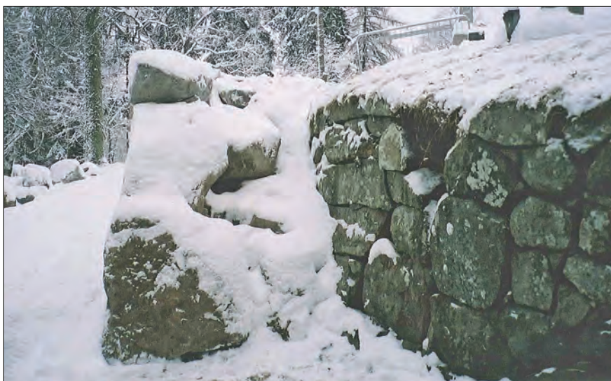
Figur 6. Den nya muren byggs utanför den gamla muren som får stå kvar. (Foto från väst U. Alström.)
