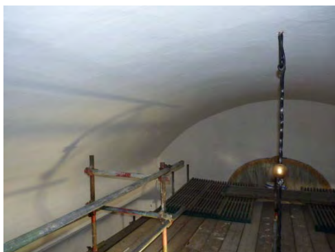
Figur 17. Tunnvalvet sett mot öster efter rengöring.
