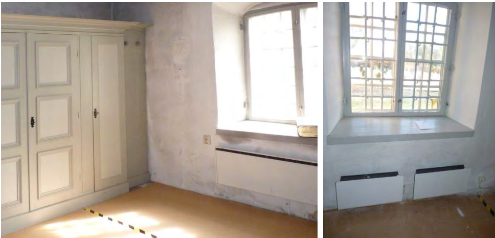
Figur 47. Äldre radiator i sakristian.
