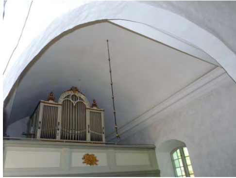
Figur 37. Västra tunnvalvet före åtgärder.
