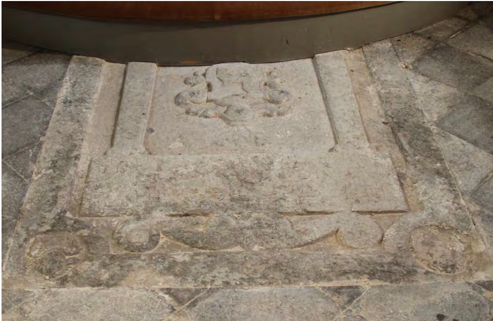
Figur 116. Gravhäll efter åtgärd.
