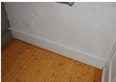
Figur 124. Kabellåda i trä, för att dölja aluminiumrör.
