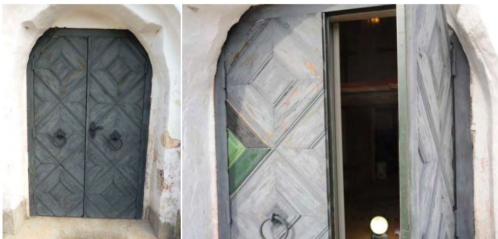
Figur 56. Port till södra vapenhuset före åtgärder.
