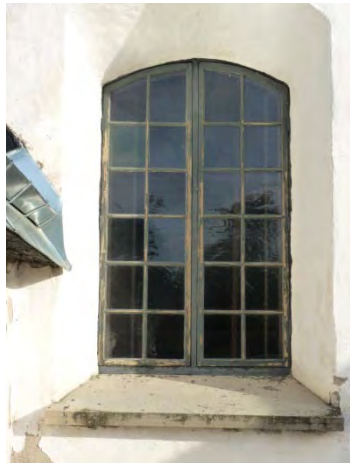
Figur 64. Påbörjad skrapning av fönsterbåge i södra fasaden. Plåtbleck under fönsterbåge rostar.
