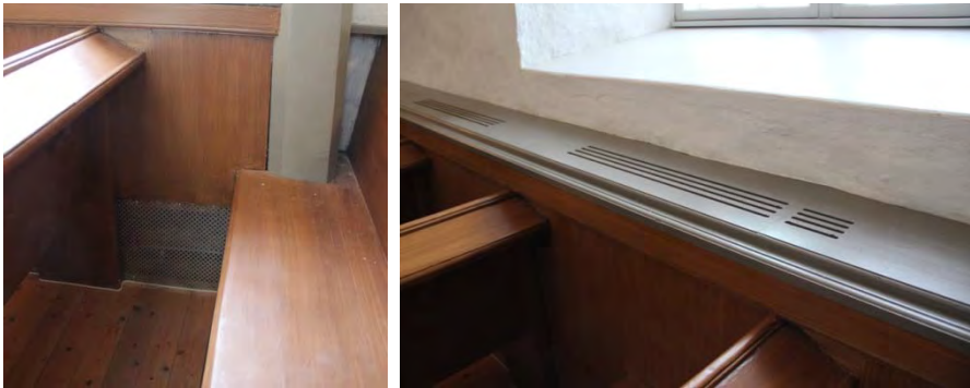
Figur 133. Luckor i bröstningen täckta med klöverplåt.
