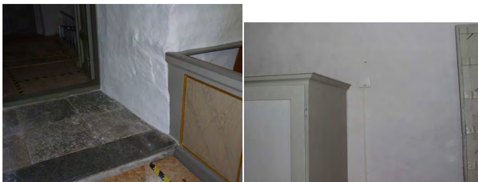
Figur 120. I passagen mellan långhuset och södra vapenhuset fanns sedan tidigare ett till synes omputsat parti i golvnivå. Bilden visar partiet efter åtgärder.
