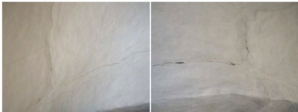
Figur 30. Närbild av sprickbildning i travé 3 mot öster.
