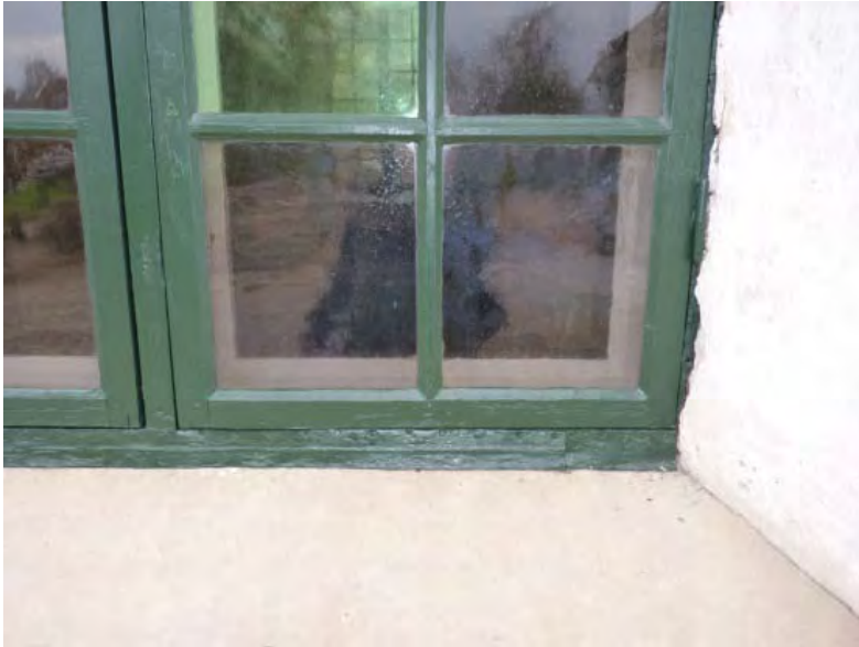
Figur 67. Färdigmålad fönsterbåge samt järnplåten under bågen.
