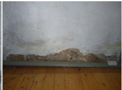
Figur 40. Omfattande putsläpp och saltvandring under läktaren, norra väggen.
