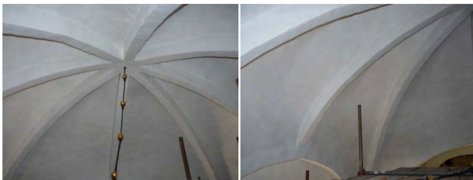
Figur 26. Travé 2 efter åtgärder. Sedd mot öster.
