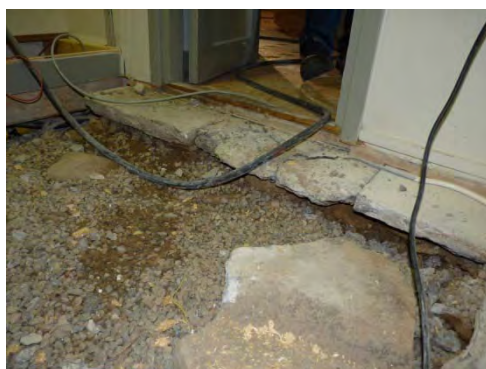
Figur 94. Kalkstensplattorna från vapenhuset går in en bit i elcentralen. Dessa rördes ej. Figur 95. Befintlig kabelväg genom grundmuren.
