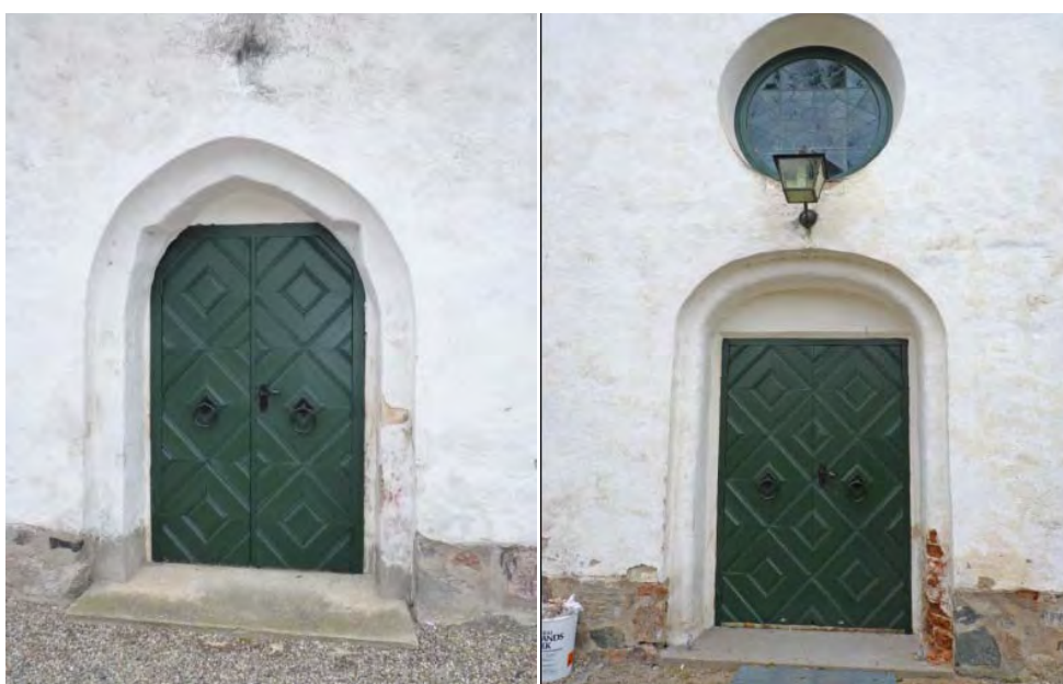
Figur 58. Södra vapenbusdörren efter ommålning.
