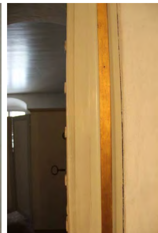
Figur 112. Färgbortfall från altaruppsatsens omfattning kring södra sakristiedörren
