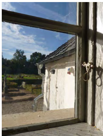
Figur 65. Ytterbågen har dubbla glas och är således kittat såväl från utsida som insida.
