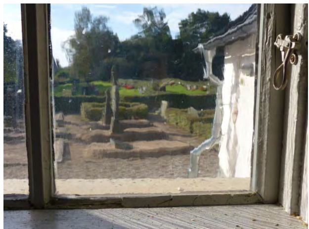
Figur 65. Ytterbågen har dubbla glas och är således kittat såväl från utsida som insida.
