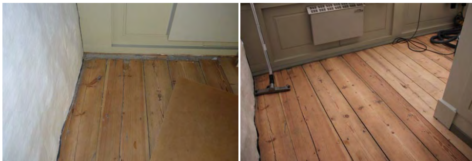
Figur 89. Provslipad yta av läktargolv.
