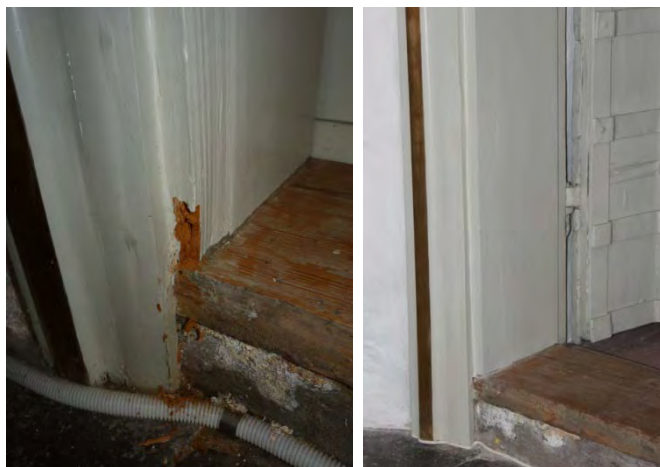
Figur 129. Norra sakristiedörrens karm hade rötskador i nederkant. Virket är så angripet att det ser vågigt ut i ett parti längst ned mot golvet.
