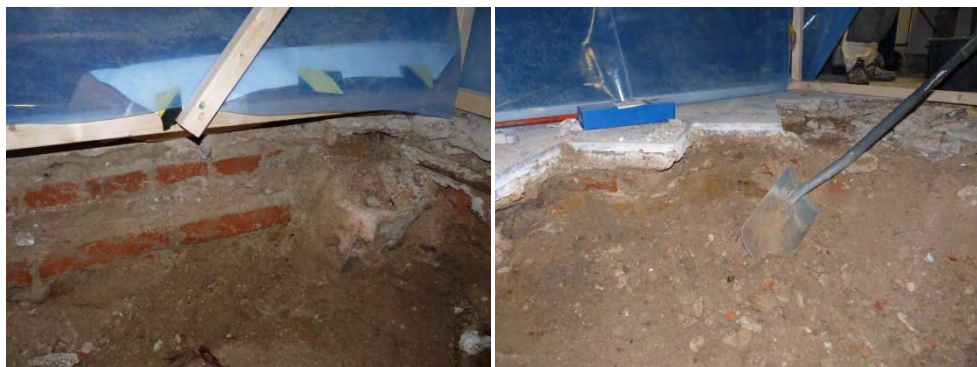
Figur 81. Teglet utgör förmodligen fundament för predikstolens trappa. Stenen till höger i bild kan eventuellt hänga samman med pelaren. Figur 82. Urschaktat parti i nordväst sett mot öster.
