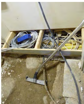
Figur 96. Marken urschaktad i elrum. Kalkstenar till böger i bild ligger kvar liksom markbundna stenar i bildens nedre vänstra hörn.
