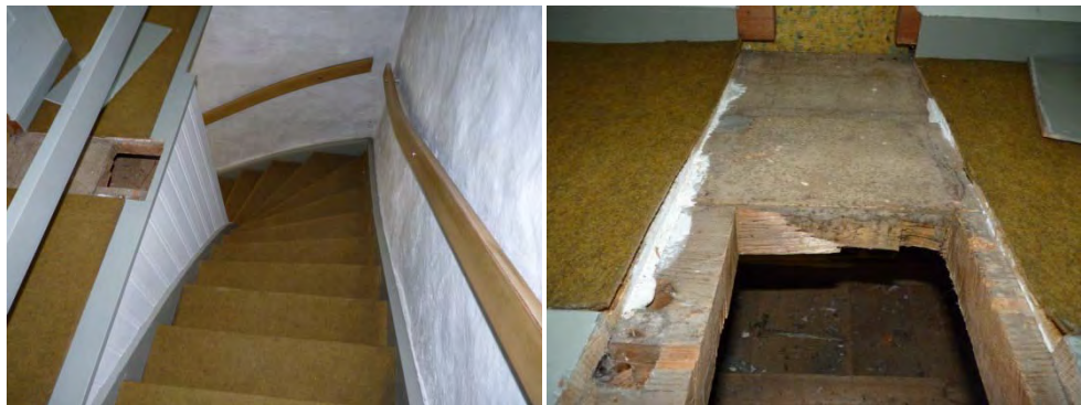
Figur 87. Nålfiltsmatta i läktartrappa och på läktaren. Figur 88. Läktargolv med äldre håltagning i trägolv. Nålfiltsmatta med underliggande masonite och flytspackel.
