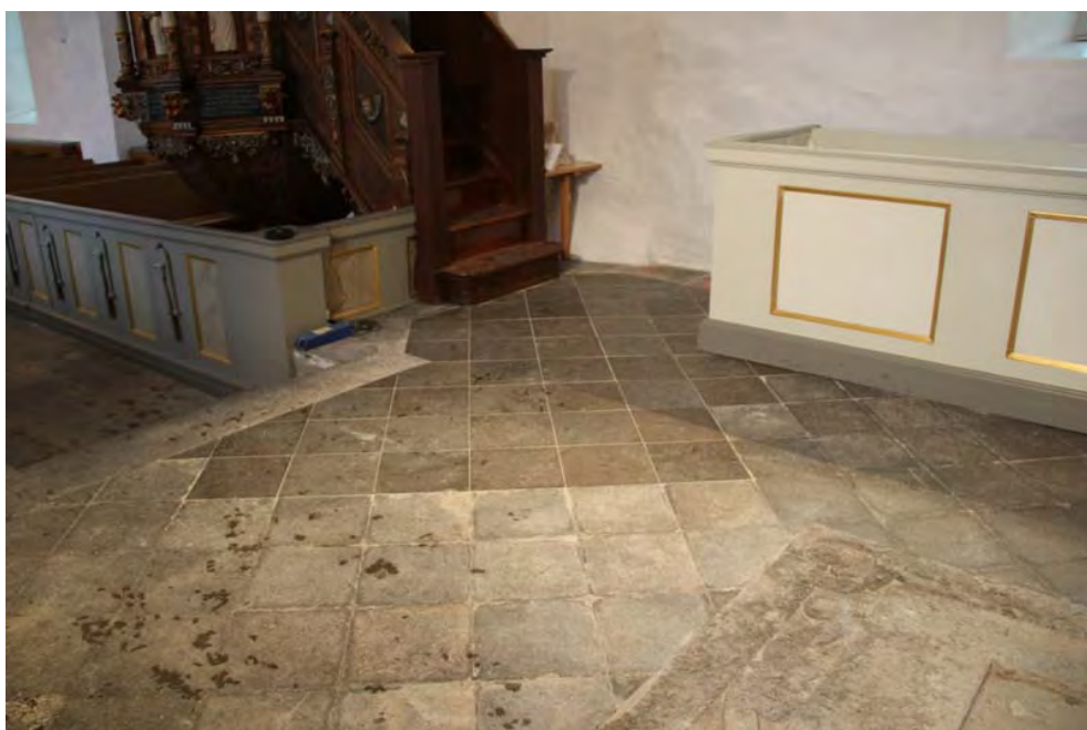
Figur 84. Nylagda kalkstensplattor framför predikstolen.
