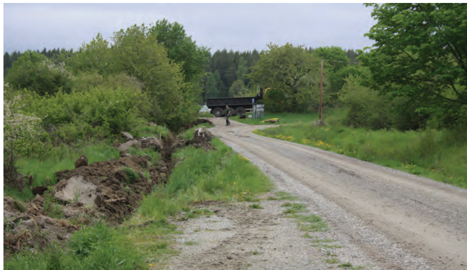
Figur 4. Schaktet längs med vägen sett från nordöst. Foto, Jenny Holm.
