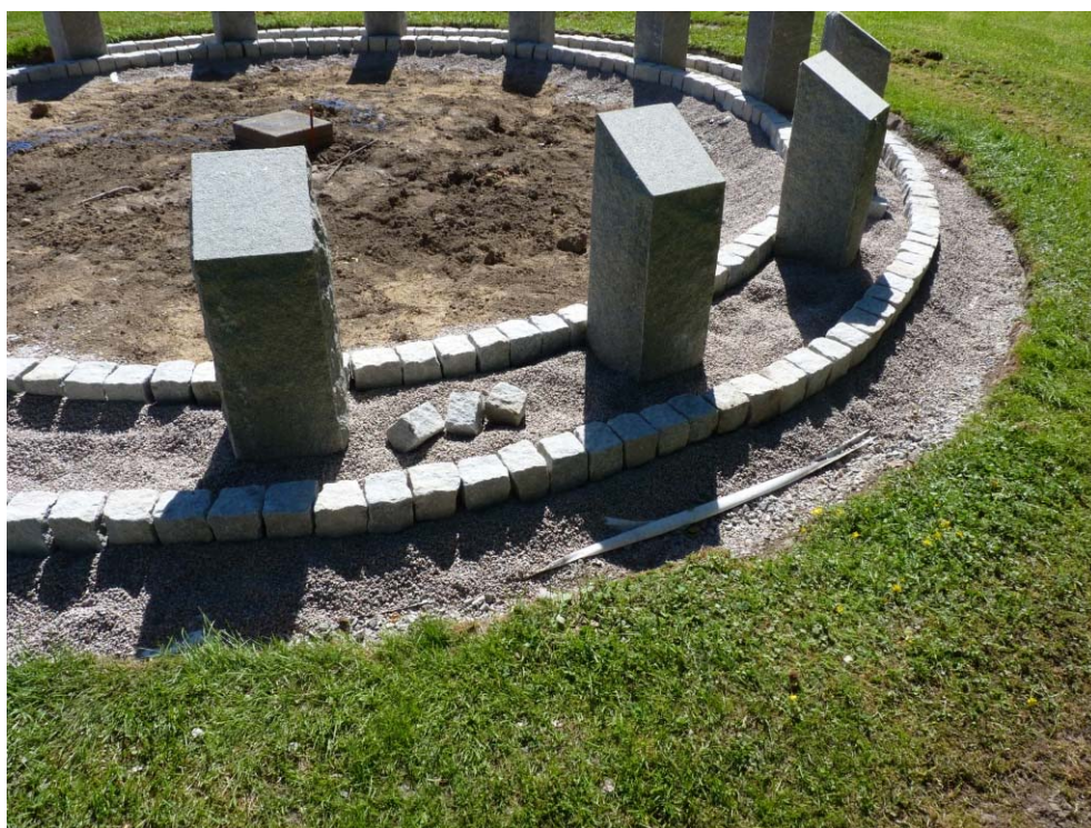
Figur 10. Askgravplatsen under uppförande, med utplacering av smågatsten. Foto: Tobias Mårud.
