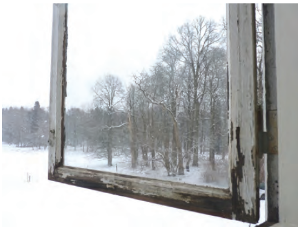
Figur 6. Fukt i bottenstycke av karm och rostangrepp på järndetaljer. Foto: Helén Sjökvist.
