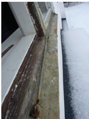
Figur 6. Fukt i bottenstycke av karm och rostangrepp på järndetaljer. Foto: Helén Sjökvist.
