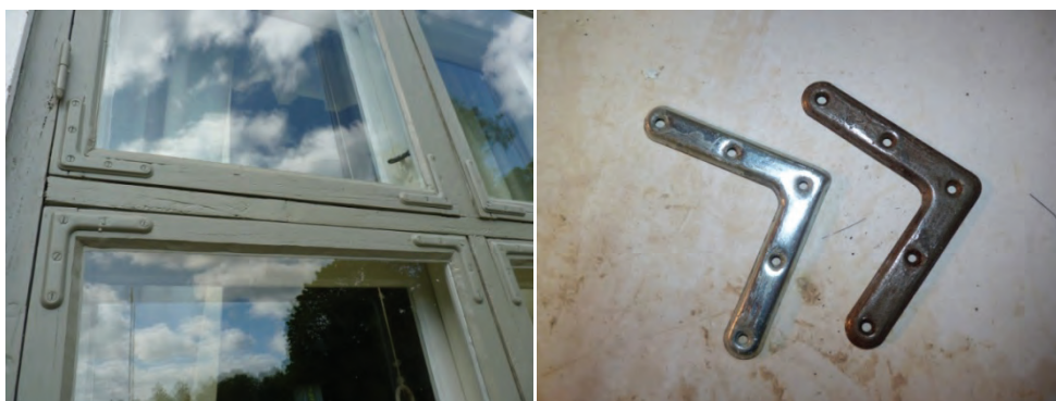
Figur 24. De övre bågarna är i allmänhet äldre än de undre. Beslagen skiljer sig något åt i utseende. Foto: Helén Sjökvist.
