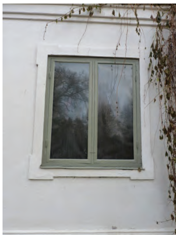
Figur 32. Blindfönster till vänster om entrén på västra fasaden, efter restaurering. Hörnjärnen är infällda i bågen och karmbottenstycket är synligt. Foto: Helén Sjökvist. Figur 33. Blindfönster övre våningen norra fasaden efter ommålning. Foto: Helén Sjökvist.
