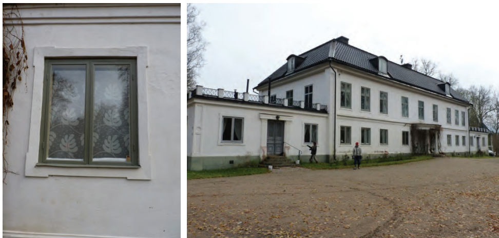
Figur 34. Badrumsfönstret till böger om entrén på västra fasaden var mer skadat än övriga båggar. Hörnjärnen är infällda i bågen. Karmbottenstycket är inte synligt. Foto: Helén Sjökvist. Figur 35. Västra fasaden efter genomförd fönsterrestaurering. Foto: Helén Sjökvist.
