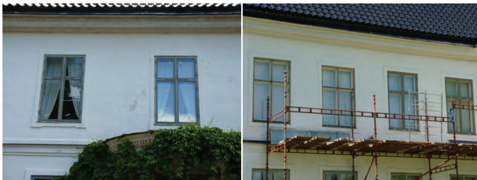
Figur 20. Mittenfönster på baksidan har fått renoverade bågar med utbytta trädelar. Karmarna ännu ej målade. Det vänstra fönstret har fått bågen stabiliserad med ett stålband då den var något skev. Bandet kunde senare tas bort. Foto: Helén Sjökvist.
