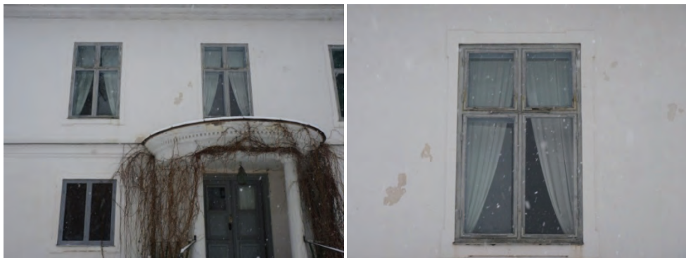
Figur 14. Fönsterbågar på byggnadens västra sida. Foto: Helén Sjökvist.
