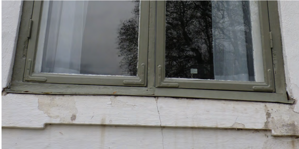
Figur 37. Till höger syns den nu utbytta delen av karmbottenstycket. Foto: Helén Sjökvist.
