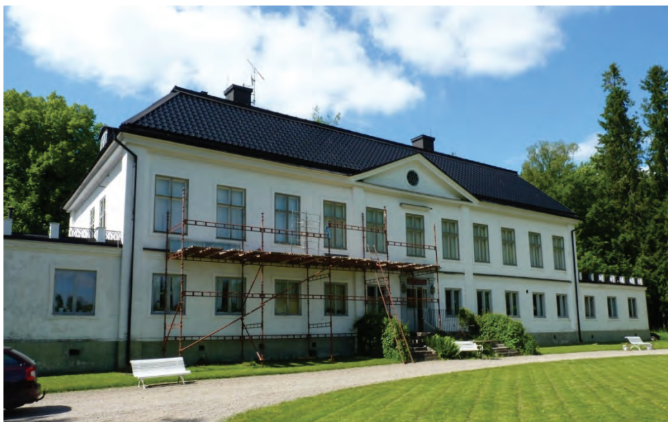
Figur 5. Herrgården sedd från öster under pågående fönsterrestaurering. Foto: Helén Sjökvist.
