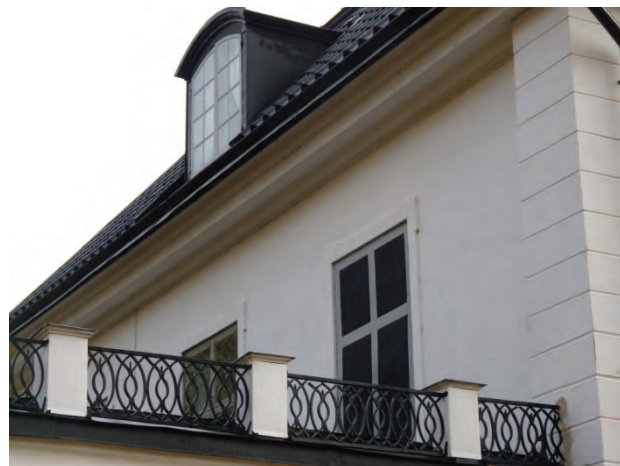
Figur 32. Blindfönster till vänster om entrén på västra fasaden, efter restaurering. Hörnjärnen är infällda i bågen och karmbottenstycket är synligt. Foto: Helén Sjökvist. Figur 33. Blindfönster övre våningen norra fasaden efter ommålning. Foto: Helén Sjökvist.
