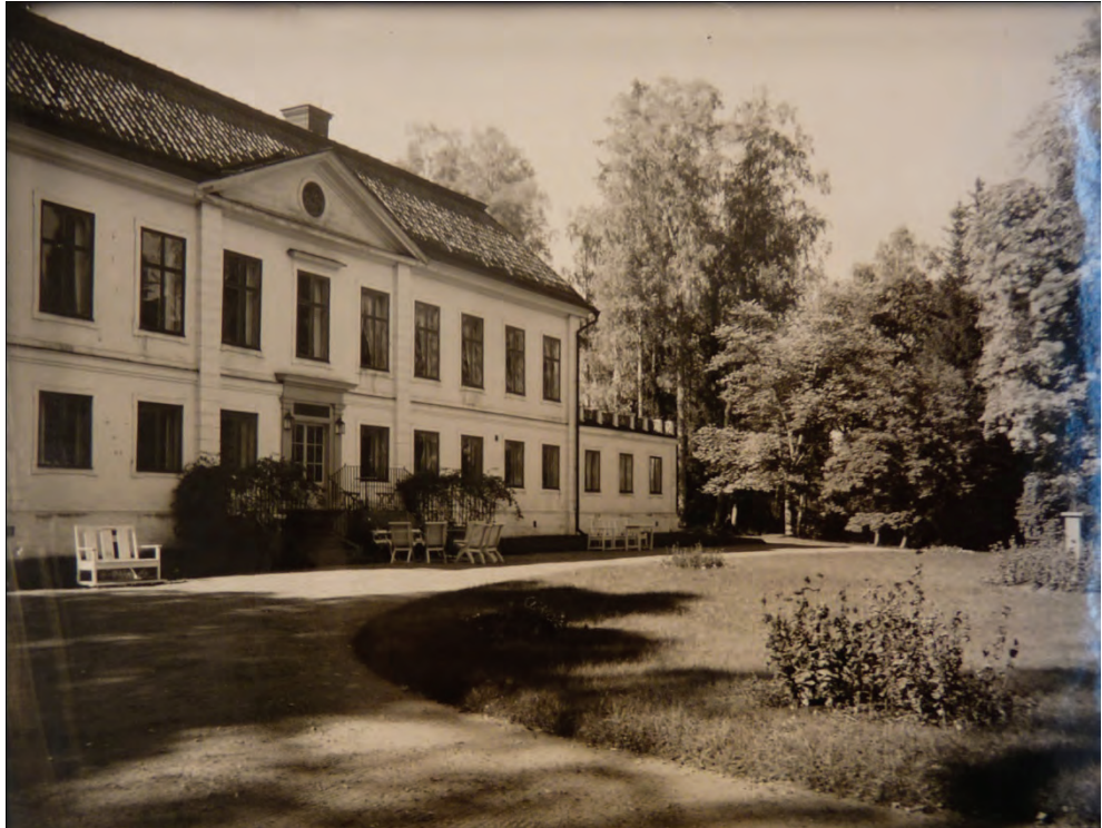
Figur 4. Bernshammar 1936. Fönsterbågar och karmar ser relativt mörka ut. Dörrpartiet har en annorlunda spröjsindelning mot idag. Foto: Selling. Nordiska museets arkiv. Något beskuren.
