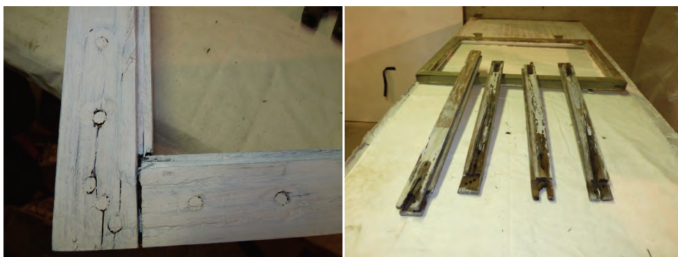
Figur 26. Pluggade hål under hörnjärn. Foto: Helén Sjökvist.
