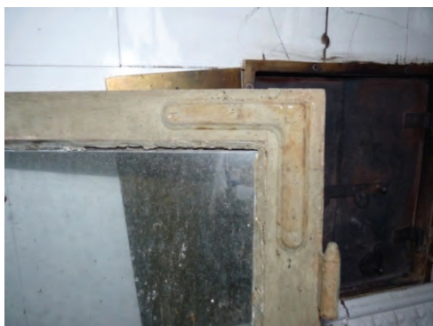
Figur 8. Detalj av hörnjärn på en fönsterbåge som återfunnits på vinden. Hörnbeslaget tycks vara pressat, maskintillverkat, samt skruvat med spårskruv. Kulören på bågen är, då man tittar på skyddade partier, lik den kulör som togs fram i samband med takomläggningen 2007, nämligen NCS S5005-G80Y. Foto: Helén Sjökvist.
