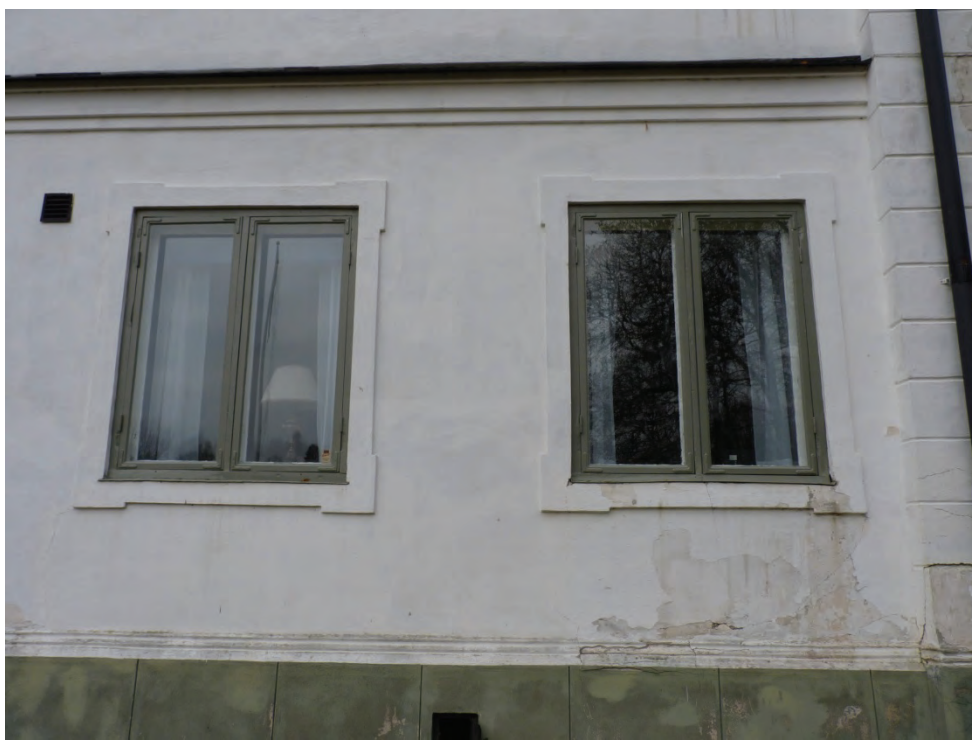
Figur 36. Utbytta karmbottenstycken östra fasadens norra del. Till böger syns det nu delvis utbytt bottenstycket. Foto: Helén Sjökvist.
