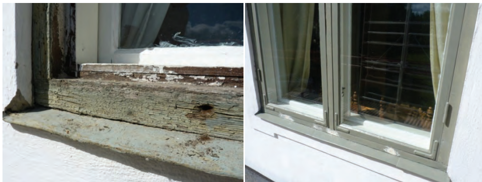
Figur 22. Skruvhålen i karmen efter hakarna är i vissa fall rötangripna. Foto: Helén Sjökvist.
