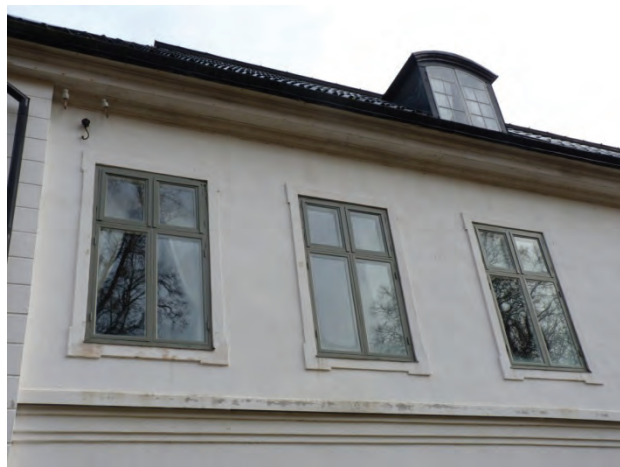
Figur 30. Fönsterkarm under renovering. Foto: Helén Sjökvist. Figur 31. Västra fasaden övre våningen tre fönster med lister som fäster övre bågen. Foto: Helén Sjökvist.
