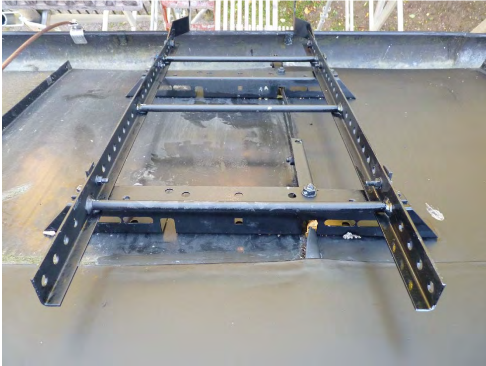
Bild 65. Den slutliga takstegen (sedd uppifrån).
