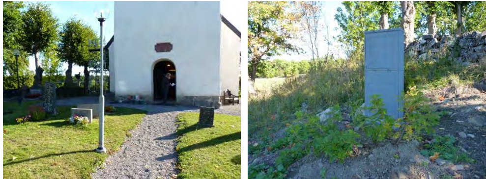
Bild 68. Den nya belysningsstolpen framför västra entrén har efter bilden togs blivit målad svart. Bild 69. Nytt elskåp tillkom väster om kyrkan, utanför kyrkogården. Skåpet målades in för att inte bli alltför iögonfallande. Buskar planterades kring skåpet vilket på sikt ytterligare kommer att dölja det.
