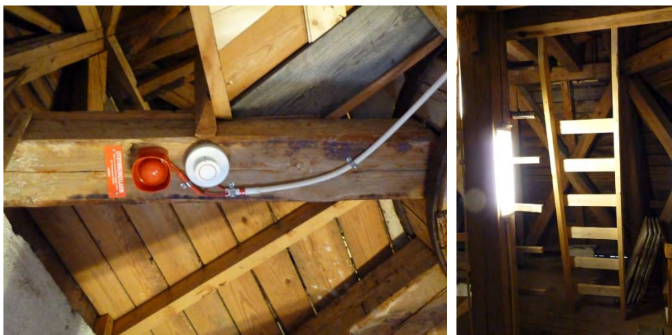
Bild 56. Siren och rökdetektor på plan 4.
