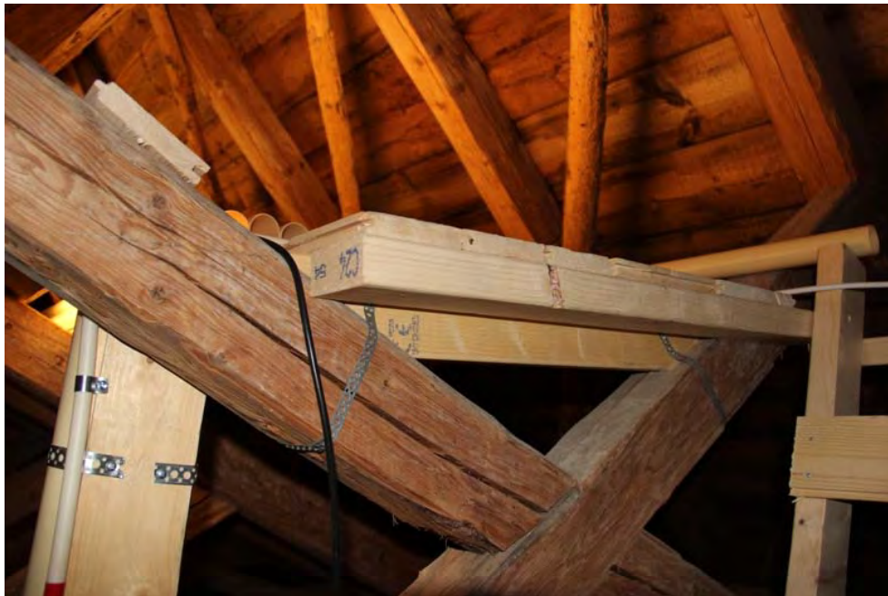
Bild 60. Landgångarna vilar på takstolarna. Infästning av landgångar, kabelbrädor och stegar har eftersträvat att utföras med så få ingrepp i den äldre stommen som möjligt.
