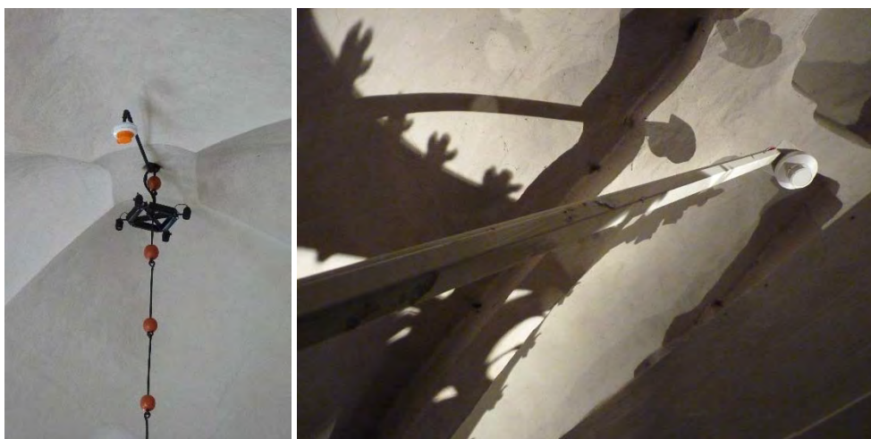
Bild 21. Rökdetektorerna i travée två och tre är monterade på en arm och kommer på så sätt ut en bit från pendlarna för ljuskronorna.
