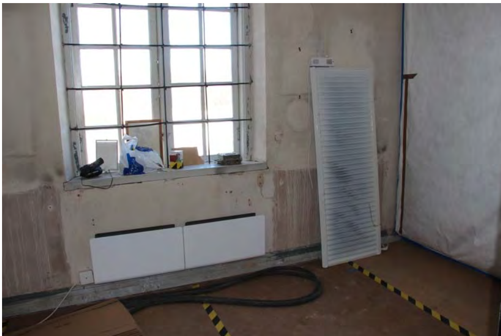
Bild 43. Nya elementen på plats, det äldre står lutat mot väggen. Foto: Lisa Skanser, KM.
