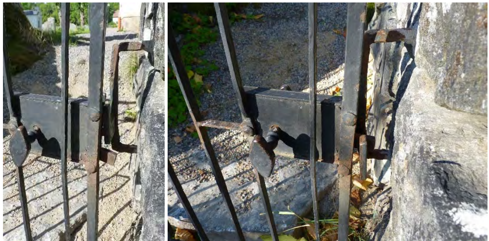
Bild 70. Nivån på grindens regel befinner sig under haket i läsbygeln vilket omöjliggör stängning av grinden. Bild 71. Efter rätning av grinden är läsregeln i rätt nivå.
