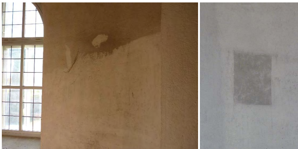
Bild 24. På bilden har rengöring av väggarna i koret påbörjats.
