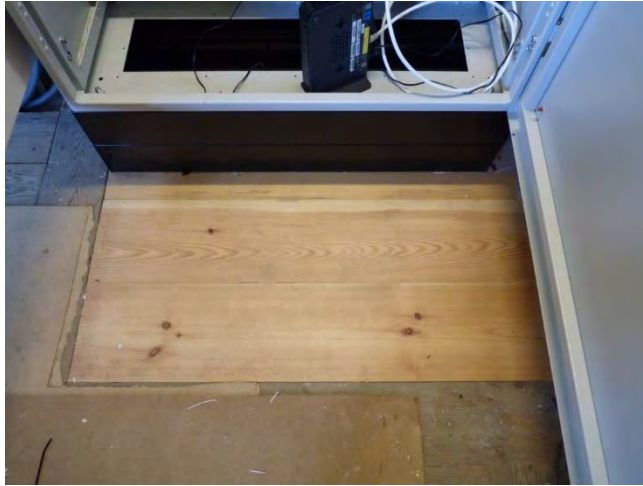
Bild 36. Nya golvbrädor har ersatt de tidigare kalkstensplattorna i hörnet. Bild 37. Det tidigare skåpet. Foto: Lisa Skanser, KM.
