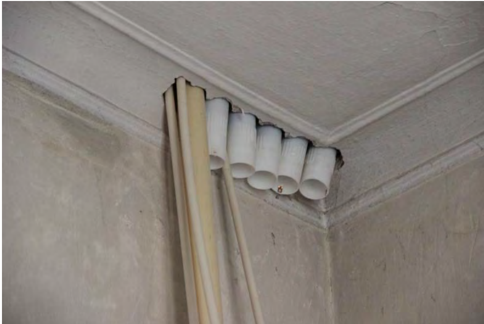
Bild 42. Håltagning för kablage mellan vind och elcentral i sakristian.
