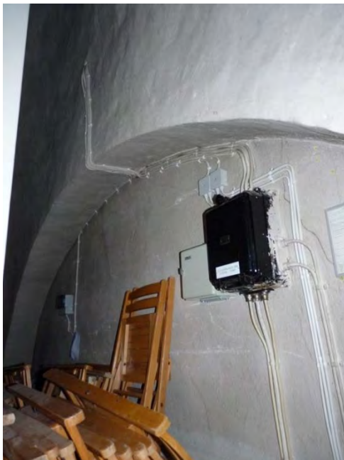
Bild 28. Äldre gruppcentral på orgelläktarens västra vägg innan åtgärder. Foto: Lisa Skanser, KM.
