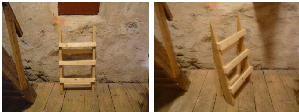
Bild 54 och 55. Lös trappstege har tillverkats för tillgänglighet till öppning mellan vind och tornkammare.
