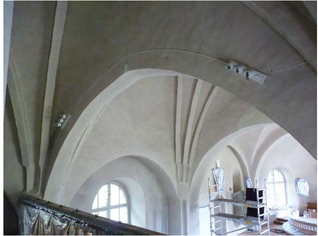
Bild 13. En av lampetterna på sin ursprungliga plats på gördelbågen mellan första och andra travéen. Bild 14. Här ersatta av spotlightsskenor för bättre ljussättning av orgel och läktare.
