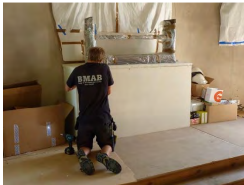
Bild 31. Den första board-skivan avlägsnas.
