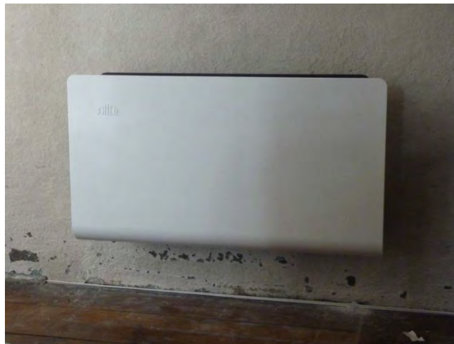
Bild 8. En av de nya fläktkonvektorerna, med mindre format än de äldre radiatorerna.
