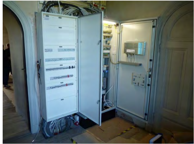
Bild 38. Här med all el demonterad. Foto: Lisa Skanser, KM. Bild 39. Apparatskåp och elcentral på plats och golvbrädorna återmonterade.
