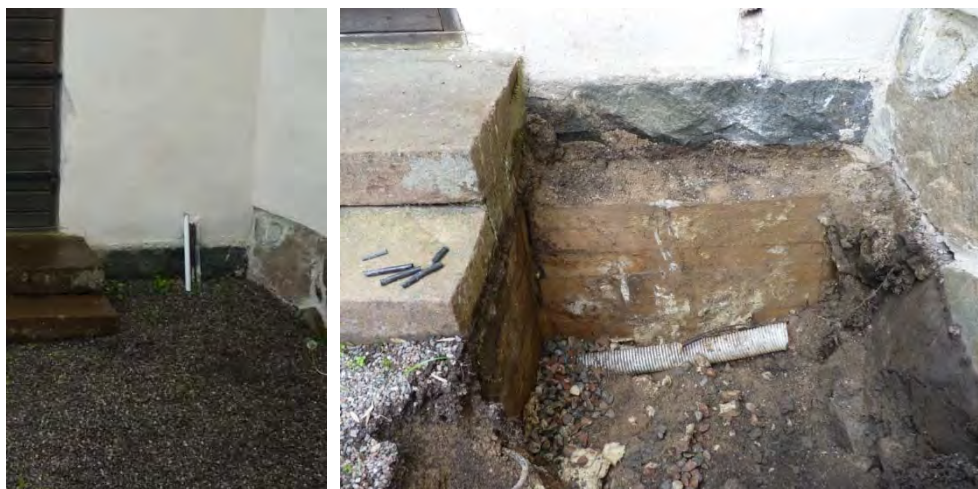
Bild 44. Befintlig kabelgenomförning var synlig i sakristians västra fasad innan åtgärderna. Bild 45. Befintliga kablar avlägsnades, gjutet parti av grundmuren frilades vid schaktning.
