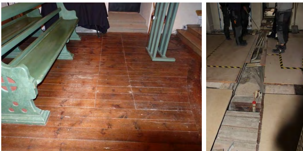
Bild 1. En mindre del av golvet hade tidigare demonterats och återmonterats. Foto: Lisa Skanser, KM.
