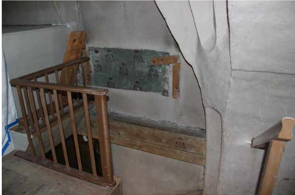
Bild 30. En yta med 1884-85 års färgsättning framkom vid demontering av en radiator på orgelläktaren. Brädorna för fästande av radiatoren har anlägnats och väggytan har snyggats till och bevarats. Observera testet av schablonen som är utförd på balken nedanför referensytan. Foto: Lisa Skanser, KM.
