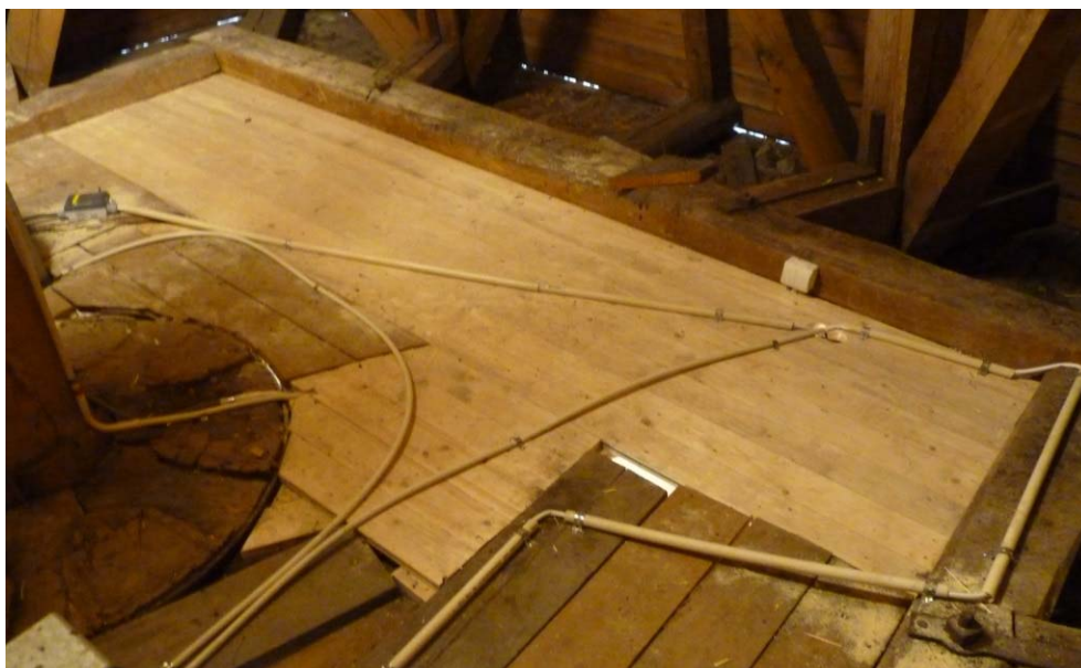
Bild 51. Golvet på plan 6 har kompletterats så inga hål finns kvar.
