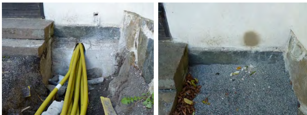
Bild 46. Ny håltagning utfördes igenom den gjutna grundmuren. Bild 47. Den äldre håltagningen sattes igen och putslagades. Ytan har senare avfärgats.
