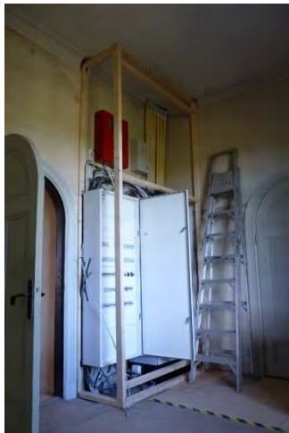
Bild 40. Stommen till det nya skåpet är rest. Bild 41. Här är det nya skåpet nästan färdigt
