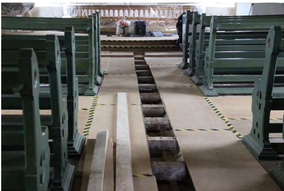
Bild 3. Demonterad kanal i mittgången.
