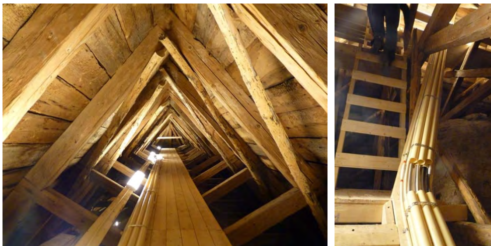
Bild 58. Ny landgång och kabelbräda på vindens takstolar. Rör är även förlagda till själva landgången.
