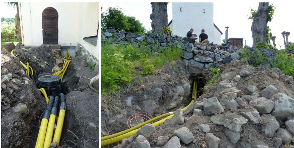
Bild 66. Installation av nytt dagvattensystem och rördragnig för elkablage.
