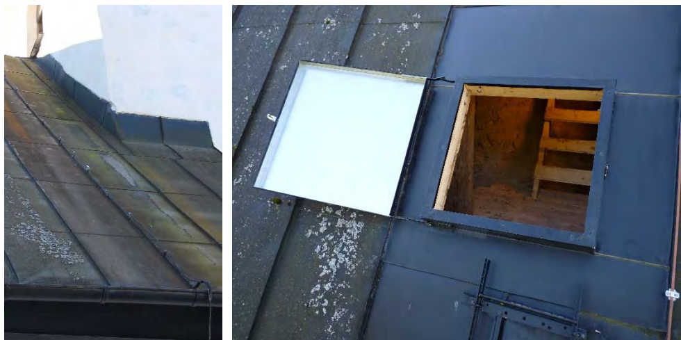
Bild 63. Västra delen av norra takfallet, innan tillkomst av lucka och steg. Foto: Lisa Skanser, KM.
