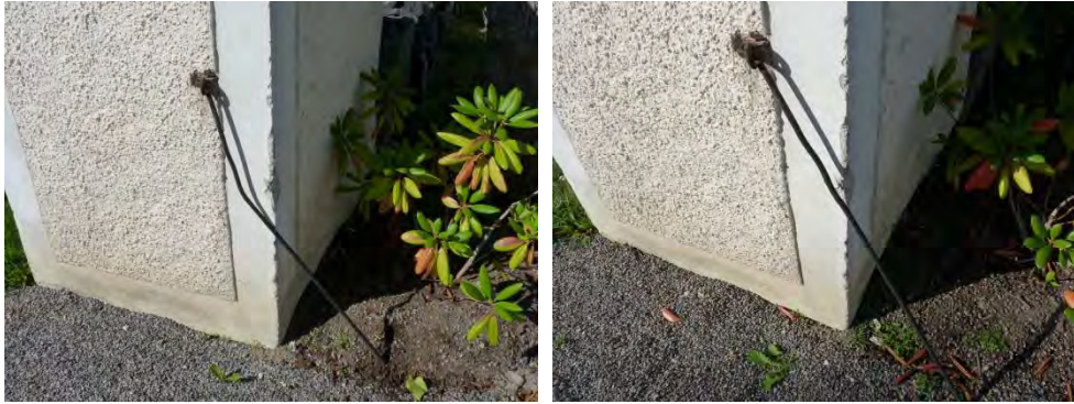
Bild 74. Järnstång för reglering av grind krokigt, möjligen efter påkörning.
