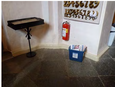
Bild 19. Inklädnad av kablar längs väggen norr om sakristian.
