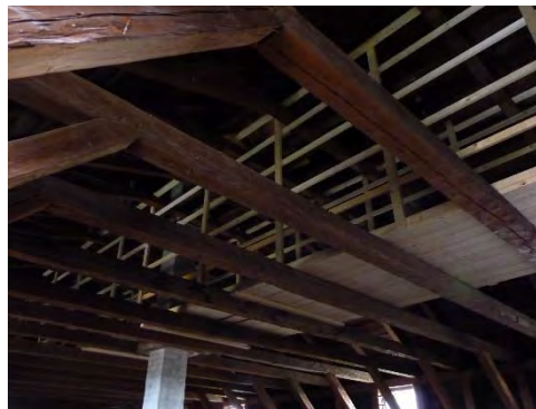
Bild 15. Gångbron på kyrkvinden har fästs på så få ställen som möjligt i den äldre stommen.
