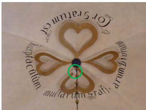
Bild 9. Kablage till detektorerna i kyrkorummet är normalt draget i befintliga hål för pendlarna.
