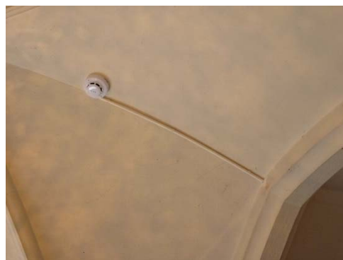
Bild 7. Detektor monterad i tak i Brudkammaren (ej enligt samråd).
