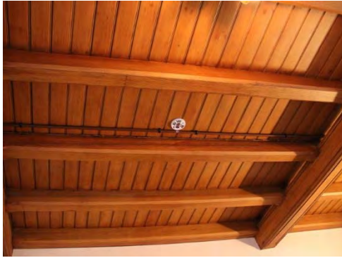
Bild 13. Kabeln till detektorn under orgelläktaren färgades in i kulör enligt RAL-kod 8001. Om möjligt färgas även detektorn in i samma kulör. Foto: Liza Skanser, Stiftelsen Kulturmiljövård.
