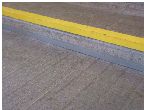
Bild 4. Den tidigare vita plastlisten på nedre sättsteget till koret har målats in i kulör mot kalkstenstrappan.
