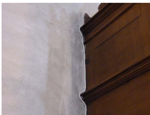
Bild 5. Exempel på dragning av rör för kablage, i skarv mellan golv och vägg.
