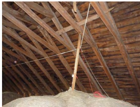
Bild 18. Exempel på luftlina mellan valven, fäst i en stående bräda.
