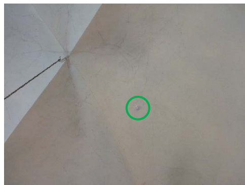
Bild 9. Kablage till detektorerna i kyrkorummet är normalt draget i befintliga hål för pendlarna.
