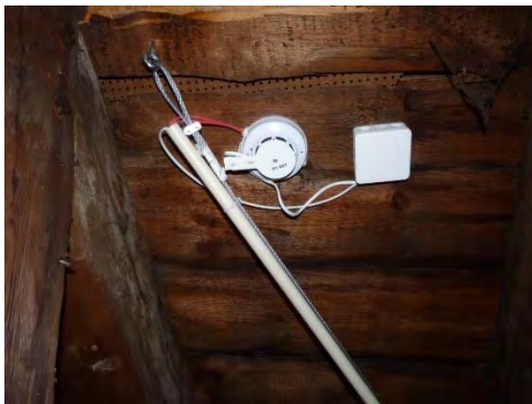
Bild 17. Detektor fäst i mellersta delen av det övre takfallet.
