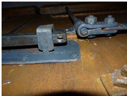
Bild 21. Håltagning i befintlig låskonstruktion.
