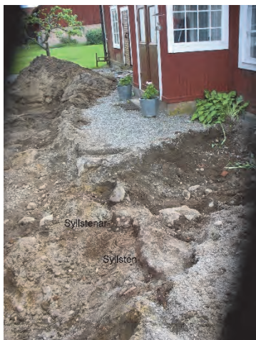
Figur 16. I schakt 10 (se figur 7) påträffades lämningar av en syllstensrad som var orienterad i väst-östlig riktning. Fotograferar av Jonas Ros från nordväst.
