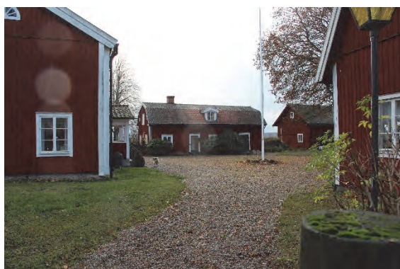
Figur 19. Området vid schakt 1 och 12 vid efterbesiktningen. Fotograferat av Jonas Ros.
