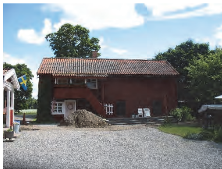
Figur 15. Framför loftboden togs ett schakt upp (6, se figur 7). Där påträffades keramik som dateras till 1700-talet. Fotograferat från väster av Jonas Ros.
