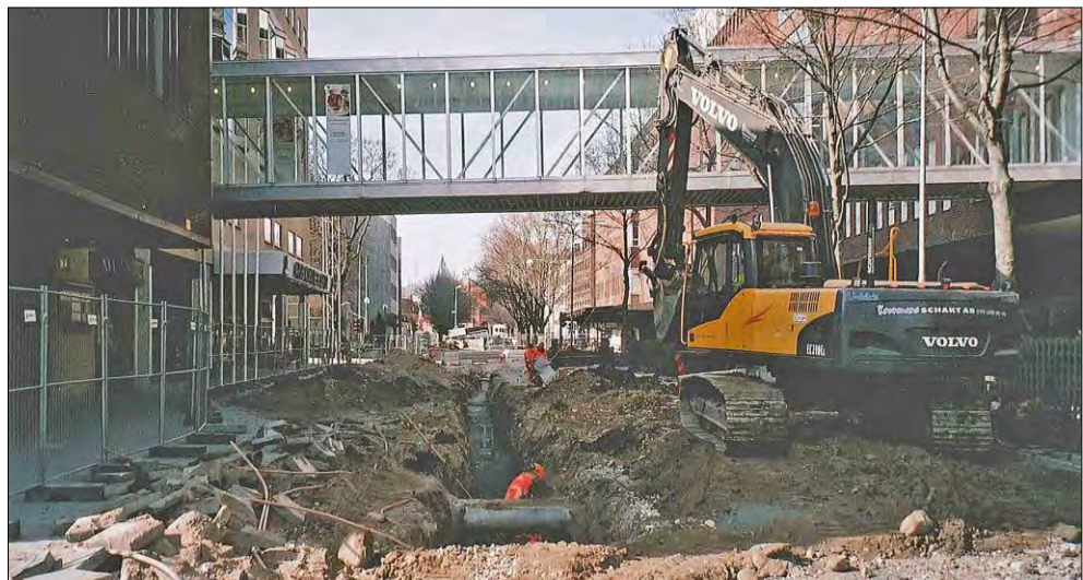
Figur 1. Vattenledningsschaktet i Munkgatan. Ytterligare markarbeten utfördes senare då fjärrvärmeledningarna byttes ut. (Foto från öst U. Alström.)
