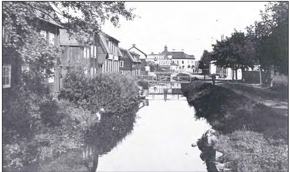
Figur 2. Lillån sedd mot öster. Fotot taget före 1907 innan arbetet med att skapa Munkgatan börjat (Foto ur Västerås 1000 år i centrum samt Västmanlands läns museum).
