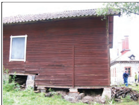
Figur 36. Syllen uppallad på nya plintar. Foto: Helén Sjökvist.
