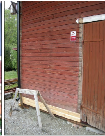
Figur 26. Utbytt syll som dragits förbi dörröppningen. Foto: Helén Sjökvist.
