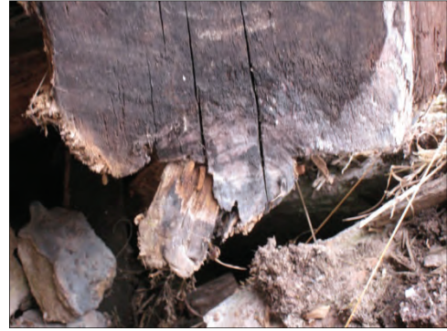
Figur 24. Syllen vid porten på framsidan var rötskadad och byttes. Foto: Helén Sjökvist.
