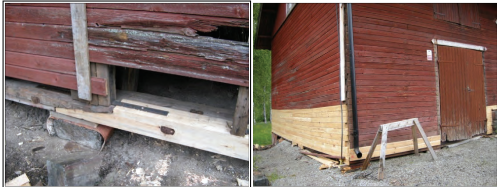
Figur 14. Skarvning med blixtskarv och infästning av stolpe med hjälp av ett vinkeljärn. Foto: Helén Sjökvist.
