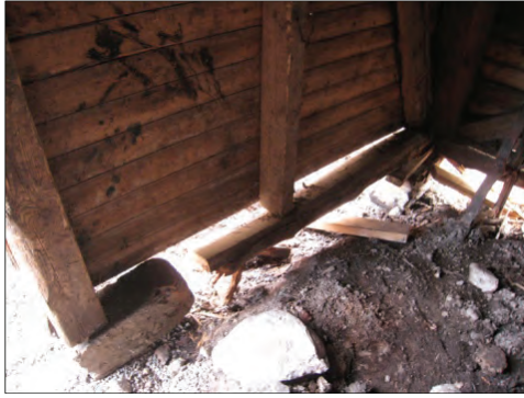
Figur 24. Syllen vid porten på framsidan var rötskadad och byttes. Foto: Helén Sjökvist.
