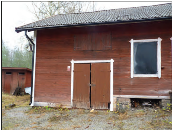
Figur 30. Dörrfoder delvis demonterade. Foto: Helén Sjökvist.
