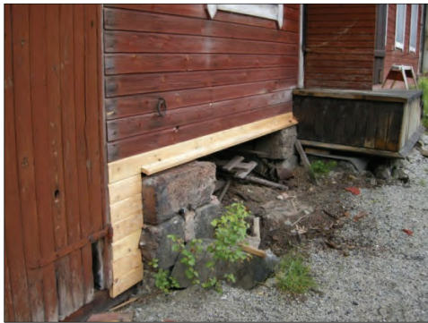
Figur 28. Bytt panel till höger om dörren. Foto: Helén Sjökvist.
