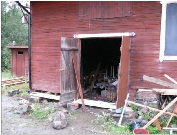
Figur 26. Utbytt syll som dragits förbi dörröppningen. Foto: Helén Sjökvist.
