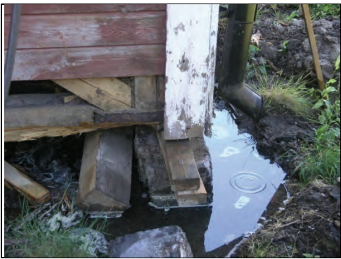
Figur 10. Vattenansamling vid börn gavel och framsida. Foto: Helén Sjökvist.
