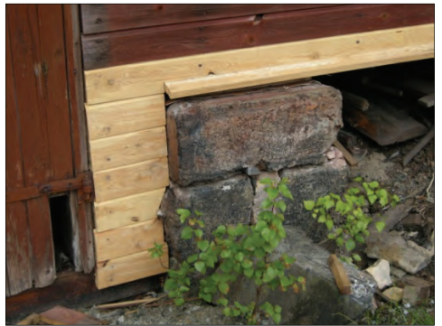
Figur 26. Utbytt syll som dragits förbi dörröppningen. Foto: Helén Sjökvist.
