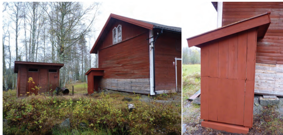
Figur 18. Gaveln med upprest dass och rödfärgade, nya vindskivor. Knutbräderna återmonterade. Foto: Helén Sjökvist.
