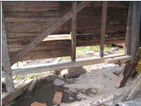
Figur 12. Syllan utbytt. Foto: Helén Sjökvist.
