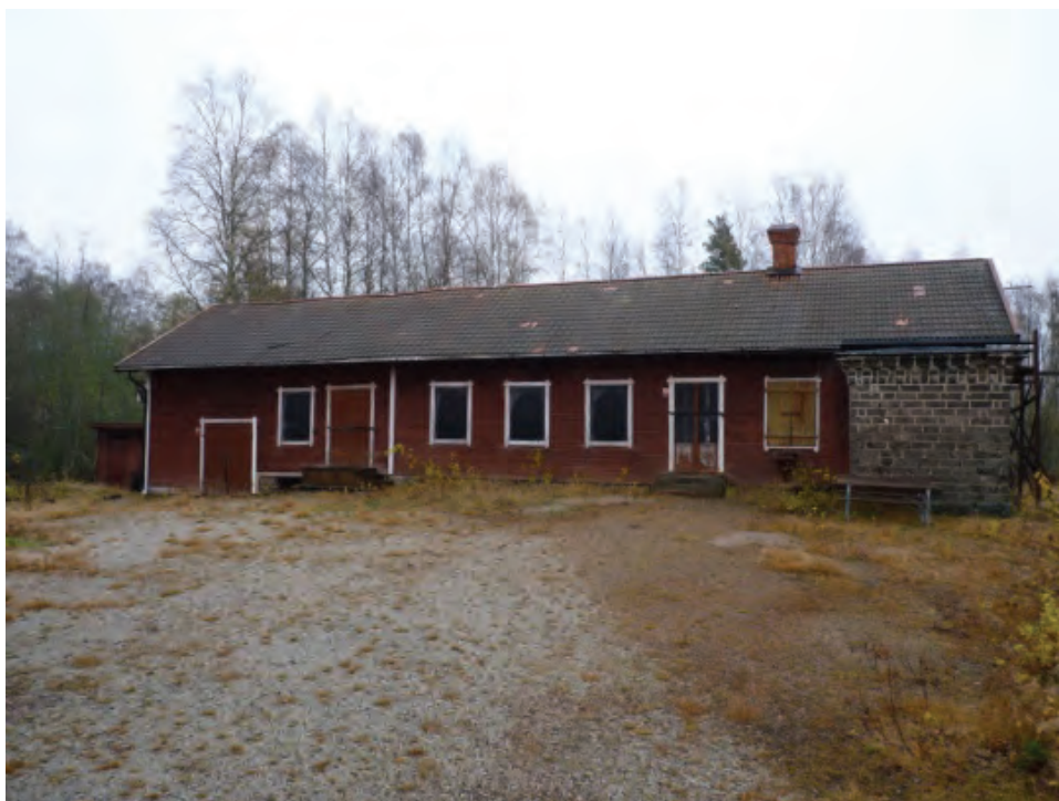
Figur 47. Taket med vissa utbytta tegelpannor.
