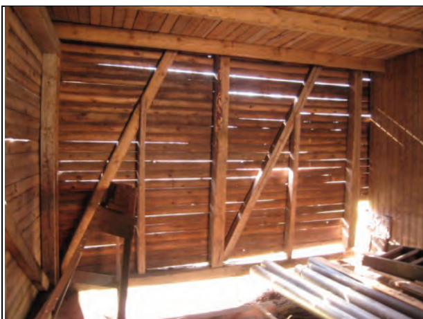
Figur 34. Fasaden sedd inifrån med syllen nedfallen. Foto: Helén Sjökvist.
