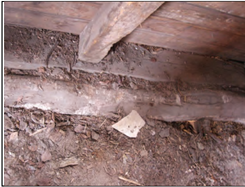
Figur 10. Vattenansamling vid börn gavel och framsida. Foto: Helén Sjökvist.
