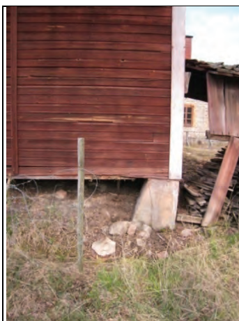
Figur 34. Fasaden sedd inifrån med syllen nedfallen. Foto: Helén Sjökvist.
