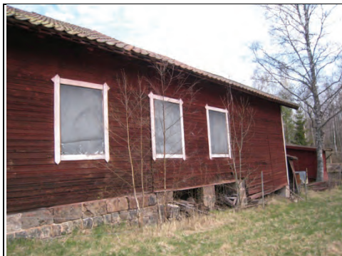
Figur 32. Baksidan med syll som fallit ned mot marken. Foto: Helén Sjökvist.
