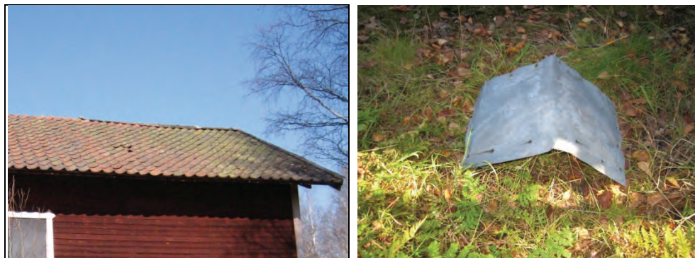
Figur 43. Skadade nockbrädor.
