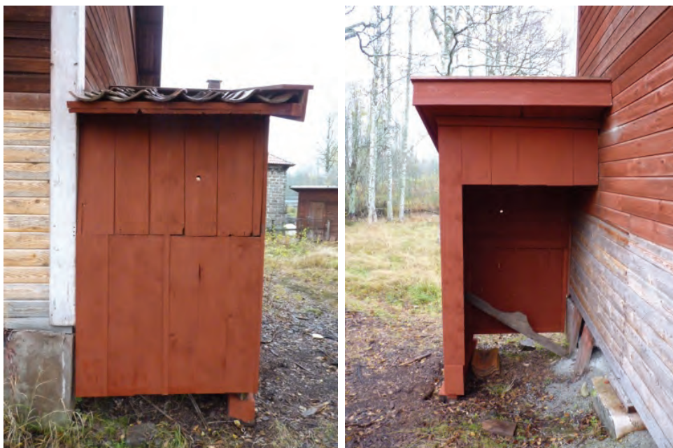
Figur 20. Dasset sett från baksidan efter återmontering. Virket över generalskarven är äldre. Det locklagda undertaket är gammalt. Det enkupiga tegeltaket är original. Foto: Helén Sjökvist.
