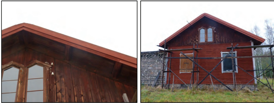
Figur 39. En mindre del av vindskivan på sydvästra sidan har kunnat återanvändas. Foto: Helén Sjökvist.
