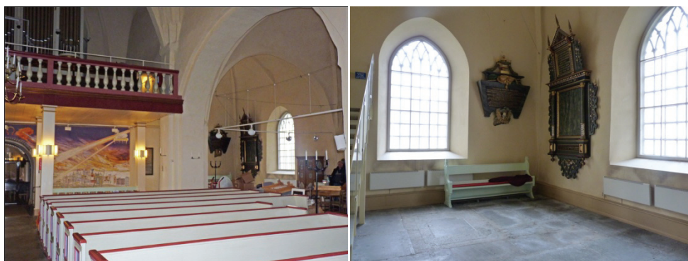
Figur 3. Mellankyrkan sedd mot väster med det aktuella utrymmet sett i nordväst före åtgärder.
