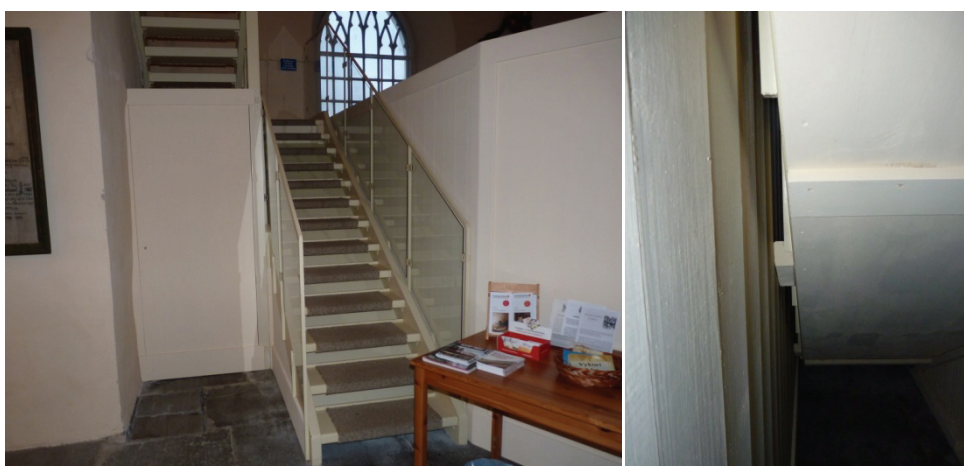
Figur 15. Befintlig läktartrappa och ny dörr in till förrådet under läktartrappan.
