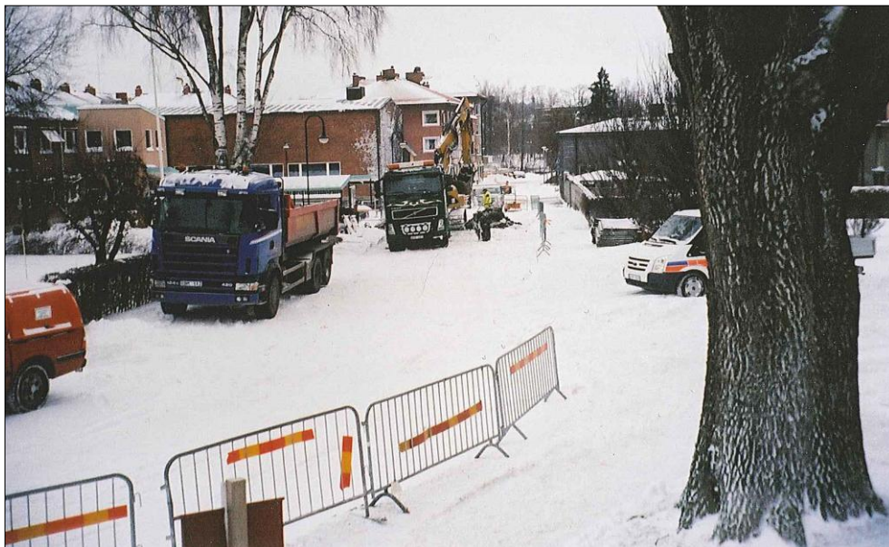
Figur 1. Schaktningsarbete i Stora Kyrkogatan december 2012. (Foto från SV U. Alström.)
