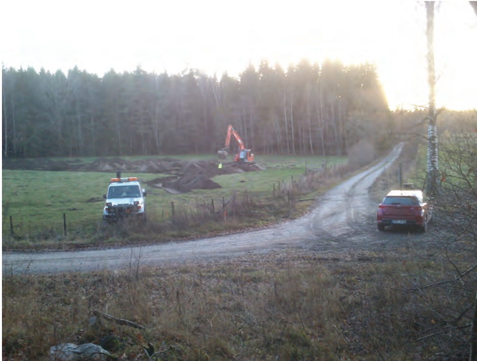
Figur 5. Schaktning inom förundersökningsområdet vid Irsta 508. Foto från nordöst av Maud Emanuelsson.
