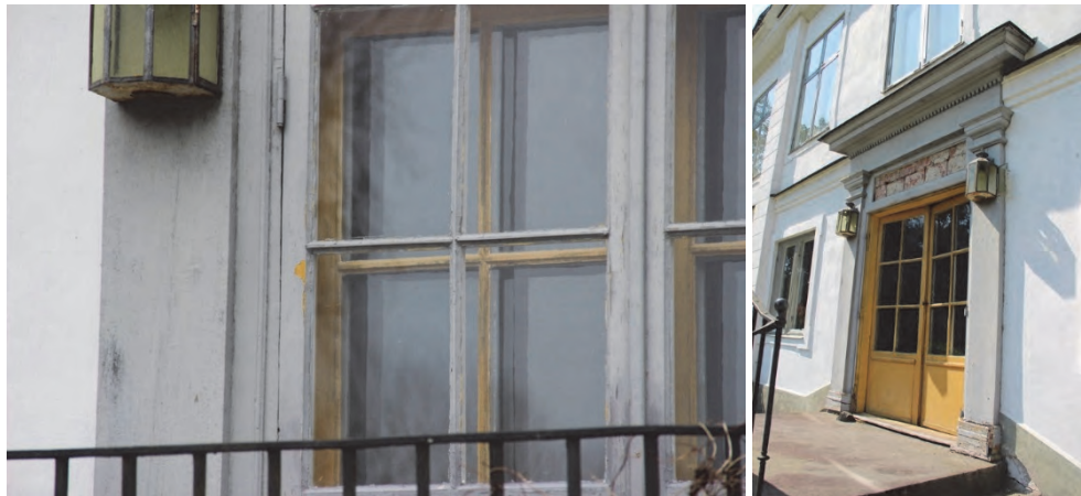
Figur 57. Dörren består av en dubbeldörr med ett yttre och ett inre dörrpar. Foto: Lisa Skanser.
