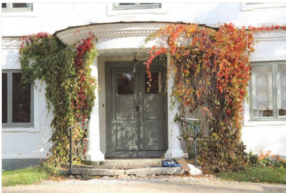
Figur 52. Västra entrén efter åtgärder. Foto: Lisa Skanser.
