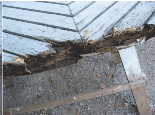
Figur 14 och 15. Åtgärdande av skador på ett av södra pochéns dörrblad. Foto: Louise Lorichs/Gunnar Härén.
