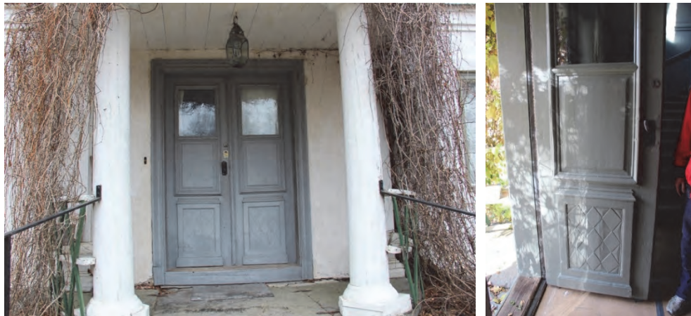
Figur 48. Västra entrén före åtgärder. Foto: Lisa Skanser.
