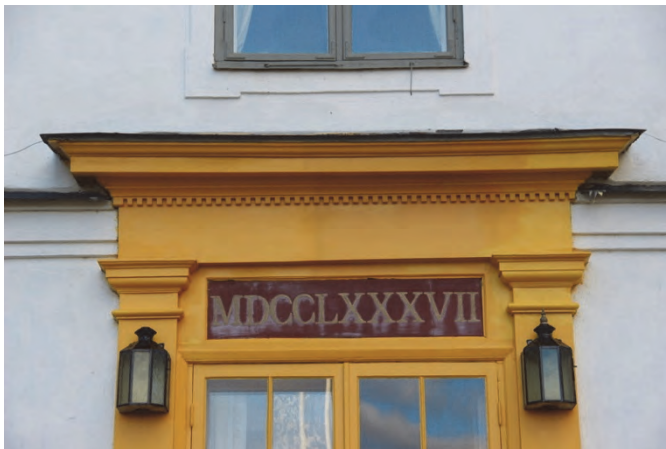
Figur 74. Entréns övre del provstruken med tre olika gula nyanser. Foto: Lisa Skanser.
