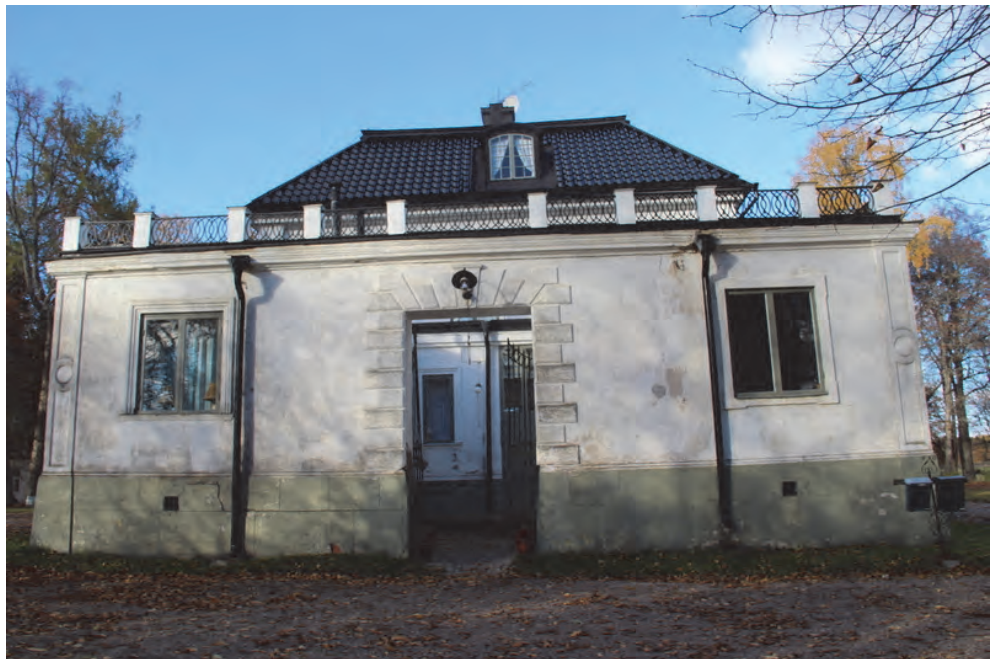
Figur 24. Fönsterbågar mot söder, södra pöchen, färdigställda. Foto: Lisa Skanser.
