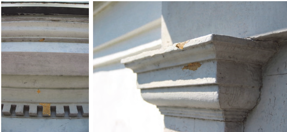
Figur 62 och 63. Färgskrap med framkommande gul kulör. Foto: Lisa Skanser.
