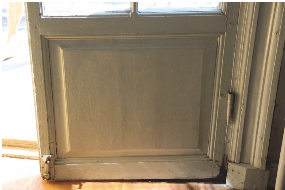
Figur 59. Inre dörrparets baksida. Foto: Lisa Skanser.
