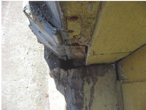
Figur 66. Rötskador i anslutningen mellan trappa och tröskel. Foto: Louise Lorichs/Gunnar Härén.
