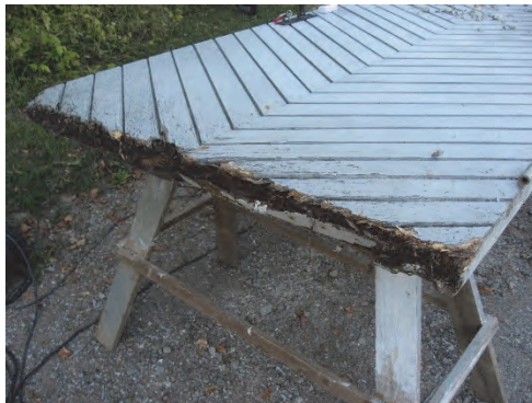
Figur 14 och 15. Åtgärdande av skador på ett av södra pochéns dörrblad. Foto: Louise Lorichs/Gunnar Härén.
