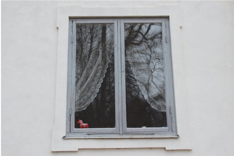
Figur 33. Fönster på norra pochens västra sida, före renovering. Foto: Lisa Skanser.
