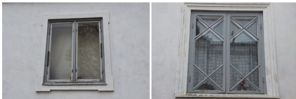
Figur 8. Tvåluftsfönster utan spröjs södra pochen före åtgärder. Foto: Lisa Skanser.
