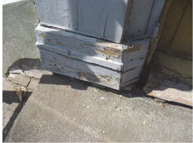
Figur 64. Rötskador i karmens nedre del, norra sidan. Foto: Louise Lorichs/Gunnar Härén.
