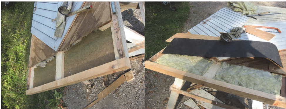
Figur 18. Åtgärdande av träram. Foto: Louise Lorichs/Gunnar Härén.
