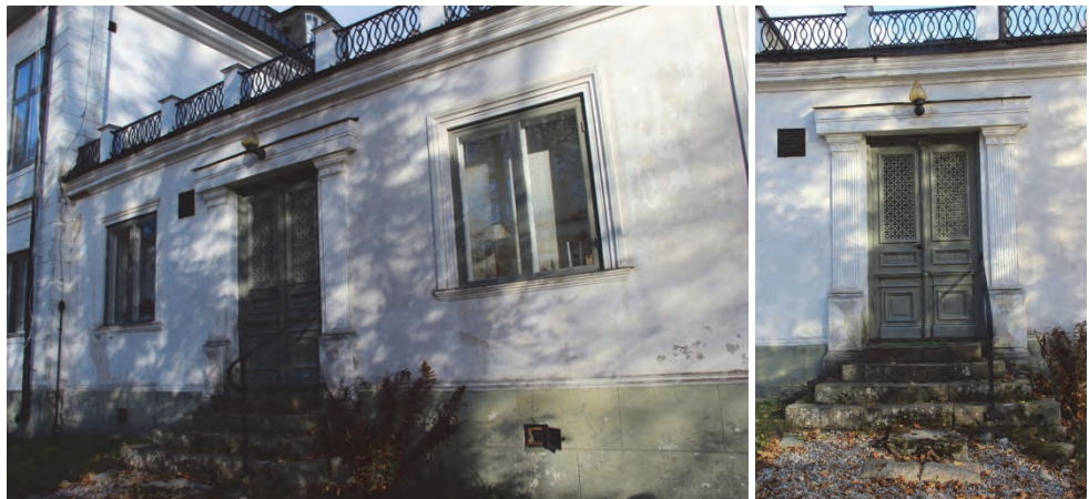
Figur 30 och 31. Södra pochens västra entré färdigställd. Foto: Lisa Skanser.
