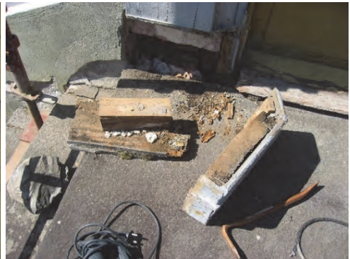
Figur 66. Rötskador i anslutningen mellan trappa och tröskel. Foto: Louise Lorichs/Gunnar Härén.
