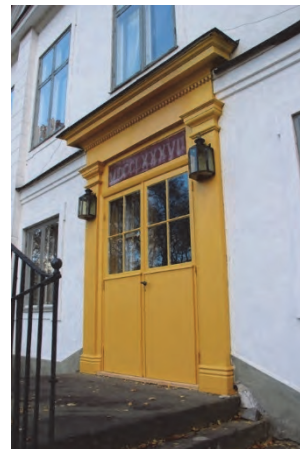
Figur 74. Entréns övre del provstruken med tre olika gula nyanser. Foto: Lisa Skanser.
