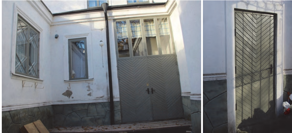
Figur 22 och 23. Färdigställda dörr- och fönsterpartier på innergården, södra pöchen. Foto: Lisa Skanser.
