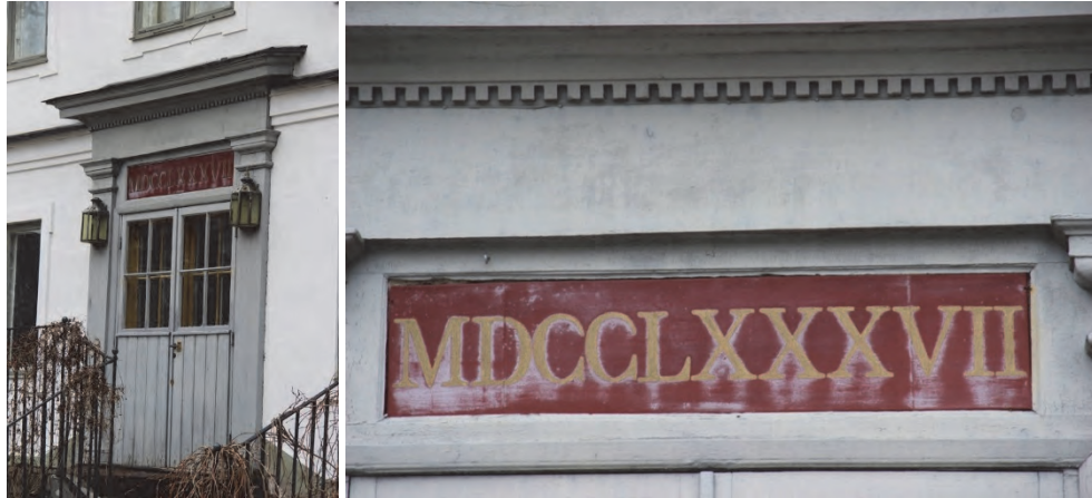
Figur 55. Östra entrén före åtgärder. Nedre delen av dörrbladen täcks med en modern, fasspontad panel. Foto: Lisa Skanser.
