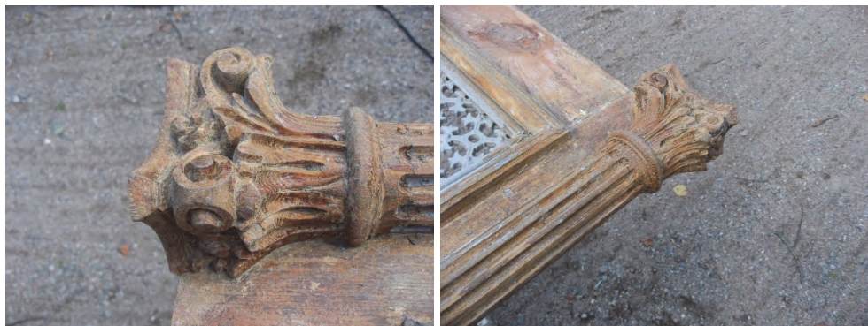
Figur 25 och 26. Dörrpartiets mittlöst har rika träsniderier. Dessa har skrapats helt rena från färg. Foto: Louise Lorichs/Gunnar Härén.
