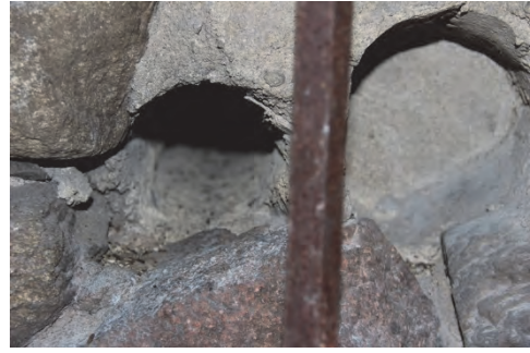
Figur 32. Befintlig håltagning i vägg mellan vind och torn. Sett från vind. Ej helt genomgående. Hålen fick borras upp sista biten från tornet mot vind. Foto: Lisa Skanser.
