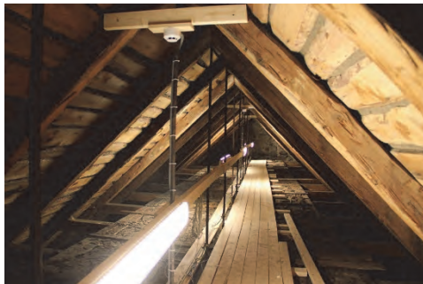
Figur 49. Nya landgångar med räcke på vinden. Foto: Lisa Skanser.
