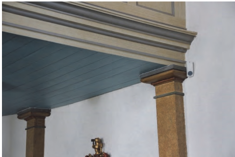
Figur 26. Rörelsedetektor placerad i anslutning till läktarbarriär. Foto: Lisa Skanser.
