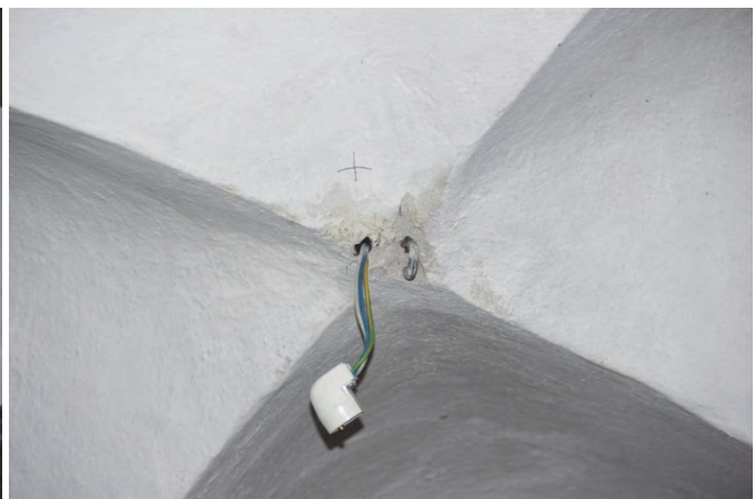
Figur 9. Sakristians valv med ljuskrona. Eldragningen till ljuskronan var inbilad i putsen. Foto: Lisa Skanser.
