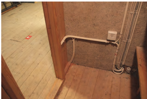
Figur 41. Skrubbs tornplan 2 eldragningar. Foto: Lisa Skanser.
