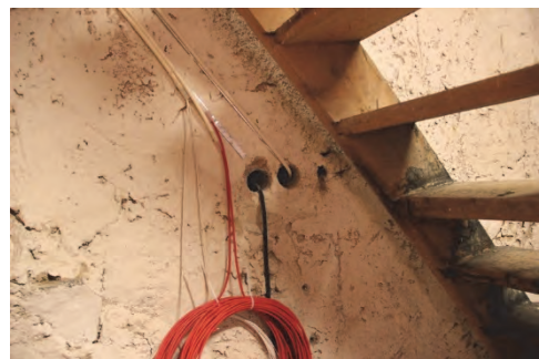
Figur 35. Befintlig håltagning i vägg mellan torn och vind. Foto: Lisa Skanser.
