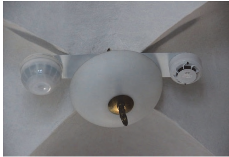
Figur 13. Brand- och rörelsedetektor placerat i sakristians valv. Foto: Lisa Skanser.
