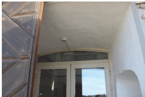
Figur 30. Branddetektor på WC i vapenhuset. Foto: Lisa Skanser.
