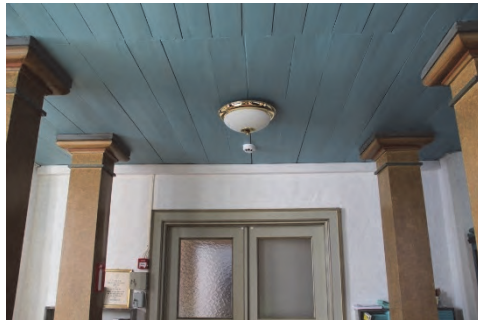
Figur 26. Rörelsedetektor placerad i anslutning till läktarbarriär. Foto: Lisa Skanser.
