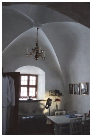
Figur 9. Sakristians valv med ljuskrona. Eldragningen till ljuskronan var inbilad i putsen. Foto: Lisa Skanser.
