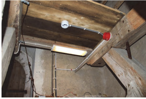
Figur 45. Brandsiren och detektor i tornet. Foto: Lisa Skanser.
