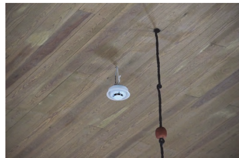
Figur 7. Långhustaket med nya branddetektorer. Foto: Lisa Skanser.
