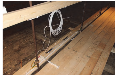
Figur 49. Nya landgångar med räcke på vinden. Foto: Lisa Skanser.
