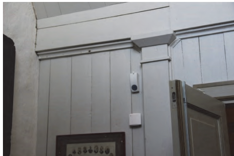
Figur 28. Larmknapp placerad under läktaren tillsammans med äldre installationer. Foto: Lisa Skanser.
