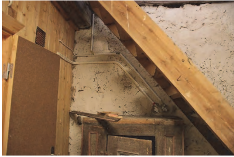
Figur 37. El- och brandkablar dragna till vindsutrymmet. Foto: Lisa Skanser.
