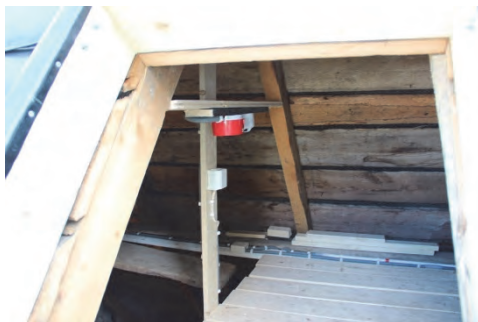
Figur 51. Detektor och siren på vinden till sakristian. Foto: Lisa Skanser.
