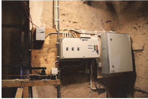
Figur 37. El- och brandkablar dragna till vindsutrymmet. Foto: Lisa Skanser.
