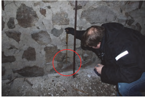
Figur 32. Befintlig håltagning i vägg mellan vind och torn. Sett från vind. Ej helt genomgående. Hålen fick borras upp sista biten från tornet mot vind. Foto: Lisa Skanser.
