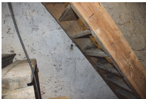
Figur 35. Befintlig håltagning i vägg mellan torn och vind. Foto: Lisa Skanser.
