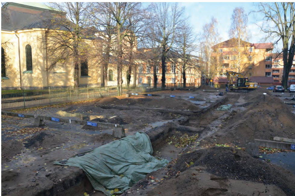
Figur 13. Översikt över norra delen av schakt 384 samt schakt 1177. Foto mot NV av Duncan Alexander.
