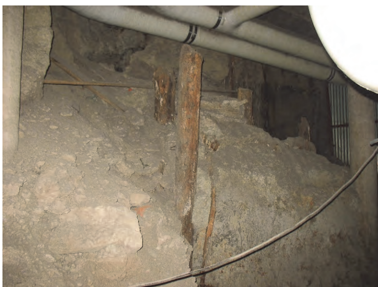
Figur 19. Öster om undersökningsområdet fanns det trästolpar som drivits ned i leran. Stolparna visade sig vara från 1800–1900-tal. Fotograferat av Jonas Ros från söder.
