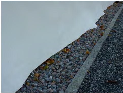
Figur 39. Murens något ojämna form gör att avståndet till kantstenen varierar. Putsen slutar strax över marknivå. Foto: Tobias Mårud.
