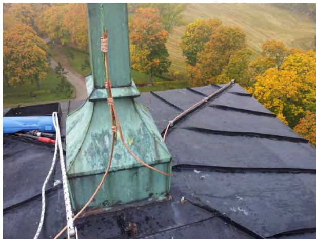
Figur 57. Åskledarens infästning vid korset. Foto: Rolf Hammarskiöld.
