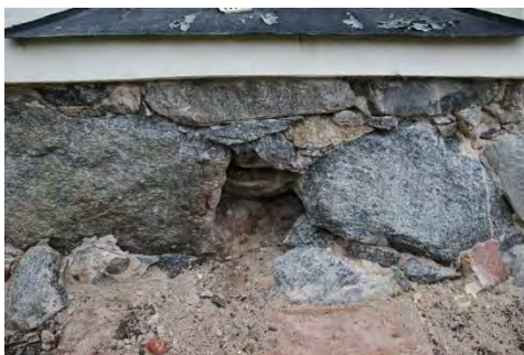
Figur 19. Hålighet som satts igen. Foto: Låsa Skanser.
