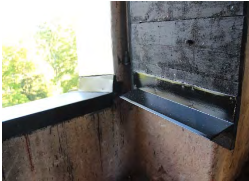
Figur 49. Plättäckning ljudlucka. Foto: Lisa Skanser.
