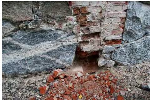
Figur 13. Teglet som anslöt mot marken var mycket vittrat och poröst. Foto: Lisa Skanser.
