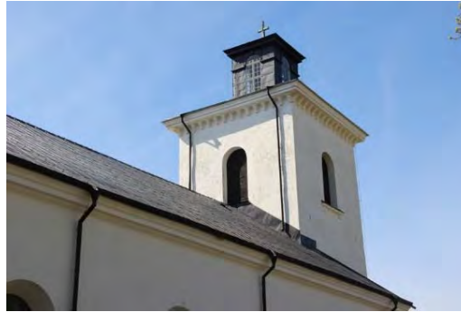
Figur 29. Tornets östra sida före montering av stuprör samt äldre åskeledare monterad kring öppning för tornlucka. Foto: Lisa Skanser.
