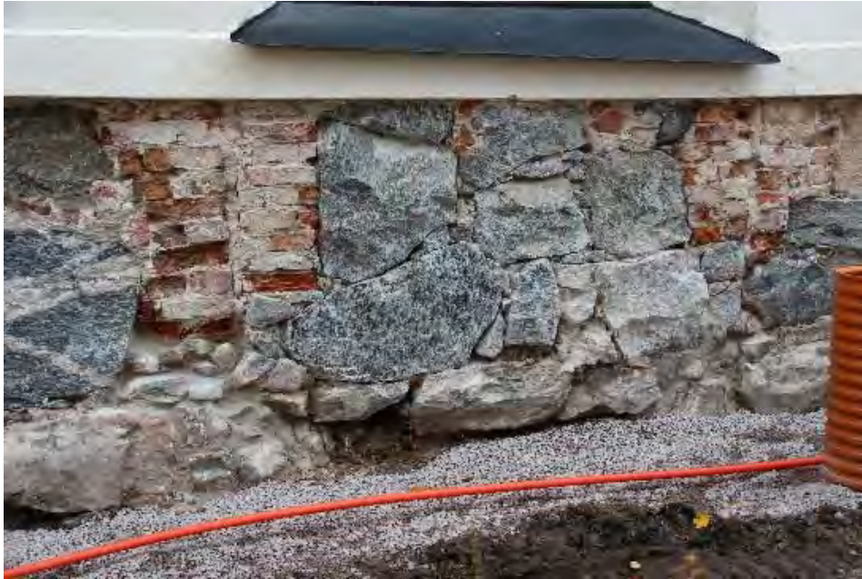
Figur 16. Igensatt öppning på södra fasaden, efter bortrensning av tegel och ifyllnad med natursten i nedre delen. Foto: Låsa Skanser.
