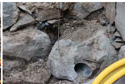
Figur 35. Håltagning genom grundmur till källaren för inkommande rör. Foto: Lisa Skanser.
