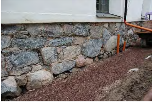
Figur 37. Dräneringsschakt återfyllt med nytt material. Foto: Lisa Skanser.
