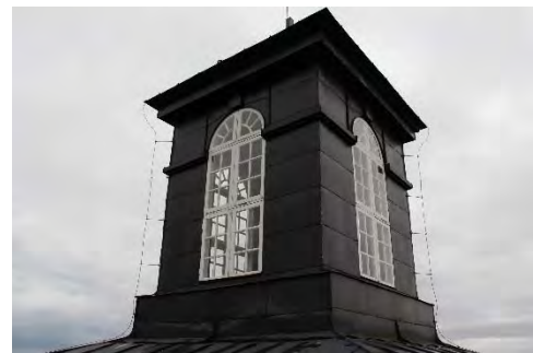
Figur 43. Äldre fästen för åskledare skruvade genom plåten. Foto: Lisa Skanser.
