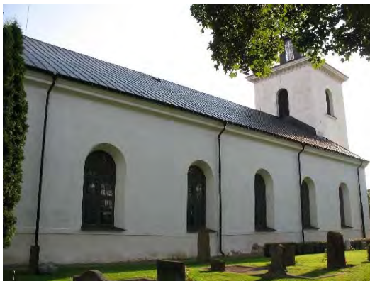
Figur 4. Kyrkan sedd från norr före åtgärder. Foto: Lisa Skanser.
