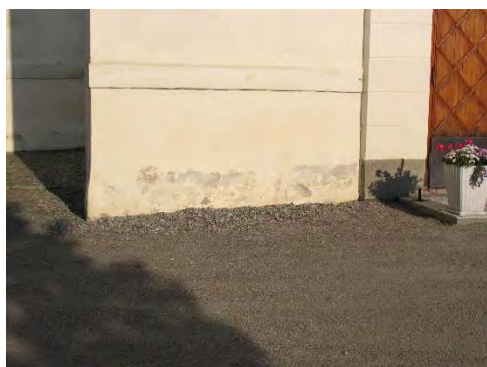
Figur 7. Putsskador på tornsockel. Foto: Lisa Skanser.
