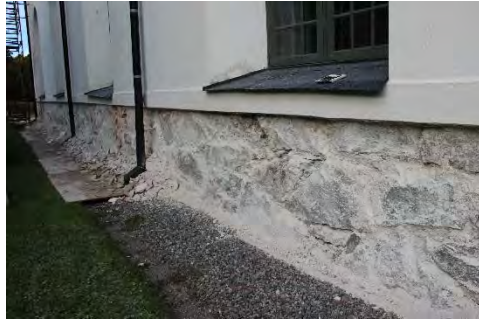
Figur 11. Norra sidans sockel renknackad. I förgrunden syns även den äldre singelbädden invid kyrkan som avgränsas mot gräsytan med betongplattor. Foto: Lisa Skanser.
