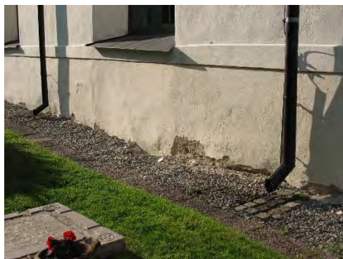
Figur 5. Problem med putsbortfall på sockeln. Foto: Lisa Skanser.
