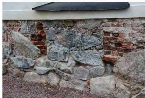
Figur 17 och 18. Partiet närmast marken är rensad från tegel och igensatt med natursten. Norra fasaden. Foto: Låsa Skanser.
