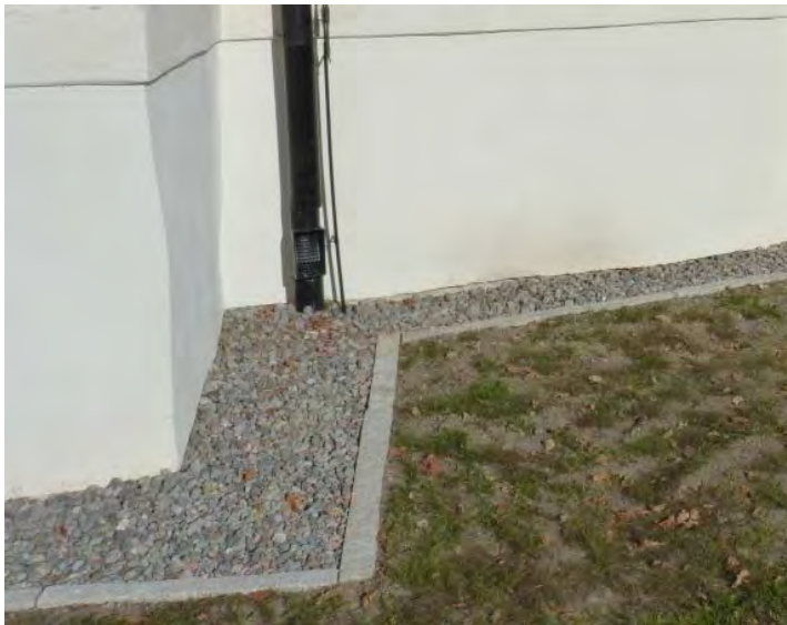
Figur 31. Stuprörens anslutning mot marken. Foto: Tobias Mårud.
