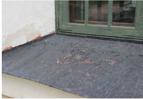
Figur 55. Äldre solbänk till långbusfönster, med rostangrepp. Foto: Lisa Skanser.
