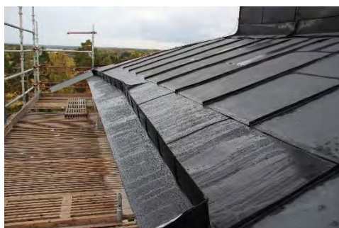
Figur 45. Ny justerad ståndränna på tornkranstakets östra sida. Foto: Lisa Skanser.
