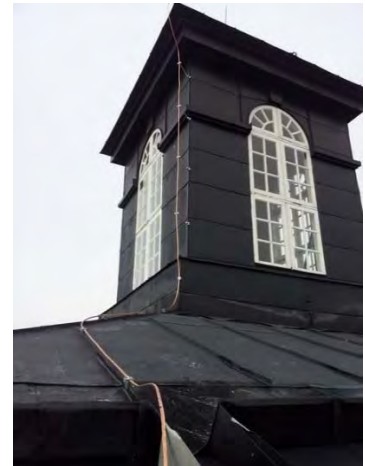
Figur 58. Åskledarens infästning på lanterninen. Foto: Rolf Hammarskiöld.
