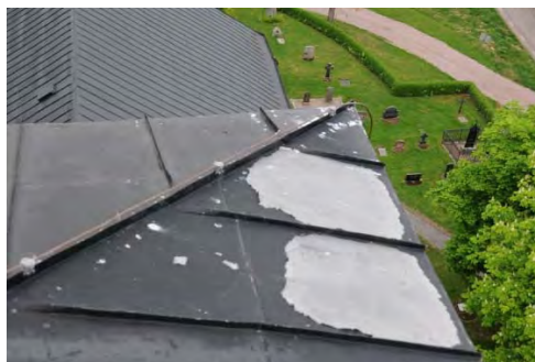
Figur 59. Åskledarens infästning på torntak. Foto: Rolf Hammarskiöld.
