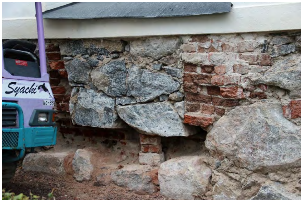
Figur 15. Bortrensat parti med tegel under den äldre igensättningen med natursten, norra fasaden. Foto: Lisa Skanser.
