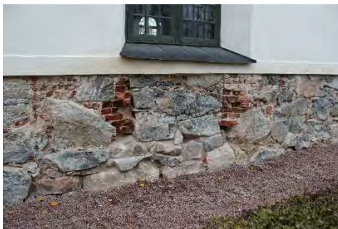
Figur 17 och 18. Partiet närmast marken är rensad från tegel och igensatt med natursten. Norra fasaden. Foto: Låsa Skanser.
