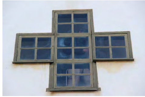
Figur 48. Tornfönstret sett från utsidan före åtgärder. Foto: Lisa Skanser.
