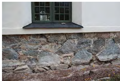
Figur 17 och 18. Partiet närmast marken är rensad från tegel och igensatt med natursten. Norra fasaden. Foto: Låsa Skanser.
