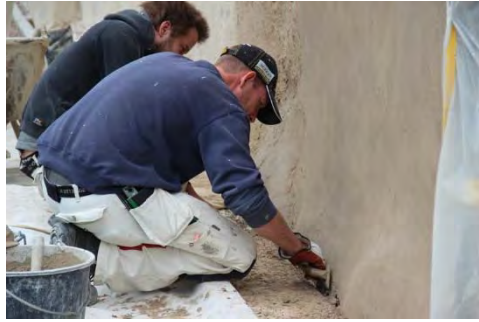
Figur 21. Putsarbeten på sockeln. Foto: Lisa Skanser.
