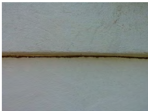
Figur 27. Kapilläravskiljande ritsning under sockelgesims. Foto: Tobias Mårud.
