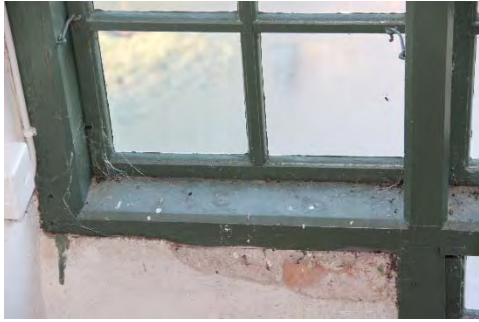
Figur 47. Tornfönstret sett från insidan. Foto: Lisa Skanser.
