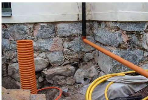
Figur 35. Håltagning genom grundmur till källaren för inkommande rör. Foto: Lisa Skanser.
