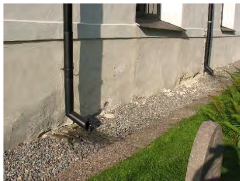
Figur 5. Problem med putsbortfall på sockeln. Foto: Lisa Skanser.
