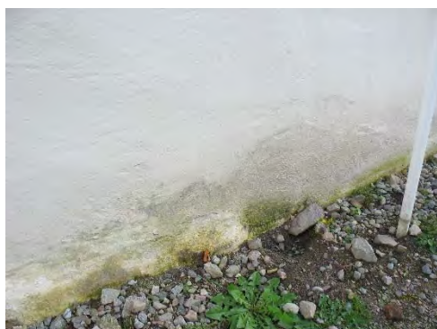
Figur 9. Fuktproblem vid sockelns nederkant. Foto: Lisa Skanser.
