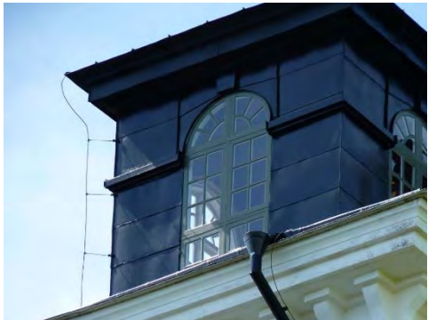
Figur 51. Lanterminen färdigställd med ny åskledarlina. Foto: Tobias Mårud.
