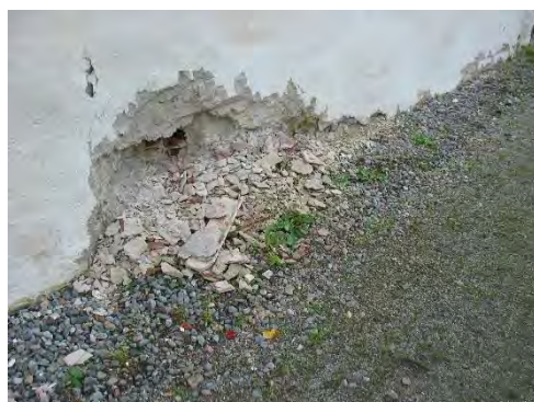
Figur 5. Problem med putsbortfall på sockeln. Foto: Lisa Skanser.
