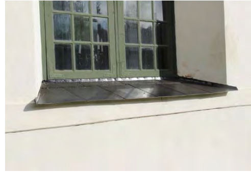
Figur 55. Äldre solbänk till långbusfönster, med rostangrepp. Foto: Lisa Skanser.
