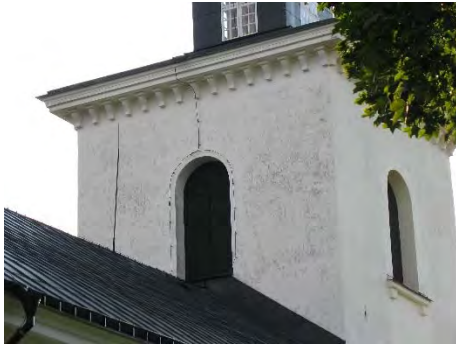
Figur 29. Tornets östra sida före montering av stuprör samt äldre åskeledare monterad kring öppning för tornlucka. Foto: Lisa Skanser.
