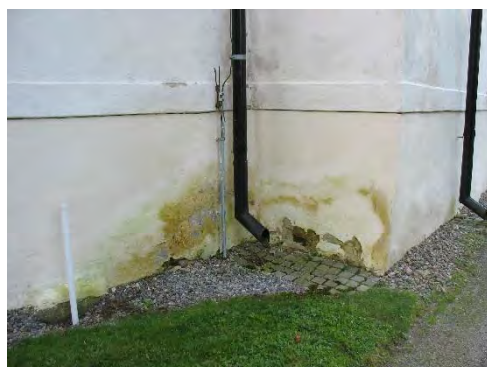
Figur 9. Fuktproblem vid sockelns nederkant. Foto: Lisa Skanser.
