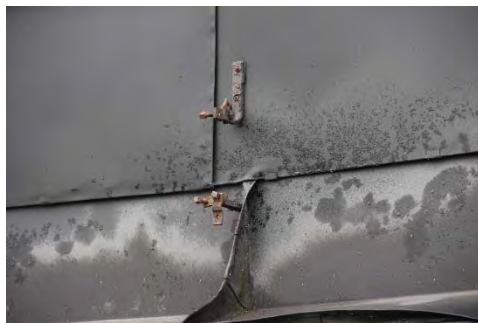
Figur 43. Äldre fästen för åskledare skruvade genom plåten. Foto: Lisa Skanser.
