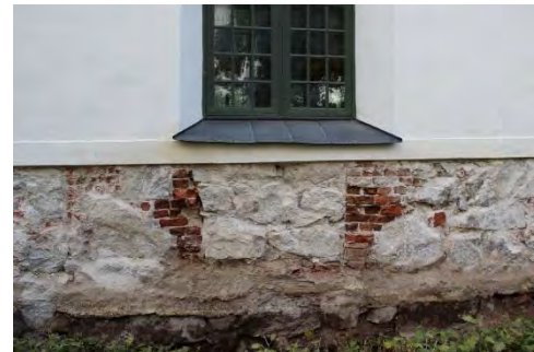
Figur 13. Teglet som anslöt mot marken var mycket vittrat och poröst. Foto: Lisa Skanser.
