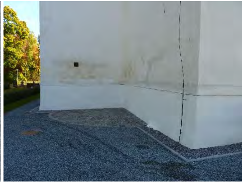
Figur 39. Murens något ojämna form gör att avståndet till kantstenen varierar. Putsen slutar strax över marknivå. Foto: Tobias Mårud.
