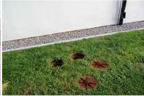
Figur 37. Dräneringsschakt återfyllt med nytt material. Foto: Lisa Skanser.
