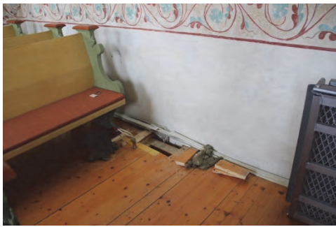
Figur 5. Upptaget golv för åtkomst av kabelkanal utmed norra långhusväggen. Foto: Lisa Skanser. Figur 6. Befintlig lösning med kablar i plastlister på golv utmed vägg och pelare. Foto: Lisa Skanser.
