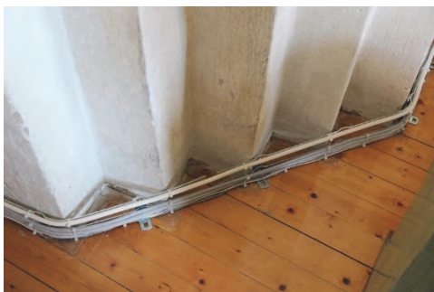
Figur 9. Nydragning av el vid pelare. Foto: Lisa Skanser. Figur 10. Eldragningarna doldes med en kabellåda av trä. Foto: Lisa Skanser.
