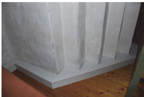
Figur 9. Nydragning av el vid pelare. Foto: Lisa Skanser. Figur 10. Eldragningarna doldes med en kabellåda av trä. Foto: Lisa Skanser.
