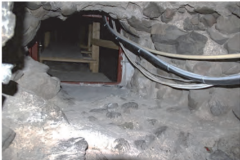
Figur 21. Anslutning mellan torn och långhusvind med eldragningar. Foto: Lisa Skanser.
