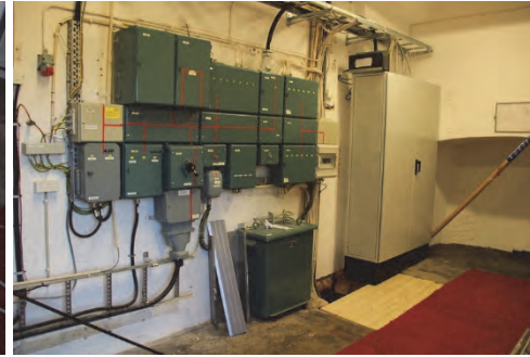
Figur 20. Genomförda åtgärder. Bl.a. har en ny täckning av eldragningschakt tillkommit. Foto: Lisa Skanser.
