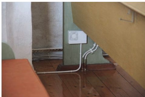
Figur 11. Ny kabellåda skymtar vid pelarens anslutning till golvet. Foto: Lisa Skanser. Figur 12. Befintliga eldragningar och installationer utmed norra väggen. Foto: Lisa Skanser.
