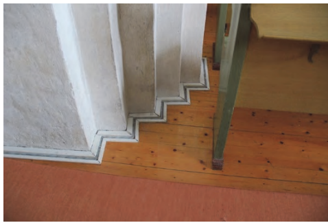
Figur 5. Upptaget golv för åtkomst av kabelkanal utmed norra långhusväggen. Foto: Lisa Skanser. Figur 6. Befintlig lösning med kablar i plastlister på golv utmed vägg och pelare. Foto: Lisa Skanser.
