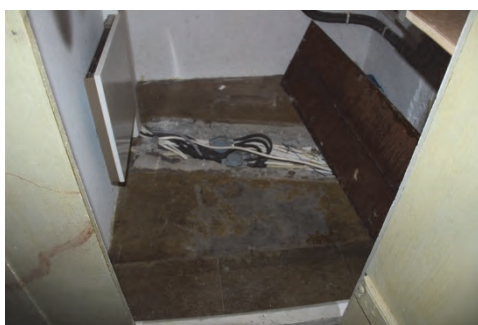
Figur 18. Schakt för eldragningar i elcentralens golv. Foto: Lisa Skanser.
