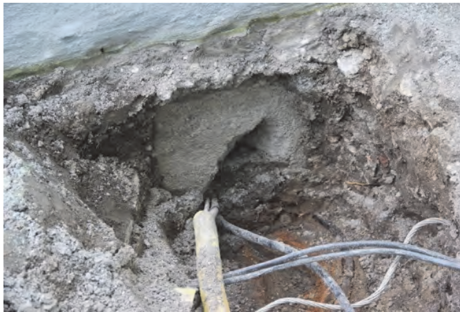
Figur 6. Håltagning genom grundmur till transformatorrum. Foto: Lisa Skanser.
