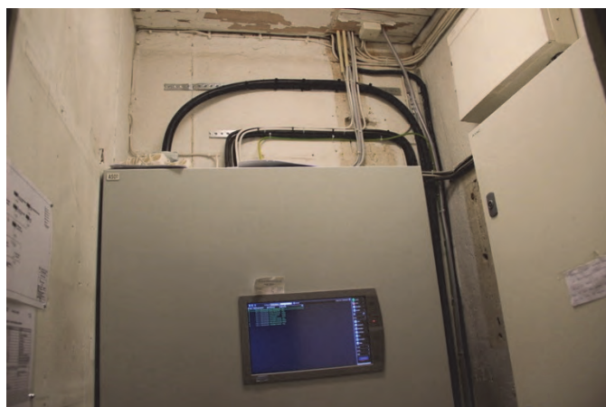
Figur 16. Befintlig huvudcentral placerad under läktartrappan. Foto: Lisa Skanser.
