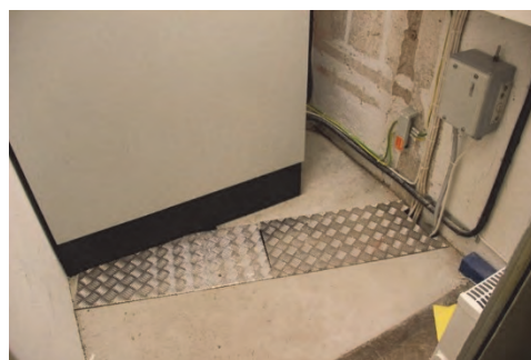
Figur 21. Golvet i elcentralen har fått ny, omgjuten yta. Plåt täcker schakt för dragning av kablar och spillvattenrör. Foto: Lisa Skanser.
