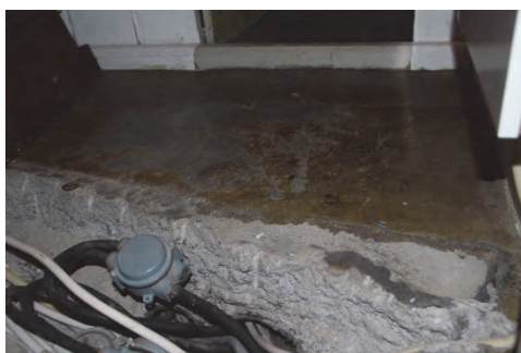
Figur 20. Kabelschakt. Foto: Lisa Skanser.
