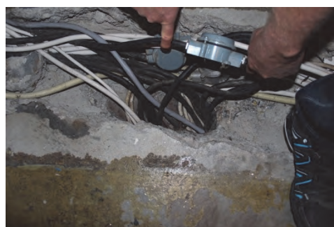
Figur 18. Schakt för eldragningar i elcentralens golv. Foto: Lisa Skanser.
