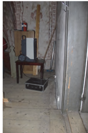
Figur 15. Anfuktare ställd på på tillfälligt bord på läktaren. Foto: Lisa Skanser.
