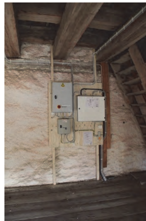
Figur 27. Ny elcentral och klockringningsutrustning monterad på en ny plyfaskiva i tornrum. Foto: Lisa Skanser.
