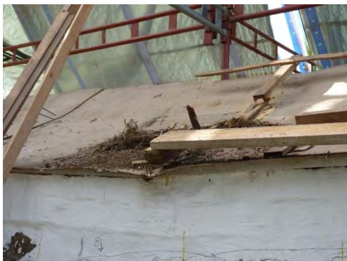
Figur 20. Träfiberskiva under avtäckningen, här skada från tidigare fågelbo.
