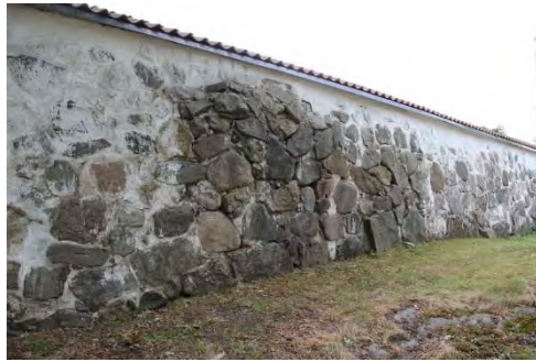
Figur 38. Norra sidan innan åtgärd. Foto: Lisa Skanser, KM.
