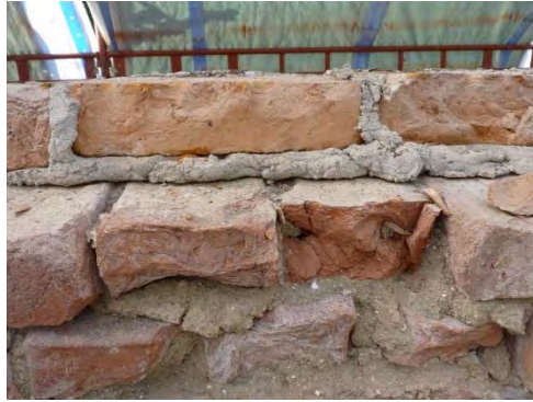
Figur 22. Detalj från muravjämningen visar ett senare övre varv i cementbruk.
