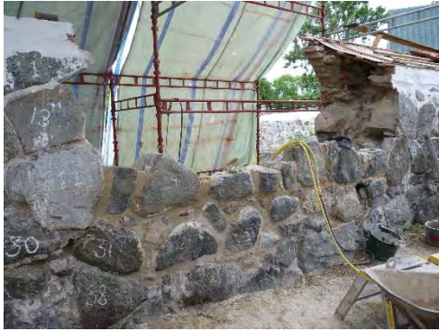
Figur 30. Norra sidan under återuppmurning.
