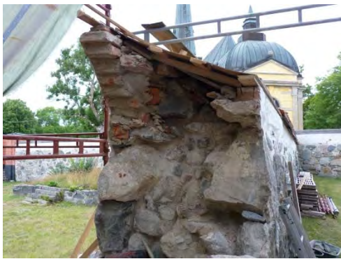
Figur 16. Västra delen av muren i parti I under återuppmurning.
