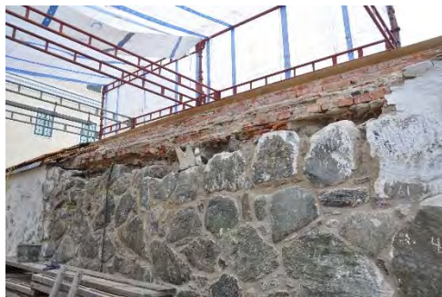
Figur 26. I parti III åtgärdades kärnan och norra skalmuren.
