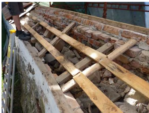
Figur 20. Träfiberskiva under avtäckningen, här skada från tidigare fågelbo.
