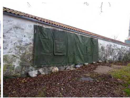
Figur 39. Efter åtgärd täcktes partiet av ett klimatskydd. Endast norra sidan åtgärdades.
