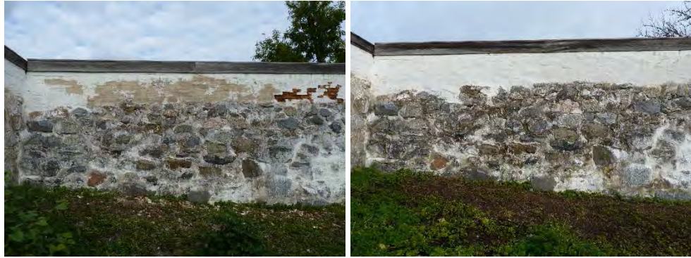
Figur 12. Samma område under pågående putsarbete.
