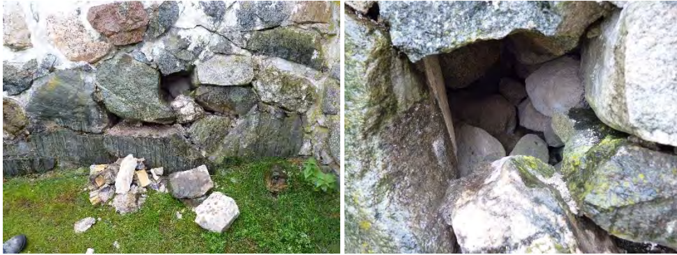
Figur 6. Muren undersöktes på den planerade placeringen av dragstag D1
