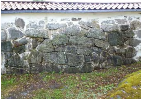
Figur 36. Norra sidan innan åtgärd. Foto: Lisa Skanser, KM.
