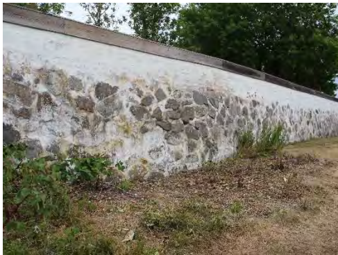
Figur 32. Södra sidan innan arbetet inletts. Foto: Lisa Skanser, KM.
