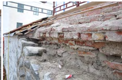
Figur 25. En av tre grunda gropar som grävdes för att stötta muren på södra sidan intill parti II.
