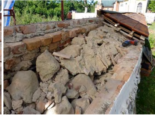
Figur 22. Detalj från muravjämningen visar ett senare övre varv i cementbruk.
