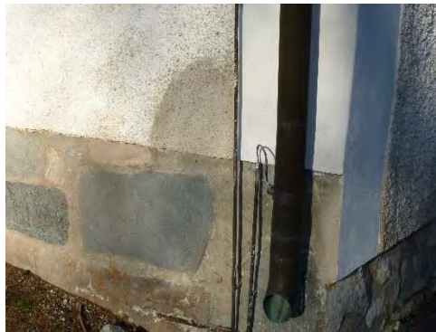
Figur 24. En mindre yta av spritputsen knackades ned vid sydöstra hörnet. Ytan anfärgades senare. Foto: Tobias Mårud.
