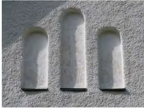
Figur 6. Tre blinderingar som markerar äldre fönster på östra gaveln uppvisade omfattande "flagning" av kalkavfärgningen innan åtgärd. Foto: Tobias Mårud.
