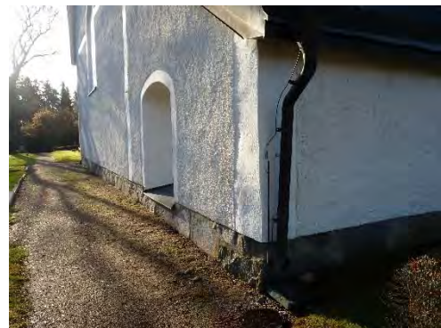
Figur 12. Hörnkedjan på sakristians nordöstra hörn uppvisade sprickor och skadad anfärgning innan åtgärd. Foto: Tobias Mårud.
