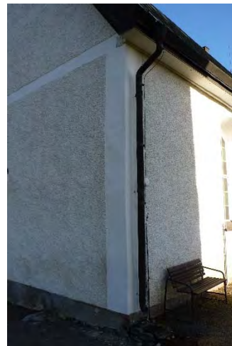
Figur 19. Det sydvästra hörnet efter åtgärd. Det tidigare lösa stupröret har fästs. Foto: Tobias Mårud.
