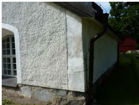
Figur 12. Hörnkedjan på sakristians nordöstra hörn uppvisade sprickor och skadad anfärgning innan åtgärd. Foto: Tobias Mårud.
