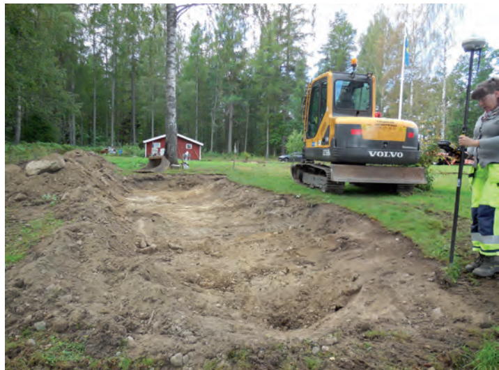
Figur 3. Undersökning av schakt 1. Andrea Jäderlund mäter. Från nordost. Foto: Ann Vinberg.
