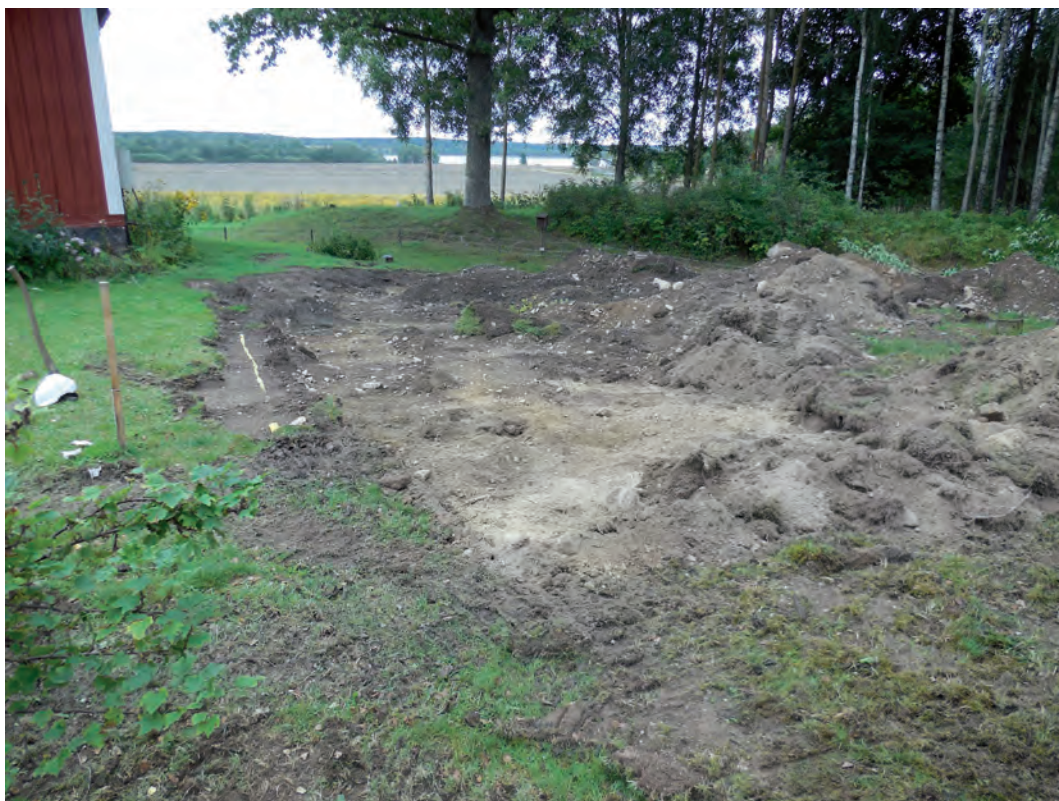
Figur 5. Östra delen av schakt 1. I dungen bortom schaktet ligger gravfältet Bärbo 16:1. I bakgrunden syns sjön Långhalsen. Från sydväst. Foto: Ann Vinberg.
