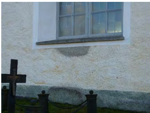
Figur 35. Lagning av spritputs under fönstret i norra fasaden. Foto: Tobias Mårud.
