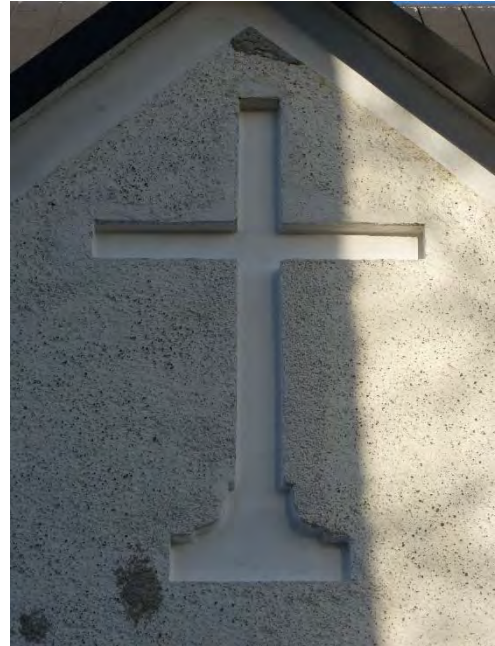
Figur 27. Blinderingskorset i vapenhusets gavel uppvisade putsskador, färgflagnig och bättringsmålning med akrylatfärg. Foto: Tobias Mårud.
