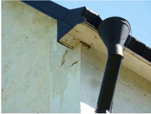
Figur 33. Övre delen av kyrkans sydvästra hörn hade kraftigare sprickebildning samt skador i puts och avfärgning. Foto: Tobias Mårud.
