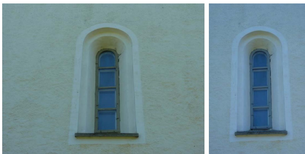
Figur 4. Den romanska fönsteröppningen i västra gaveln innan åtgärder... Foto: Tobias Mårud.
