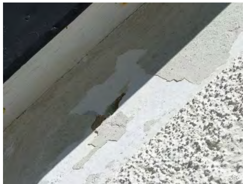
Figur 29 och 30. Slätputsens flagade på många ställen, här på vapenhuset, s.k. "äggskafeffekt" där avfärgningen släpper från underlaget. Foto: Tobias Mårud.
