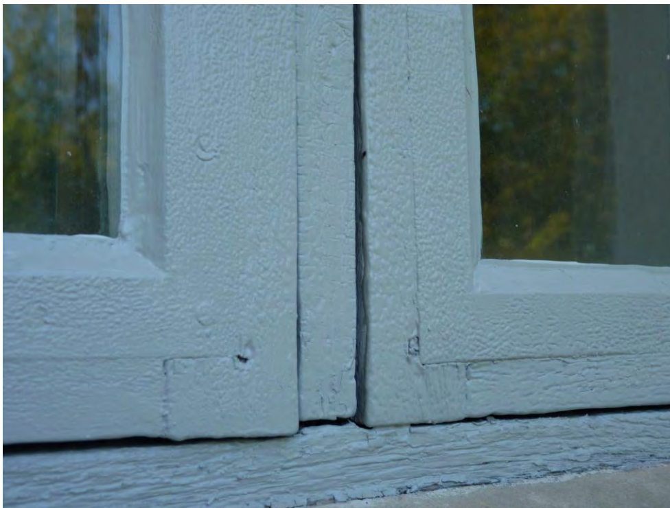
Figur 26. Sakristians fönster uppvisar bubblor i färgen, det är från äldre färgskikt som trots bubblor bedömts vara i god kondition. Foto: Tobias Mårud.
