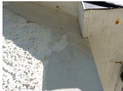
Figur 29 och 30. Slätputsens flagade på många ställen, här på vapenhuset, s.k. "äggskafeffekt" där avfärgningen släpper från underlaget. Foto: Tobias Mårud.
