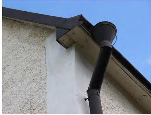
Figur 33. Övre delen av kyrkans sydvästra hörn hade kraftigare sprickebildning samt skador i puts och avfärgning. Foto: Tobias Mårud.
