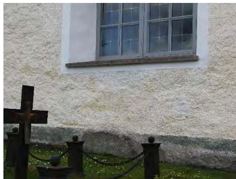
Figur 35. Lagning av spritputs under fönstret i norra fasaden. Foto: Tobias Mårud.
