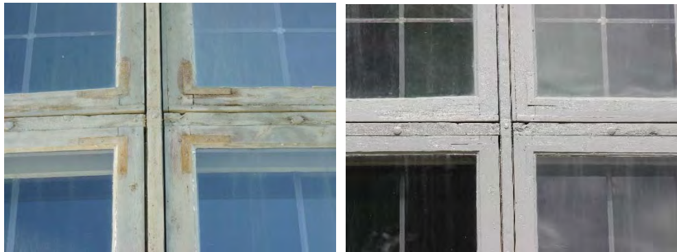
Figur 20. Detalj av södra fasadens östra fönster innan åtgärder... Foto: Tobias Mårud.
