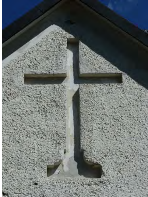
Figur 27. Blinderingskorset i vapenhusets gavel uppvisade putsskador, färgflagnig och bättringsmålning med akrylatfärg. Foto: Tobias Mårud.
