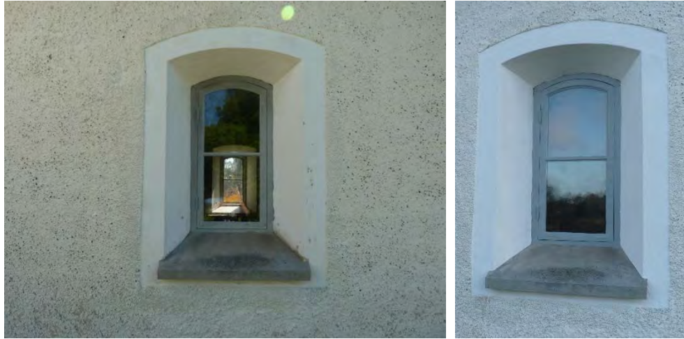
Figur 18. Vapenbusets västra fönster innan åtgärder... Foto: Tobias Mårud.
