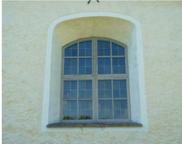
Figur 6. Norra fasadens fönster innan åtgärder... Foto: Tobias Mårud.
