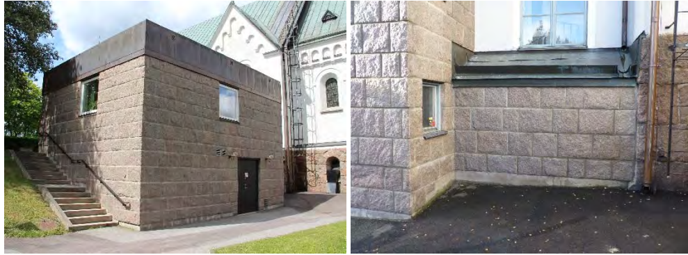
Figur 8. Tillbyggnaden sedd från sydöst efter åtgärd. Foto: Tobias Mårud.
