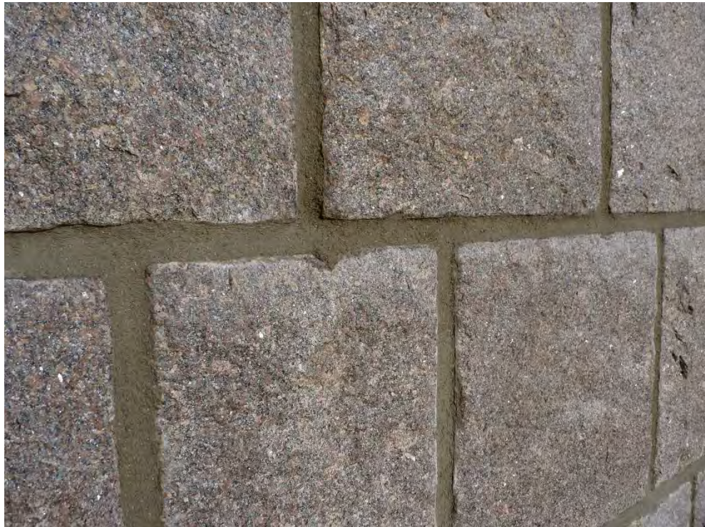
Figur 10. Del av det omfogade murverket. Foto: Tobias Mårud.
