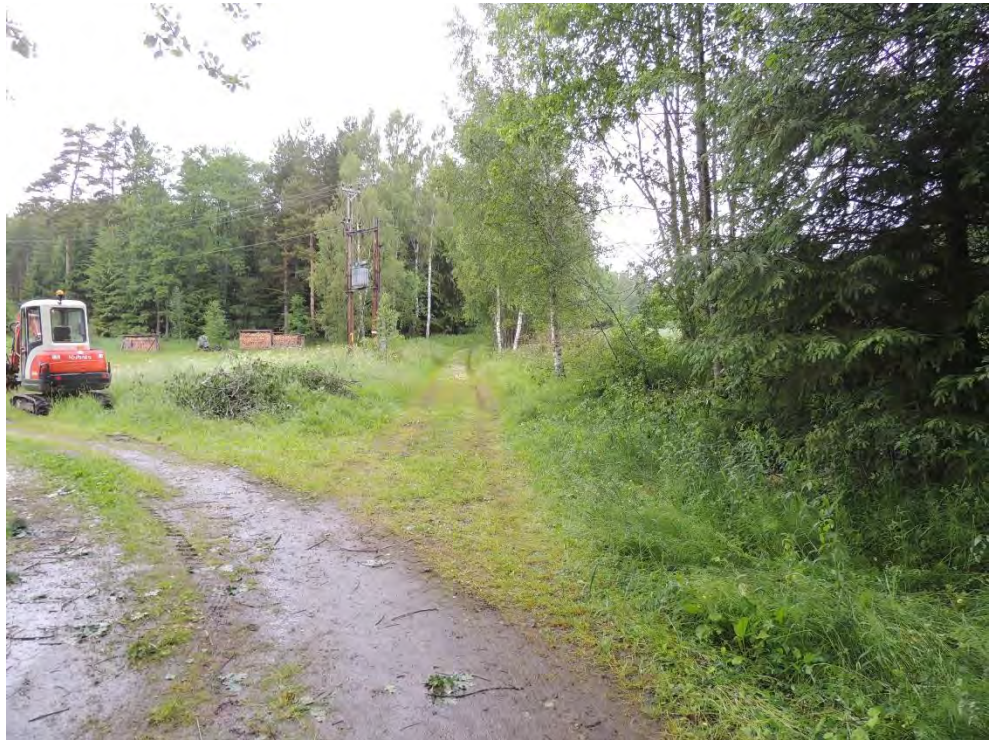
Figur 3. Norra delen av vägsträckningen, innan påbörjat schaktarbete. Foto från söder (KM14054_1) Ingela Harrysson
