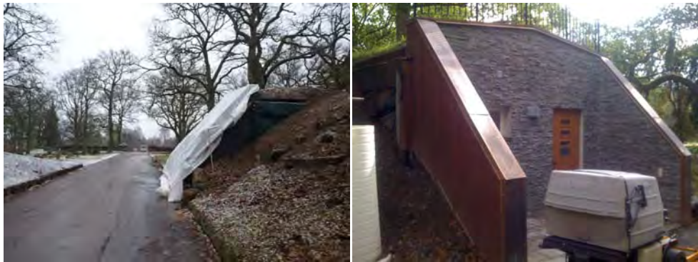
Figur 8. Byggnaden sedd från söder under byggnation. Foto: Helén Sjökvist.
