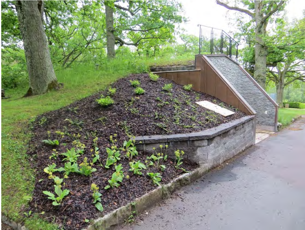
Figur 14. Stödmur och täckta sidor på byggnaden. Foto: Helén Sjökvist.
