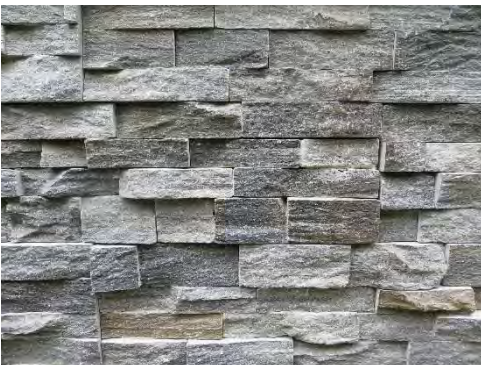
Figur 12. Stenfasaden med skifferplattor. Foto: Helén Sjökvist.
