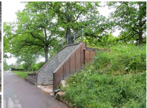
Figur 13. Sidorna koppartäckta även på byggnadens sidor, där jorden tidigare inte låg kvar. Foto: Helén Sjökvist.
