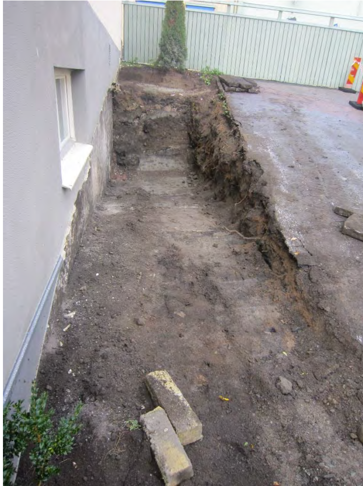
Figur 4. Schaktet sett mot norr. Foto: Kristina Jonsson.
