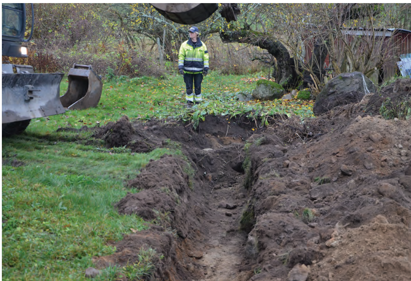
Figur 4. Den mellersta delen av ledningsschaktet med den större öppnade ytan för trekammarbrunnen i bortre delen av bilden. Fotograferat från norr av Anna-Lena Hallgren.
