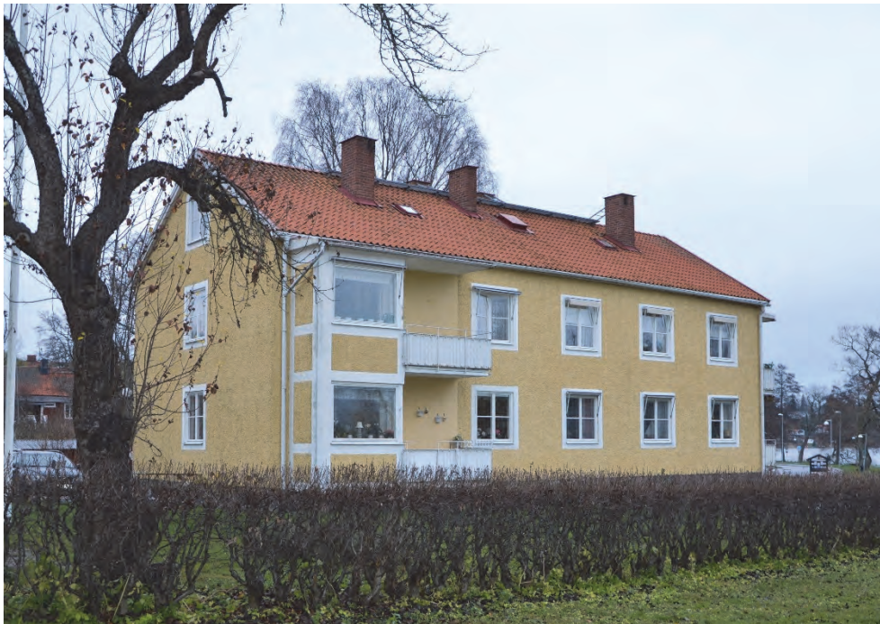
Figur 2. Det schaktades för dränering på den vänstra och hitre delen av det gula huset. Till höger ses Mälaren. Fotograferat från nordväst av Jonas Ros.
