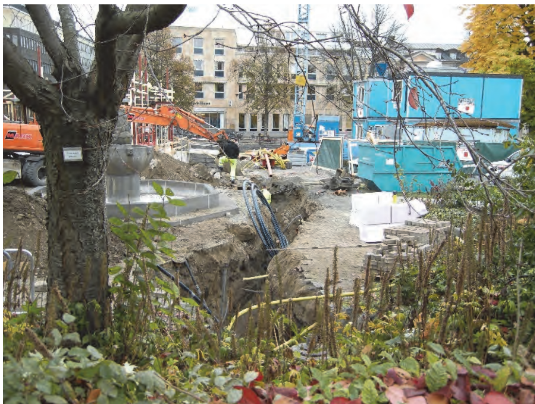
Figur 10. Undersökningsområdet med schaktet där det påträffades vikingatida och medeltida kulturlager i Stadsparken i schakt 4. Kulturlager fanns endast bevarade i den högra, södra, schaktväggen. Fotograferat från väster från Slottsgatan av Jonas Ros.
