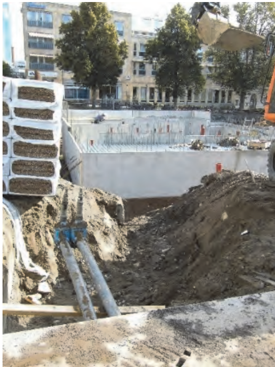
Figur 9. Schakt 3. I bakgrunden ses grunden till restaurangen. Fotograferat från väster av Jonas Ros.
