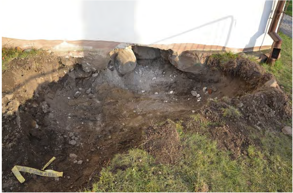
Figur 3. Schaktet mot vapenhusets västra vägg. Delar av kyrkans grundmur har exponerats, och en av stenarna i muren har (tillfälligt) lyfts bort. Foto mot öst av Kristina Jonsson.
