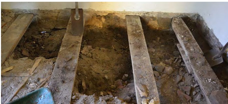
Figur 6. Schaktet i vapenhuset. Foto mot väst av Kristina Jonsson.
