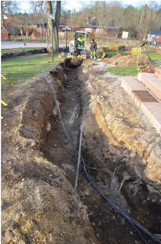
Figur 5. Schaktsträckan över kyrkogården. Till höger i bild ses trappan upp till ingången i kyrkans västtorn. Foto mot norr av Kristina Jonsson.
