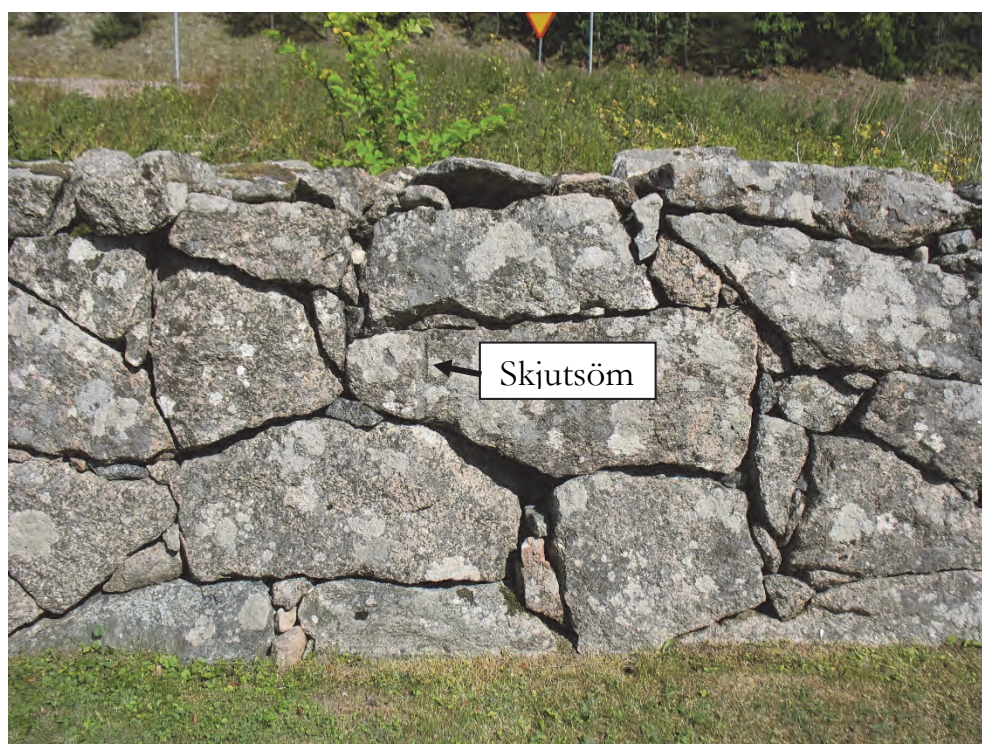
Figur 16. Den aktuella kyrkogårdsmuren hade skjutsömmar och klyvsömmar. Vidare var stenblocken bearbetade så att de passar mot varandra. Muren bedöms vara uppförd under 1800-talet. Del av muren strax söder om platsen där kraniet påträffades. Fotograferat av Jonas Ros från väster.
