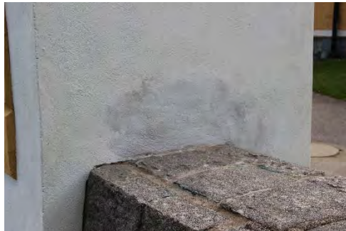
Figur 22 & 23. Putsens anfärgning är bitvis flammig, främst vid mötet med muren (vänster bild). Socklarnas KC-puts avlägsnades och ersattes med hydraulisk kalkputs (höger bild). Foto: Tobias Mårud.
