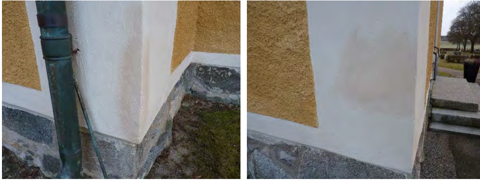
Figur 26 & 27. Ytterligare ett par mindre putslagningar genomfördes på kyrkans slätputsade partier, vänster bild visar kyrkans nordvästra hörn, höger bild visar vapenhusets nordvästra hörn. Foto: Tobias Mårud.
