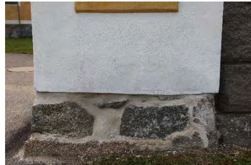
Figur 22 & 23. Putsens anfärgning är bitvis flammig, främst vid mötet med muren (vänster bild). Socklarnas KC-puts avlägsnades och ersattes med hydraulisk kalkputs (höger bild). Foto: Tobias Mårud.
