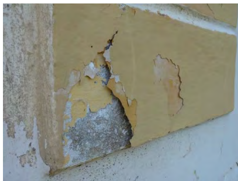
Figur 10 & 11. Avfärgningen släpper, såväl äldre lager som senaste. Foto: Tobias Mårud.
