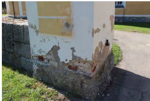
Figur 6 & 7. Puttsläpp och begränsade murskador på grindstolparnas nedre delar, främst på den östra (vänstra bilden). Foto: Låsa Skanser.
