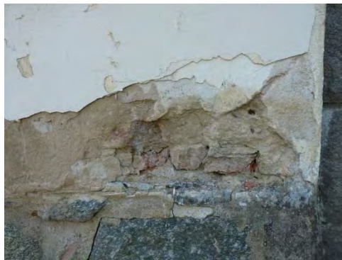
Figur 8 & 9. Skada som går in i murverket på den västra grindstolpen (vänster bild). Mötet med muren är ett återkommande problemområde (höger bild). Foto: Tobias Mårud.
