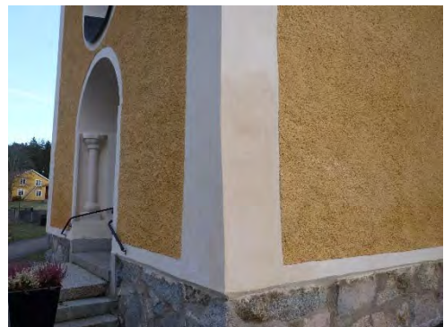
Figur 24 & 25. Anfärgningen av putslagningarna på kyrkofasaden var först för ljus (se vänster bild) men åtgärdades enligt recept från 2004 (se höger bild). Foto: Tobias Mårud.
