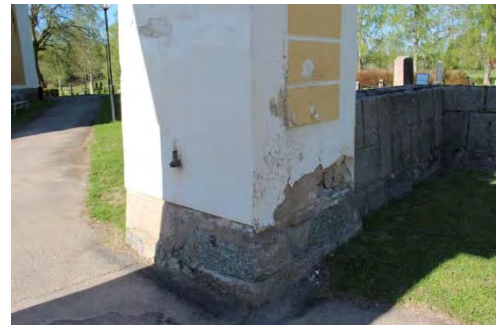
Figur 6 & 7. Puttsläpp och begränsade murskador på grindstolparnas nedre delar, främst på den östra (vänstra bilden). Foto: Låsa Skanser.
