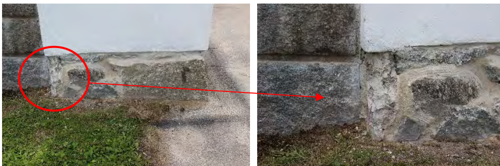
Figur 28 & 29. Nordöstra hörnet på östra grindstolpen har slagits av. Foto: Tobias Mårud.
