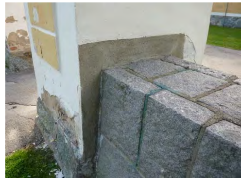
Figur 8 & 9. Skada som går in i murverket på den västra grindstolpen (vänster bild). Mötet med muren är ett återkommande problemområde (höger bild). Foto: Tobias Mårud.
