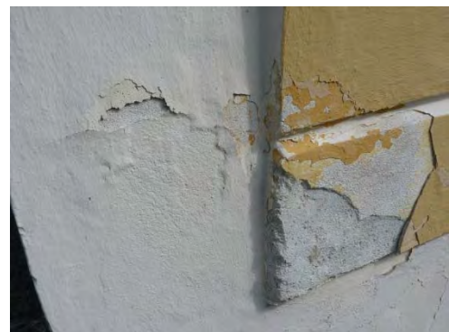
Figur 10 & 11. Avfärgningen släpper, såväl äldre lager som senaste. Foto: Tobias Mårud.
