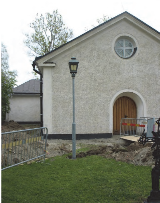
Figur 19. I schakt 2, väster om kyrkan, framkom grundstenar som bedöms kunna vara fundamentet till en klockstapel. Fotograferat från väster av Jonas Ros.
