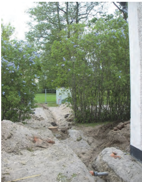
Figur 12. I schakt 3:s norra del och ut mot parkeringsplatsen framkom grus och sand. På platsen där kyrkogårdsmuren bör ha legat fanns det en brunn. Fotograferat från söder av Jonas Ros.
