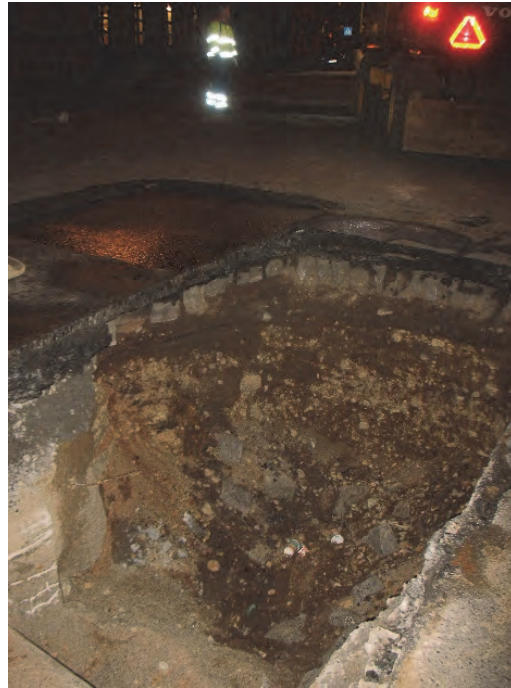
Figur 13. Schaktet i Malmskillnadsgatan. Bland grus- och sandmassorna fanns det människoben. Under asfalten ses storgatsten. Till vänster ses kulverten. Fotograferat från nordväst av Jonas Ros.
