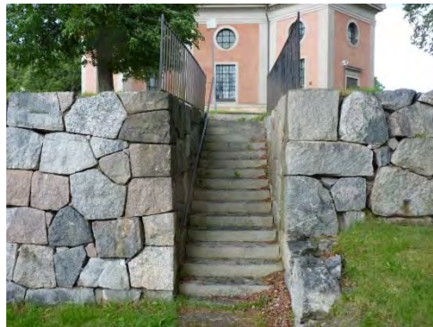
Figur 30. Nordöstra delen av murpartiet innan åtgärd. Observera trädet i murverket. Foto: Tobias Mårud.
