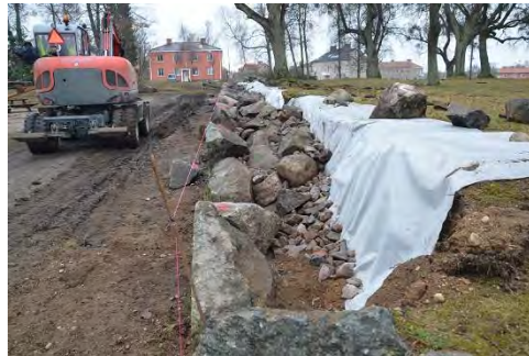
Figur 15. Arbetet med omläggningen utförs bitvis, några meter i taget. Här är sista delen av sektion 2 på gång att muras upp varefter utrymmet bakom murfasaden fylls. Foto: Tobias Mårud.
