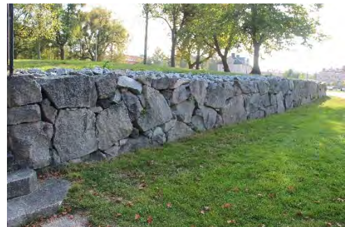
Figur 38. Nedrasad sten ur murkrön söder om trappan. Foto: Tobias Mårud.
