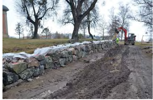
Figur 18. Murpartiet innan åtgärd. Rasrisken var stor och då en lekplats ligger intill hade ett staket satts upp av säkerhetsskäl. Foto: Tobias Mårud.
