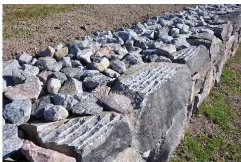
Figur 42. Tydliga bearbetningsmärken på murkrön, senare nedtonade. Foto: Tobias Mårud.
