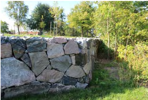
Figur 28. Endast den östra änden lades om, där framför röjdes en större yta. Foto: Tobias Mårud.
