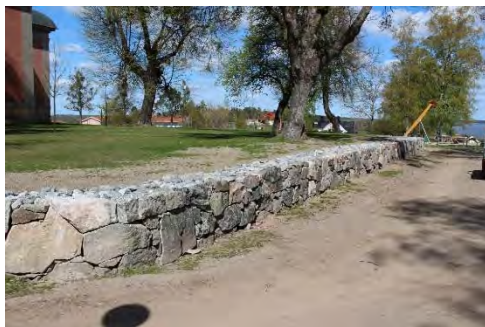
Figur 20. Murpartiet har precis färdigställts. Foto: Tobias Mårud.
