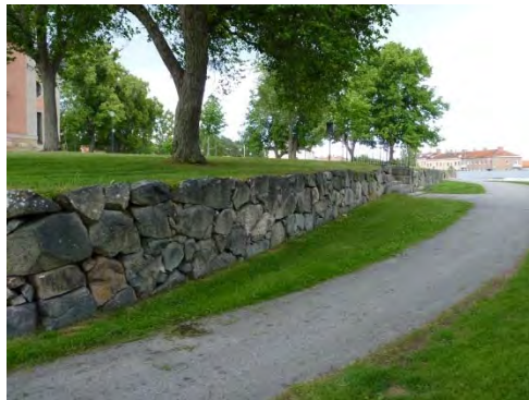
Figur 36. Murpartiet innan åtgärd. Foto: Tobias Mårud.
