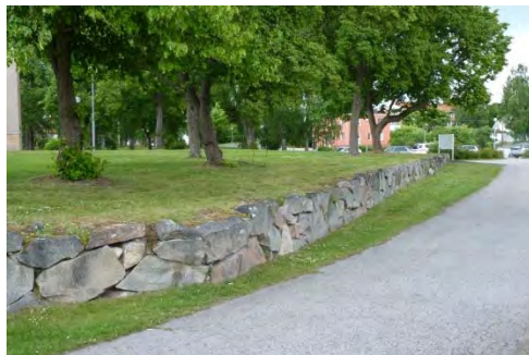
Figur 40. Murpartiet innan åtgärd. Foto: Tobias Mårud.
