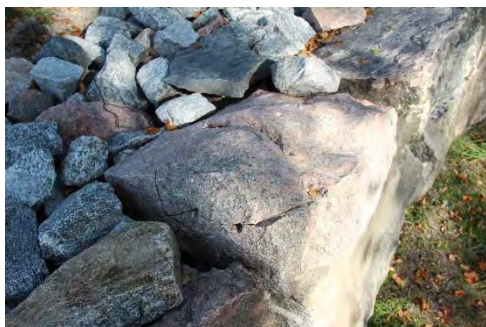
Figur 44. Sprucken sten till följd av borrhål. Foto: Tobias Mårud.
