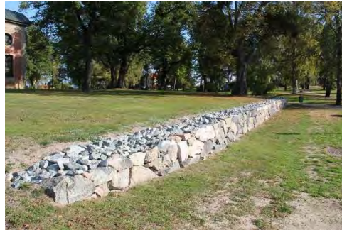
Figur 12. Här har muren lagts om och fyllnadsarbetet pågår. Foto: Tobias Mårud.
