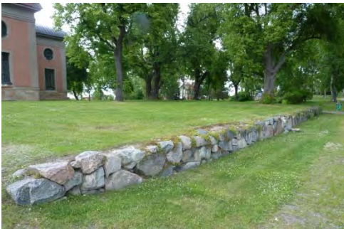
Figur 10. Murpartiet innan åtgärd. Foto: Tobias Mårud.
