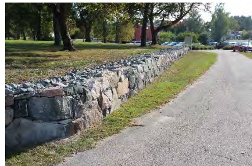
Figur 41. Murpartiet efter åtgärd. Främst har murkrönets täckning ändrats. Foto: Tobias Mårud.
