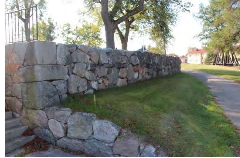
Figur 35. Sydvästra delen av murpartiet efter åtgärd. Här utfördes endast en punktåtgärd. Foto: Tobias Mårud.
