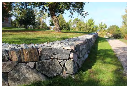
Figur 43. Borrhål för att möjliggöra maskinlyft, med risk för framtida frostsprängning. Foto: Tobias Mårud.
