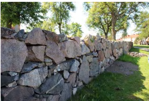
Figur 32. Trädet i murverket har tagits bort och muren har punktvís lagts om. Foto: Tobias Mårud.
