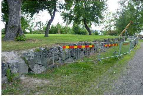
Figur 18. Murpartiet innan åtgärd. Rasrisken var stor och då en lekplats ligger intill hade ett staket satts upp av säkerhetsskäl. Foto: Tobias Mårud.
