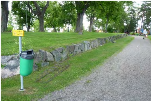
Figur 14. Murpartiet innan åtgärd. Foto: Tobias Mårud.
