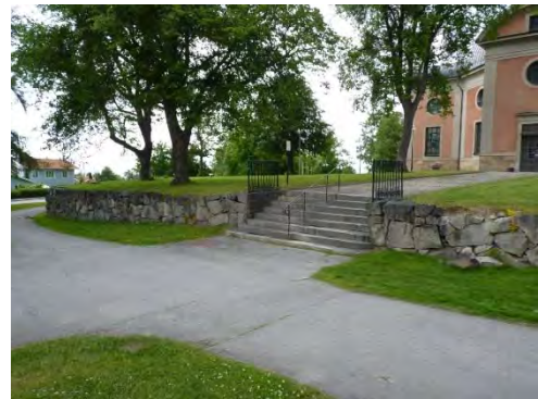
Figur 37. Trappan centralt i murpartiet krävde justering av ett par av stegen. Foto: Tobias Mårud.
