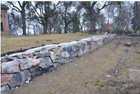
Figur 12. Här har muren lagts om och fyllnadsarbetet pågår. Foto: Tobias Mårud.
