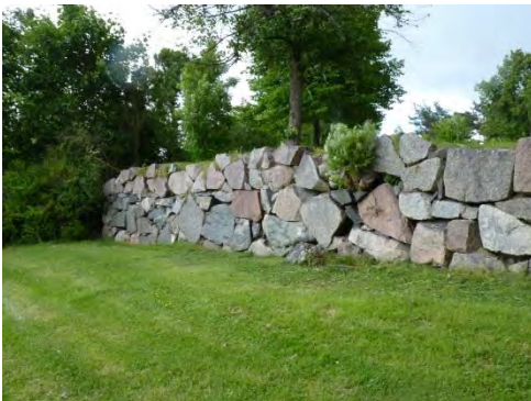
Figur 30. Nordöstra delen av murpartiet innan åtgärd. Observera trädet i murverket. Foto: Tobias Mårud.
