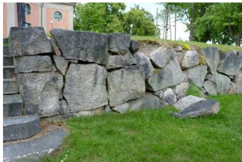
Figur 38. Nedrasad sten ur murkrön söder om trappan. Foto: Tobias Mårud.
