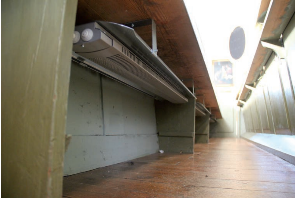
Figur 13. De nya konvektorerna på plats. Foto: Tobias Mårud.
