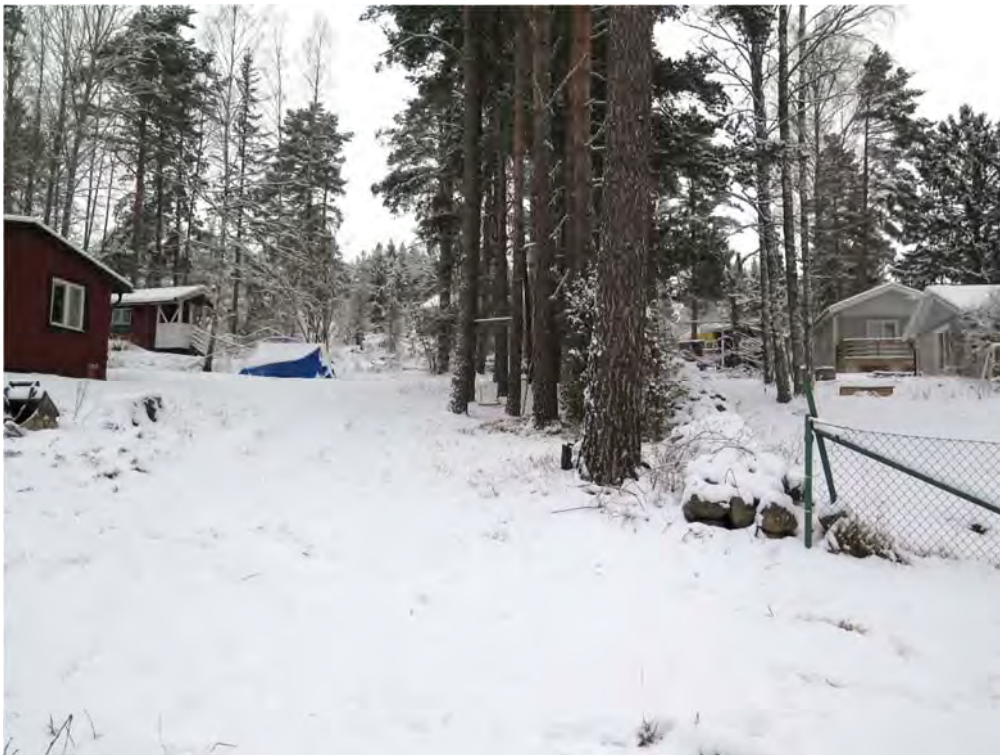
Figur 4. Arbetsområdets nedre del före schaktning. Från söder. Foto: Mattias Johansson.
