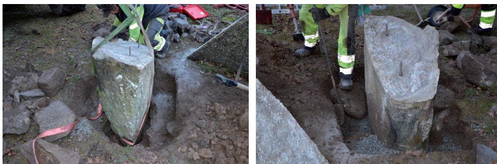
Figur 9. Stävstenen groundsätts och kilas fast med stödstenar och grus. Foto: Birgitta Larsson.
