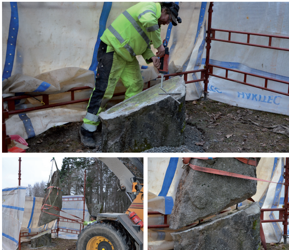
Figur 11. Övre bild: stenlim och fogningsmassa appliceras. Nedre bilder: överdelen lyfts och lotsas på plats. Foto: Birgitta Larsson.
