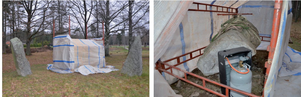
Figur 10. Ett värmetält uppfördes över natten för att värma upp stenarna inför limning dagen därpå. Foto: Birgitta Larsson.
