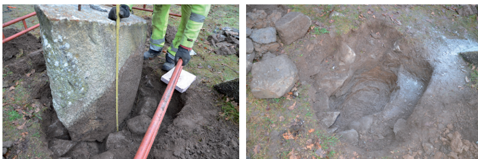
Figur 8. Till vänster: Rätad och riktad sten med exponerade stödstenar. Till höger: Hålet efter nedgrävning i orörd lera. Foto: Birgitta Larsson.
