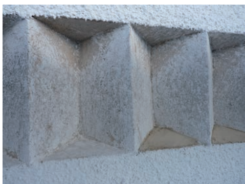
Figur 13. Pågående arbete med blinderingarnas undre kant. Foto: Tobias Mårud.
