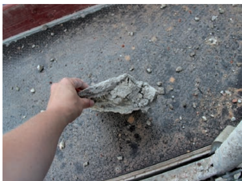
Figur 11. Putsnedfall med tjockt lager av cement. Foto: Lisa Skanser.
