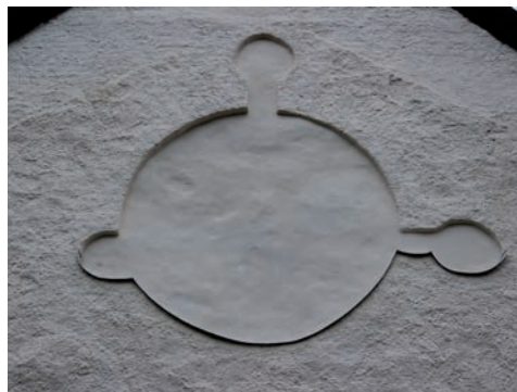
Figur 29. Södra korsarmens nedre blinding med spritputs, innan åtgärd. Foto: Tobias Mårud.
