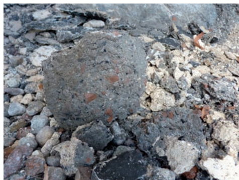
Figur 31. Exempel på sockelns kondition innan åtgärd. Foto: Tobias Mårud.
