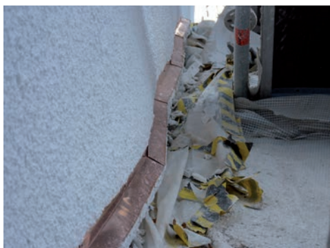
Figur 25. Skyddsplåt över ståndplåten på långhusets södra takfall, under arbetets gång. Observera murverkets böljande linje. Foto: Tobias Mårud.
