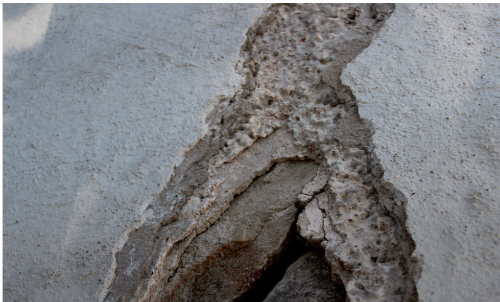
Figur 10. Putsstratigrafi, visar fyra putsskikt, överst en vit kalkputs, därunder en grå cementhaltig puts, sedan en tydligt framträdande spritputs (från 1881-82) och underst en slät ljusgrå kalkputs, möjligen medeltida. Foto: Lisa Skanser.
