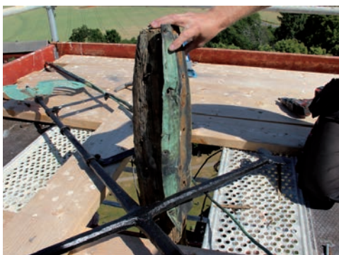
Figur 15. Placeringen av en av kopparplåtarna förevisas. Foto: Lisa Skanser.
