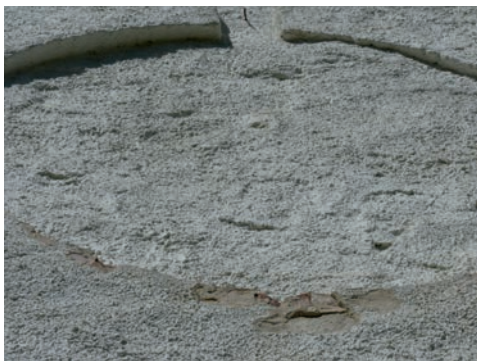
Figur 29. Södra korsarmens nedre blinding med spritputs, innan åtgärd. Foto: Tobias Mårud.
