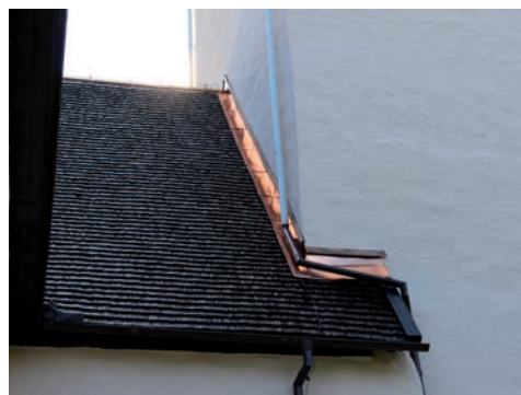
Figur 25. Skyddsplåt över ståndplåten på långhusets södra takfall, under arbetets gång. Observera murverkets böljande linje. Foto: Tobias Mårud.
