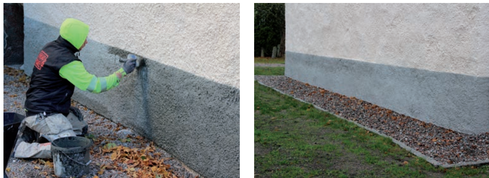
Figur 33. Sockeln fick en andra strykning under september 2014, men kan möjligen behöva ytterligare en strykning under 2015. Foto: Tobias Mårud.
