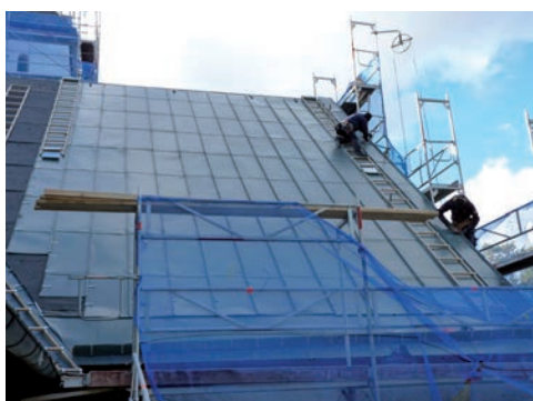
Figur 23. Den nya plåten har nästan lagts klart. Foto: Tobias Mårud.
