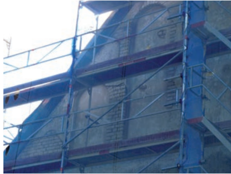
Figur 27. Nedknackning av bomputs på norra korsarmens gavelfasad. Foto: Tobias Mårud.
