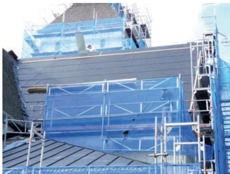
Figur 21 & 22. Norra korsarmens östra takfall, den äldre plåten plockas ned och på höger bild har plywood spikats och underlagspapp lagts. Foto: Tobias Mårud.
