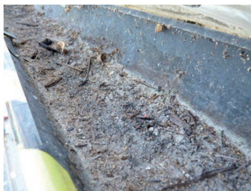
Figur 19. Hängränna som delvis är fylld med tjära och skräp. Foto: Tobias Mårud
