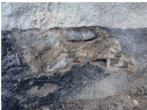
Figur 31. Exempel på sockelns kondition innan åtgärd. Foto: Tobias Mårud.
