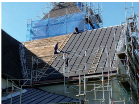
Figur 21 & 22. Norra korsarmens östra takfall, den äldre plåten plockas ned och på höger bild har plywood spikats och underlagspapp lagts. Foto: Tobias Mårud.
