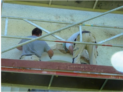
Figur 27. Nedknackning av bomputs på norra korsarmens gavelfasad. Foto: Tobias Mårud.
