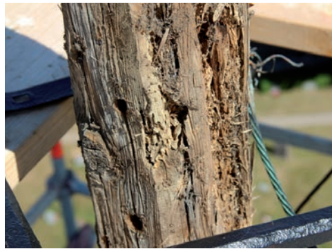
Figur 17. Detalj som visar rötskador och insektsangrepp i ytveden. Foto: Lisa Skanser.
