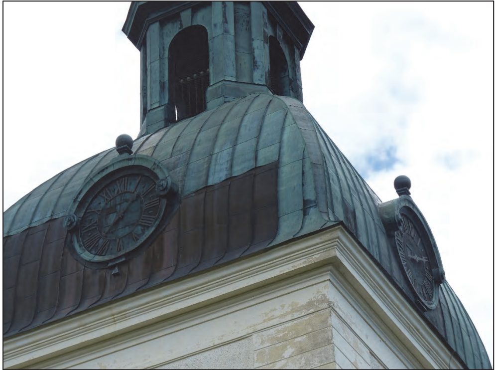
Figur 4. Lanternin och tornbuv före åtgärder på urtavlor. Förgyllningen på siffror, visare och kulor är i princip helt borta. Foto: Helén Sjökvist 2010.
