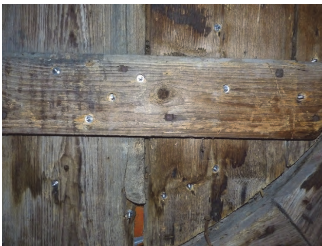
Figur 38. De romerska siffrorna är monterade med rostfri skruv och skruvbrickor i befintliga hål. Foto: Helén Sjökvist.
