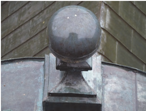
Figur 40. Kula som kröner den östra urtavlan före åtgärder samt tidigare monterat bönsnät. Foto: Herbert Sandner.
