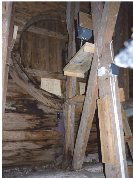
Figur 32. Norra sidans urtavla efter renovering och med inkopplat motorverk till uret. Foto: Helén Sjökvist.
