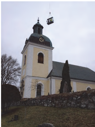
Figur 42. Nedhyftning av korset utfördes med hjälp av kran. Foto: Herbert Sandner.
