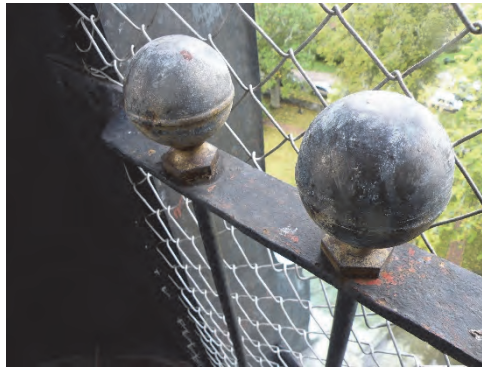
Figur 40. Kula som kröner den östra urtavlan före åtgärder samt tidigare monterat bönsnät. Foto: Herbert Sandner.
