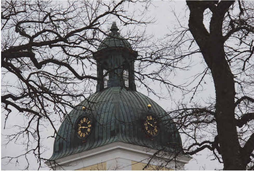
Figur 51. Urtanlor och kulor förgyllda, men korset är ännu ej återmonterat. Foto: Helén Sjökvist.
