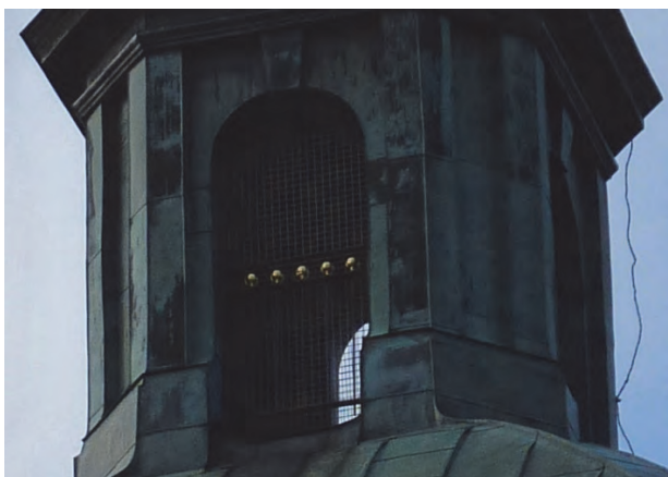
Figur 54. Nytt galler i lanterninen ersatte tidigare bönsnät. Foto: Helén Sjökvist.
