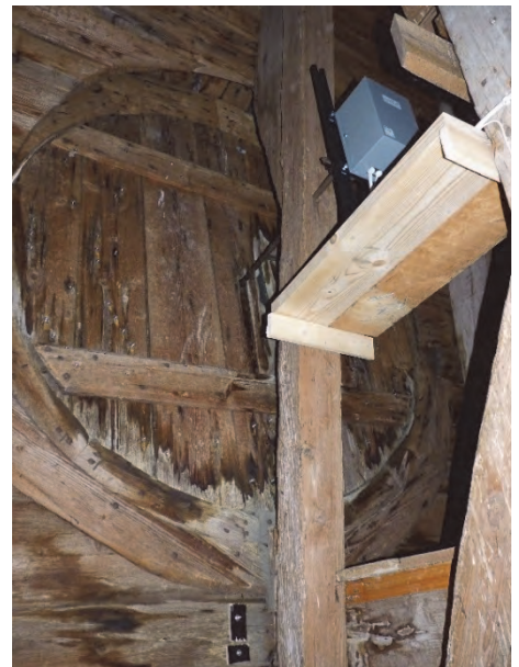
Figur 32. Norra sidans urtavla efter renovering och med inkopplat motorverk till uret. Foto: Helén Sjökvist.
