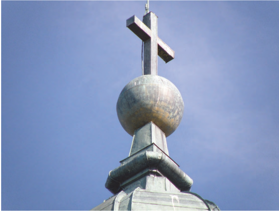
Figur 39. Korset och kulan före åtgärder. Förgyllningen helt bortnött. Foto: Herbert Sandner.
