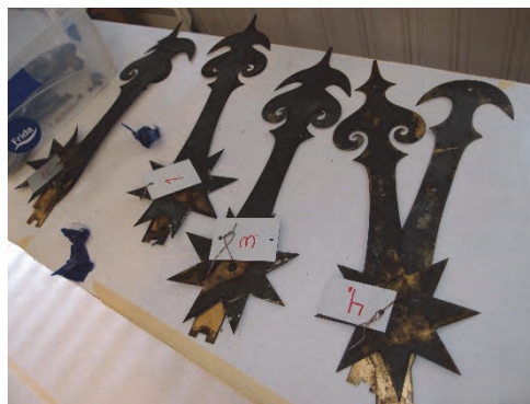
Figur 43. Nya ekstavar på en av urtavlor. Stavarna har legat i bad med kinesisk träolja. Foto: Herbert Sandner.
