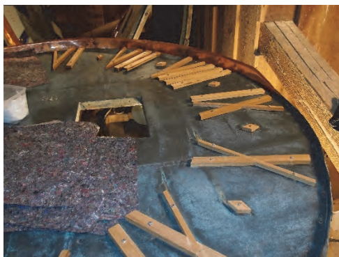
Figur 43. Nya ekstavar på en av urtavlor. Stavarna har legat i bad med kinesisk träolja. Foto: Herbert Sandner.
