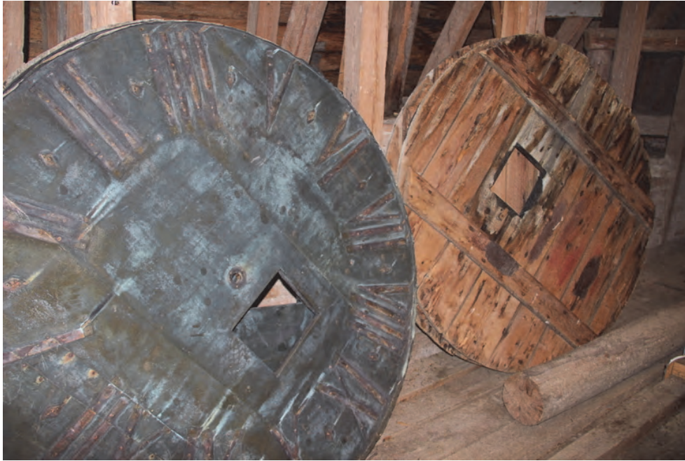
Figur 14. Urtavlorna har en trästomme vilka hade vissa små rötskador. Foto: Lisa Skanser.
