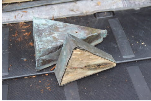
Figur 17. Guttadroppar med träfyllning. Foto: Lisa Skanser.
