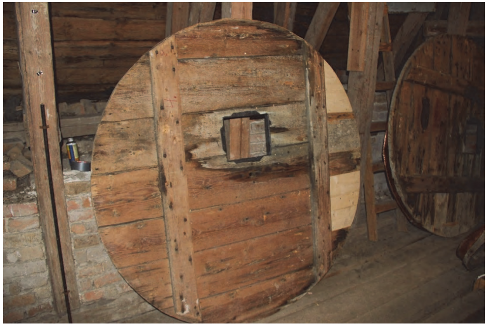
Figur 31. Lagning av stomme till urtavla. Foto: Lisa Skanser.
