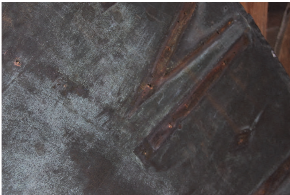
Figur 13. Detalj av urtavlorna med borttagna siffror. Foto: Lisa Skanser.
