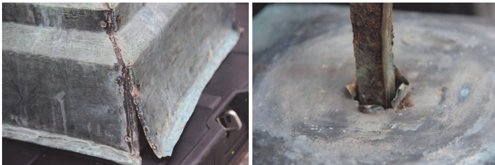
Figur 15. Spruckna falsar på piedestalen över urtavlorna.
