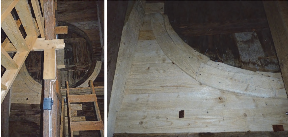
Figur 34. Södra sidans urtavla efter renovering. Foto: Helén Sjökvist.
