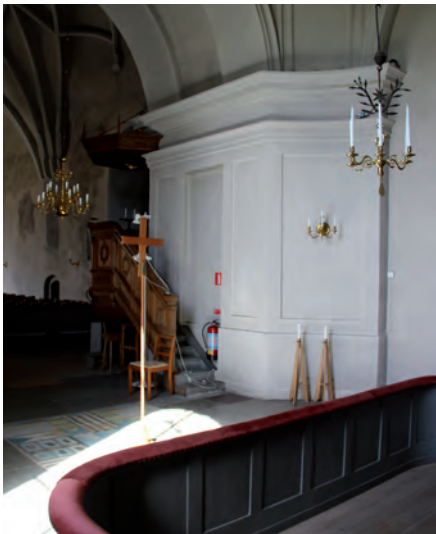
Figur 15. På samma parti tillkom ytterligare en kabel. Foto: Tobias Mårud.
