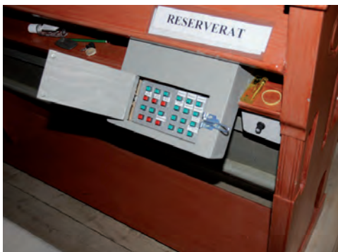
Figur 18. Ny manöverpanel för belysning, sedan tidigare befintligt ljudreglage är den högra mindre lådan. Foto: Svensk Klimatstyrning AB.
