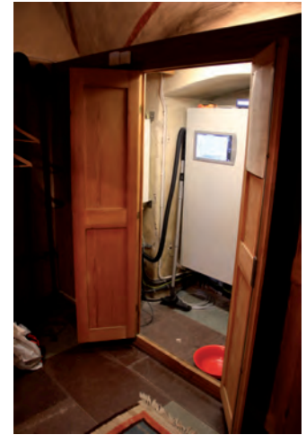
Figur 9. Det nya styrskaftet är på plats och vänster om det har den tidigare mellanväggen anläggats. Foto: Tobias Mårud
