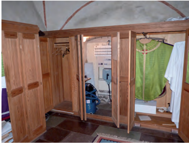
Figur 8. Sakristians skåpinredning innan åtgärd. Foto: Tobias Mårud.
