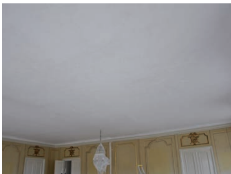
Figur 50. Taket under pågående restaurering. Foto: Tobias Mårud.
