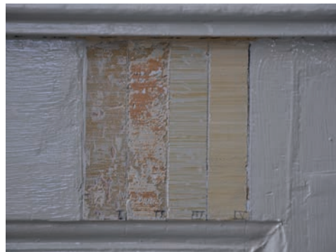
Figur 10. Färgstegen tas fram vid skrapningen av fönsternischerna. Foto: Lisa Skanser.
