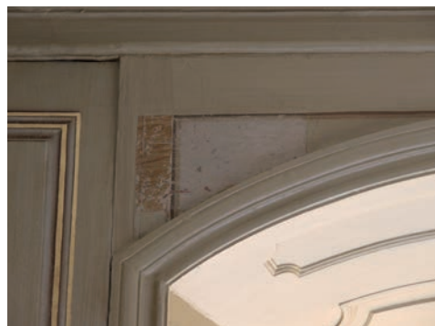
Figur 8. Den tidigare okända fältindelningen ovanför fönstren rekonstruerades. Här den referensyta som lämnades, fotograferad vid grundmålning. Foto: Tobias Mårud.
