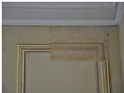
Figur 51. Tidigare referensyta som visar väggarnas äldre fältindelning bevarades givetvis vid restaureringen. Foto: Tobias Mårud.
