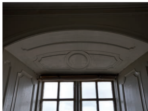
Figur 6. Överstykke efter skrapning. Visade sig vara gipsstuckatur. Överstykets på bilden, det västligaste i rummets sydvästra vägg, uppvisade en kraftig spricka. Foto: Lisa Skanser.
