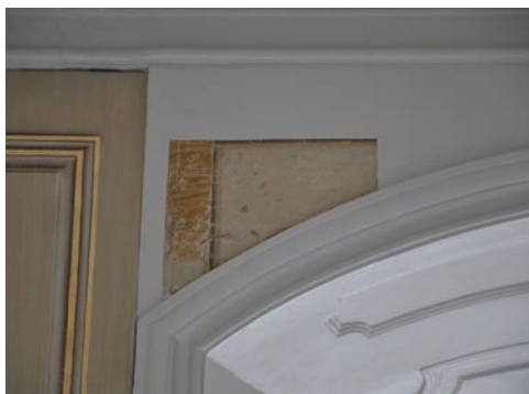
Figur 8. Den tidigare okända fältindelningen ovanför fönstren rekonstruerades. Här den referensyta som lämnades, fotograferad vid grundmålning. Foto: Tobias Mårud.
