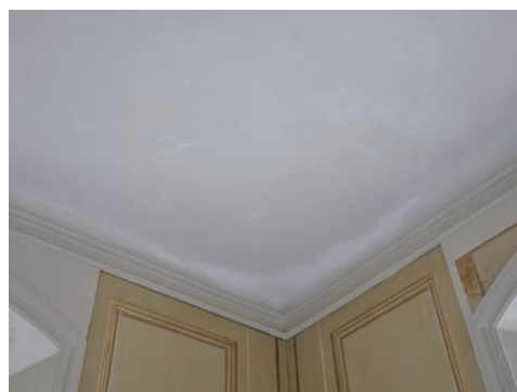
Bild 16. (Övre vänstra) Skada i hörnet mellan sydvästra och sydöstra väggarna. Foto: Lisa Skansen.
