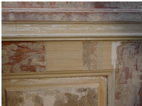
Figur 10. Färgstegen tas fram vid skrapningen av fönsternischerna. Foto: Lisa Skanser.
