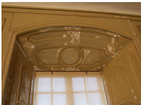
Figur 6. Överstykke efter skrapning. Visade sig vara gipsstuckatur. Överstykets på bilden, det västligaste i rummets sydvästra vägg, uppvisade en kraftig spricka. Foto: Lisa Skanser.
