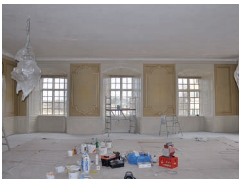
Figur 12. Stora Salen under pågående slipstrykning. Foto: Tobias Mårud.
