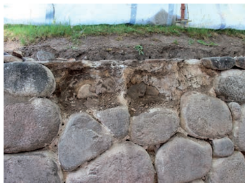
Figur 11. Avlägsnande av fog pågående, cementkakan under krönet framgår tydligt. Foto: Tobias Mårud.
