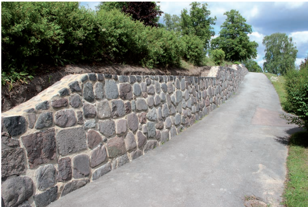
Figur 23. (Övre vänster) En plantering anordnades bakom den övre delen av muren. Foto: Tobias Mårud.
