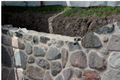
Figur 19. Försänkningen skapade ganska stora nivåskillnader vid trappningarna. Foto: Tobias Mårud.
