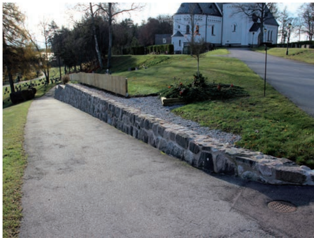
Figur 17. Här har även ytan bakom muren färdigställts. Foto: Tobias Mårud.
