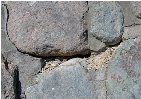
Figur 6. Rester av kalkbruk bakom nedfallen cementfog. Foto: Tobias Mårud.
