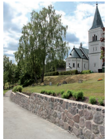
Figur 18. Färdigställd sektion av muren i böjd med trappningens början. Foto: Tobias Mårud.
