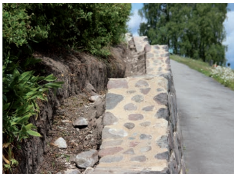
Figur 13. Försänkning innanför muren, själva muren är färdigrestaurerad. Foto: Tobias Mårud.
