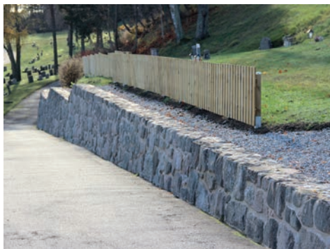
Figur 13. Försänkning innanför muren, själva muren är färdigrestaurerad. Foto: Tobias Mårud.
