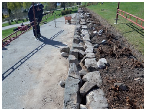
Figur 4. Murkrönet frilagt, spricka synlig i den täckande cementkakan. Foto: Tobias Mårud.
