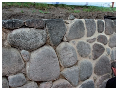
Figur 11. Avlägsnande av fog pågående, cementkakan under krönet framgår tydligt. Foto: Tobias Mårud.
