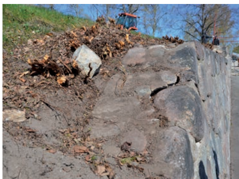
Figur 4. Murkrönet frilagt, spricka synlig i den täckande cementkakan. Foto: Tobias Mårud.
