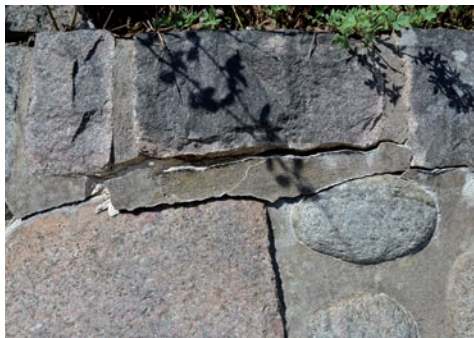
Figur 6. Rester av kalkbruk bakom nedfallen cementfog. Foto: Tobias Mårud.
