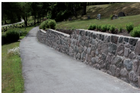
Figur 21. Nedre delen av den restaurerade muren. Foto: Tobias Mårud.
