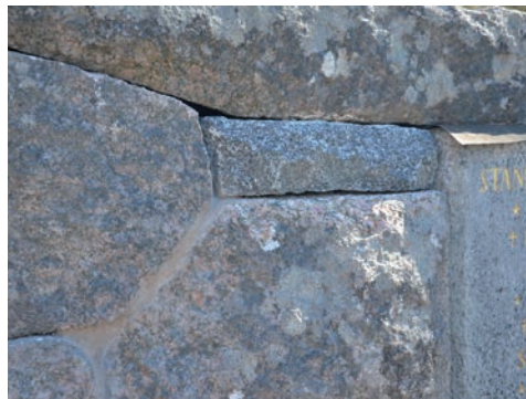
Figur 32. (Övre vänster). Detalj av fogad murspricka. Foto: Tobias Mårud.
