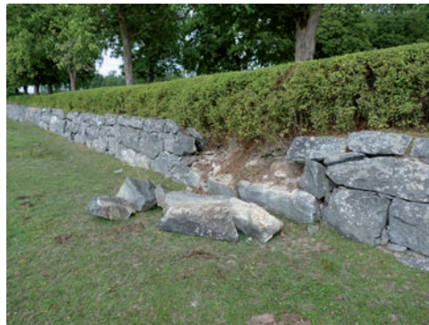
Figur 2. Nedrasat parti av stödmuren som avgränsar kyrkogården mot söder. Foto: Tobias Mårud.
