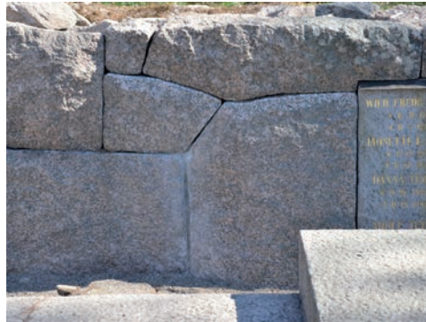
Figur 30. Del av åtgärdad mur, med bruk, bearbetad sten och nytillkommen sten. Foto: Tobias Mårud.
