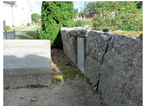
Figur 2. Nedrasat parti av stödmuren som avgränsar kyrkogården mot söder. Foto: Tobias Mårud.
