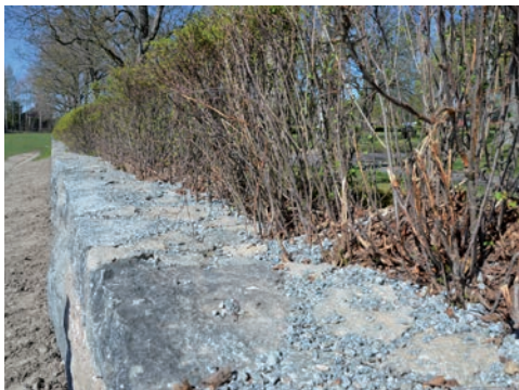
Figur 12. Den nya kröntäckningen är klar. Bakomliggande måbärshäck har återfått sin ursprungliga linje och växer inte längre på murkrönet.
