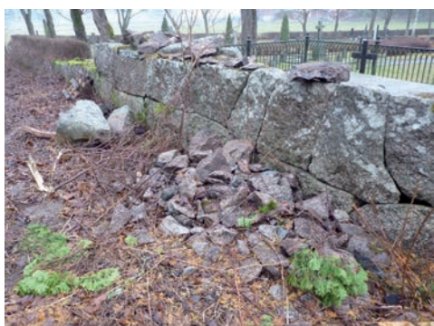
Figur 23. Sparat material från murkärnan ligger på och bakom muren inför återanvändning. Foto: Tobias Mårud.
