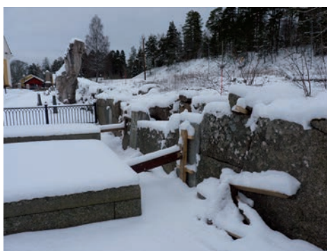
Figur 23. Sparat material från murkärnan ligger på och bakom muren inför återanvändning. Foto: Tobias Mårud.
