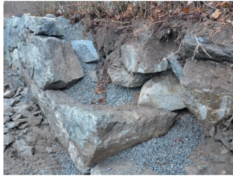
Figur 8. Sektion där yttreskalmuren och murkärnan anlägsnats, med bakre skalmuren blottlagd. Foto: Tobias Mårud.
