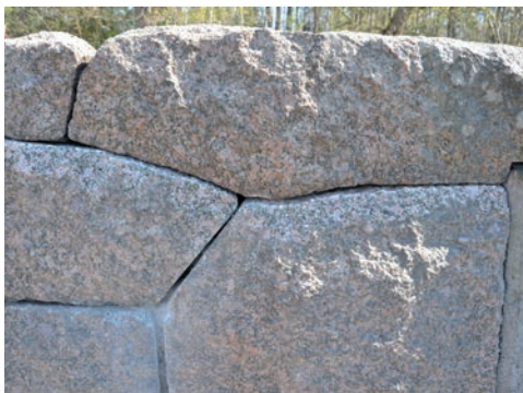
Figur 32. (Övre vänster). Detalj av fogad murspricka. Foto: Tobias Mårud.
