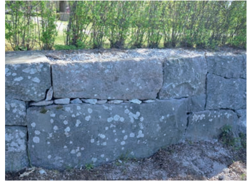
Figur 14. Krönstenen på den västra delen av muren lyftes tillbaks på plats. Foto: Tobias Mårud.
