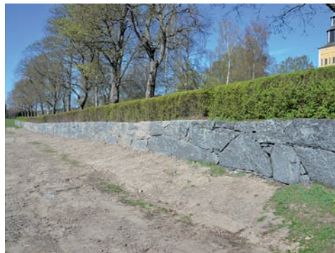
Figur 12. Den nya kröntäckningen är klar. Bakomliggande måbärshäck har återfått sin ursprungliga linje och växer inte längre på murkrönet.
