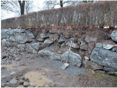
Figur 8. Sektion där yttreskalmuren och murkärnan anlägsnats, med bakre skalmuren blottlagd. Foto: Tobias Mårud.
