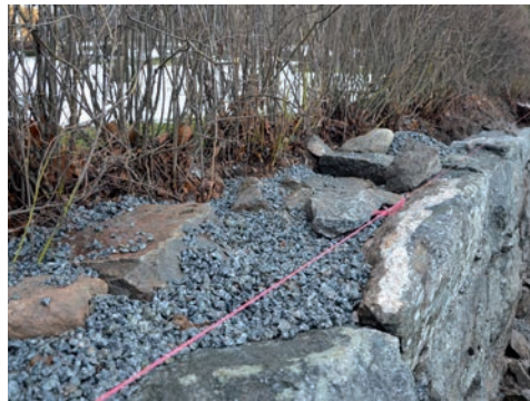
Figur 9. Övergång från åtgärdad sektion visar singlet i nya murkärnan. Fot: Tobias Mårud.
