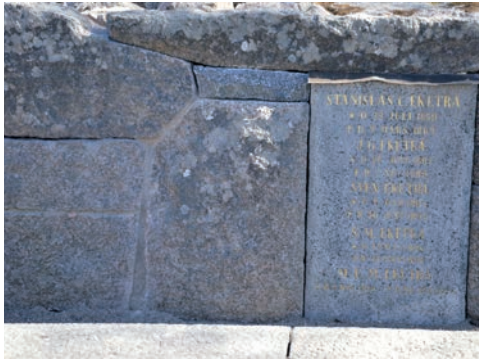
Figur 30. Del av åtgärdad mur, med bruk, bearbetad sten och nytillkommen sten. Foto: Tobias Mårud.
