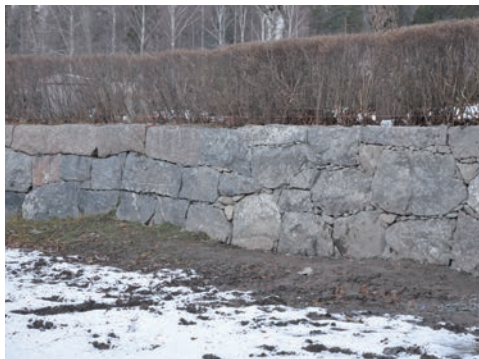
Figur 16. Den något ojämna övergången mellan den restaurerade muren och den västra delen. Foto: Tobias Mårud.
