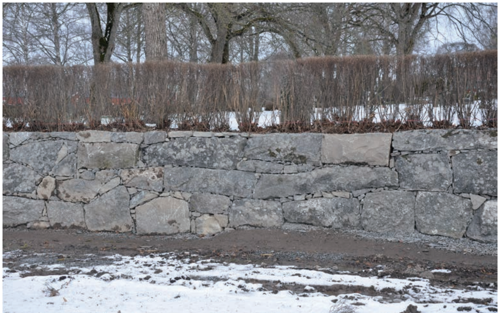
Figur 18. Sektion av det färdigrestaurerade murverket. Foto: Tobias Mårud.
