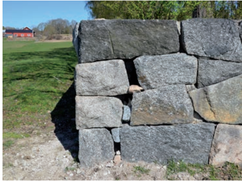
Figur 14. Krönstenen på den västra delen av muren lyftes tillbaks på plats. Foto: Tobias Mårud.
